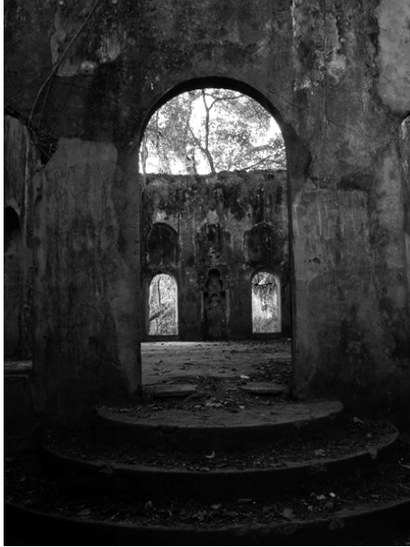
L'escalier encourage à accéder à la mosquée mais seuls demeurent des murs dégradés et le souvenir d'une salle de prière encore fréquentée par les croyants au début du XX e siècle (© Caligaris)
