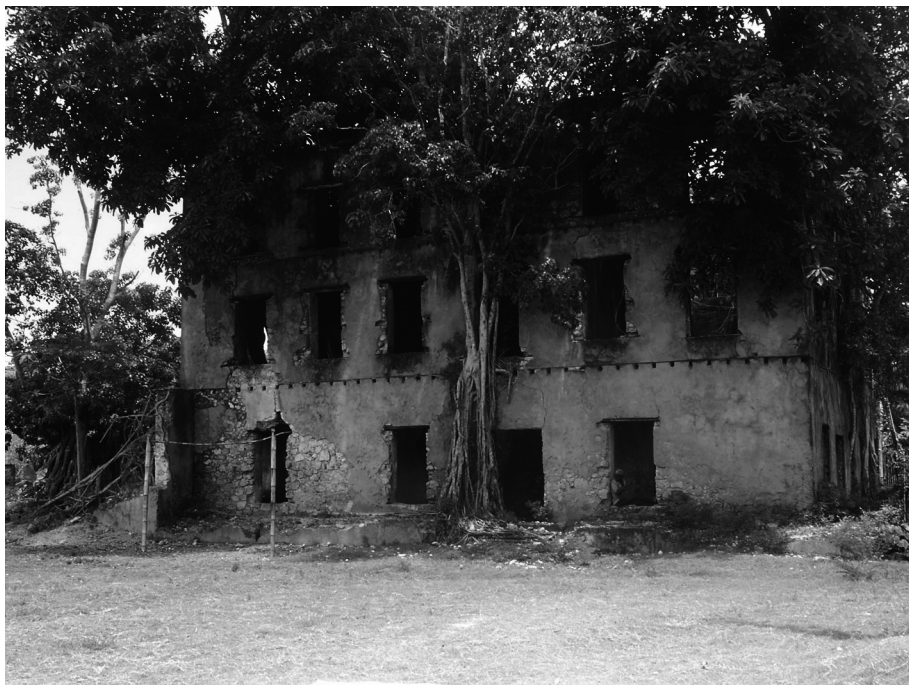
FIGURE 5 : RUINE D'UNE MAISON PARTICULIÈRE À DEUX ÉTAGES, AMBANORO
