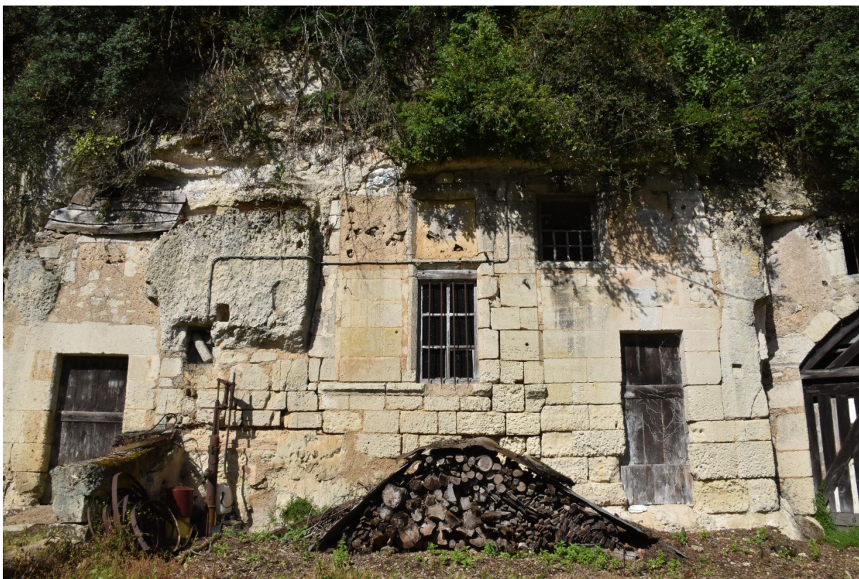
Figure 34 : L'habitation troglodytique de la Cochetière à Villavard
