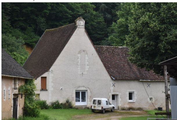
Figure 23 : La chapelle au Grand Ri à Fontaine-les-Coteaux
