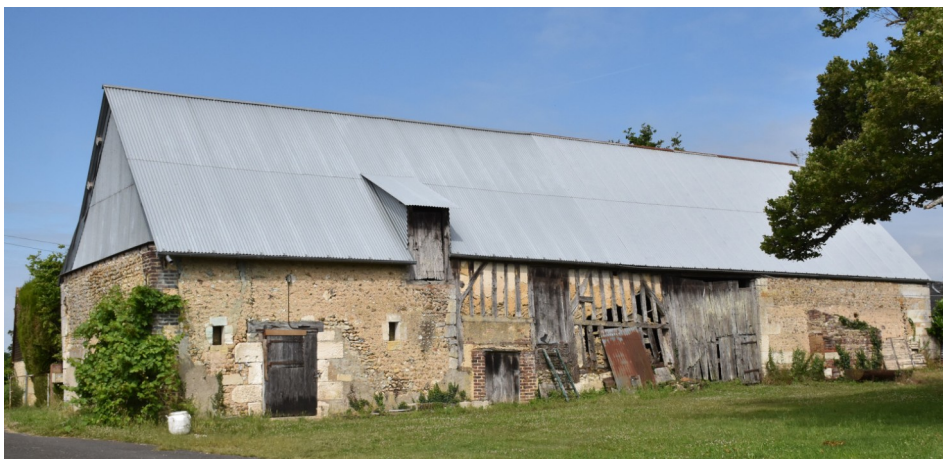
Figure 13: La grange de la Dianière (Fortan), conservant un noyau d'origine en pan de bois agrandi de chaque côté.
