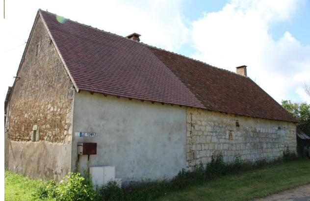
Figure 21 : Vestiges des édifices médiévaux de la commanderie de Villavard (ci-dessus)
