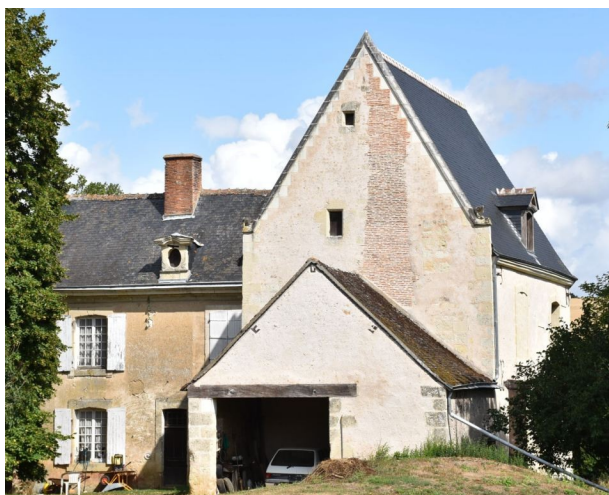
Figure 22 : Le logis du prieuré de Croixval à Ternay
