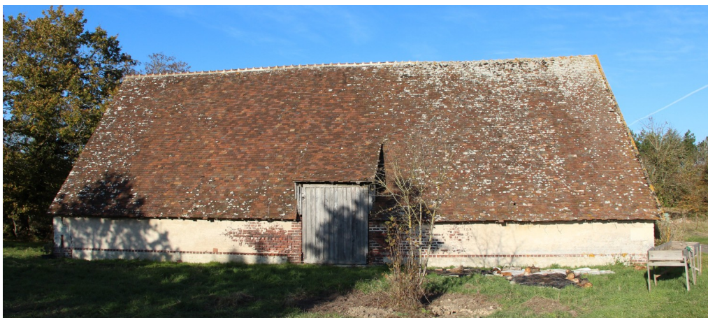
Figure 12 : Exemple de grange à la Charterie (Saint-Arnoult) dont les maçonneries ont été entièrement refaites au 20 e siècle
