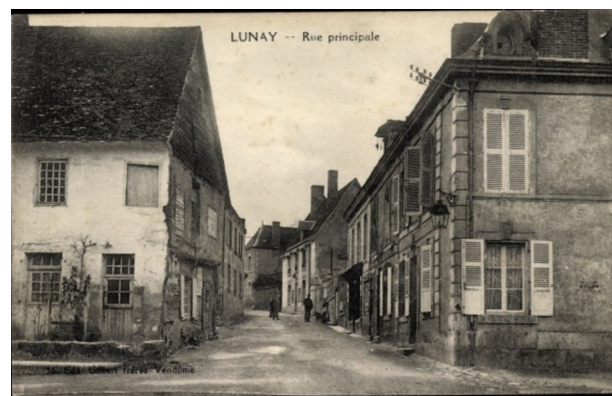
Figure 30 : Maison en pan de bois démolie à Lunay (source : Delcampe)
