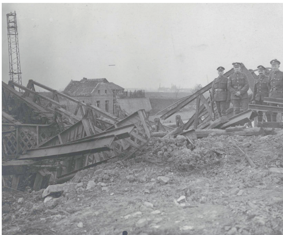
Fig. 2 : Un pont détruit par les Allemands avant leur retraite à Corbehem, 5 km au sud de Douai. 31 octobre 1918 (coll. La Contemporaine VAL 301/010).
