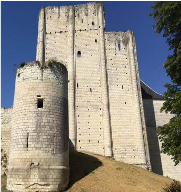
Fig. 10 - Photographie de la face est de la tour maîtresse avec la "butte" de terre sur laquelle les fondations des contreforts s'adaptent (P. Papin - Sadil).
