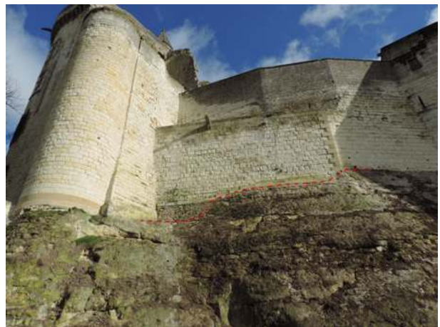
Fig. 20 - Photographie de la porte des Roches sur le front sud-est, installée dans une dépression du rocher (P. Papin - Sadil).
