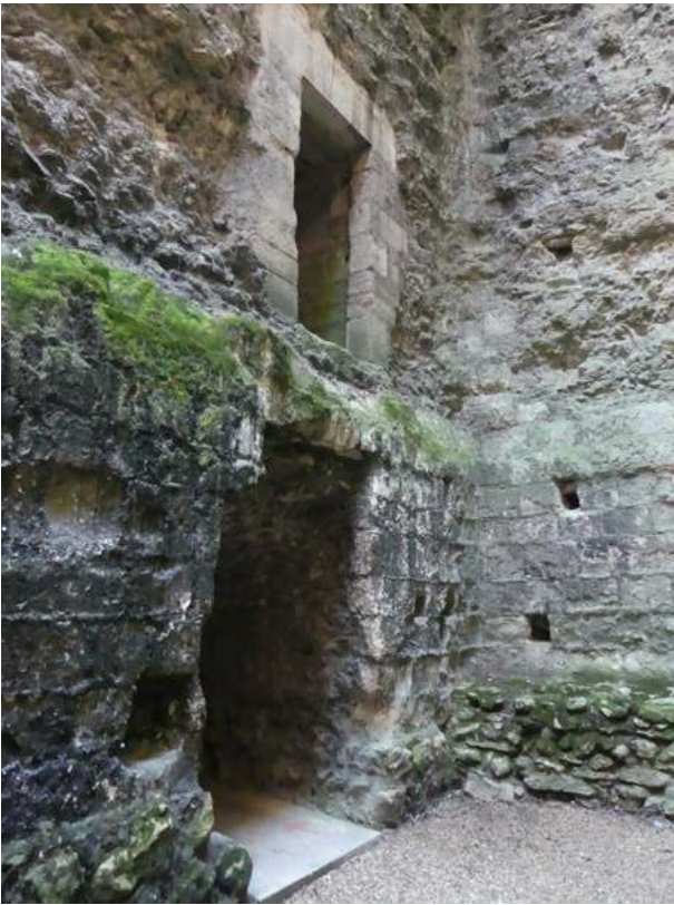
Fig. 8 - Photographie des accès récents percés entre la petite et la grande tour (P. Papin - Sadil).
