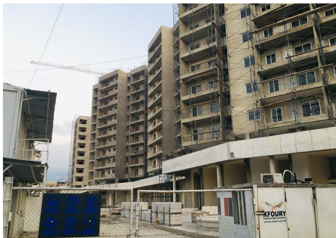
Photo 1. Ensemble résidentiel en accession à la propriété construit par la Municipalité de Bourj Hammoud (Liban)
