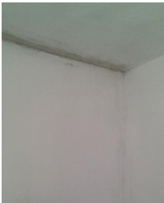
Figure 10. Infiltration d'eau par le toit terrasse. Les Aubiers – Résidence du Lauzun
