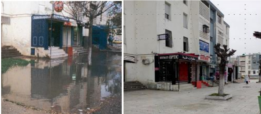
Photos 1 et 2 : La cité 1276 logements (en 2004) submergée par les eaux de pluies et actuellement (2018) après la rénovation du réseau d'assainissement (Source, Mebirouk, 2004 et auteur 2018).
