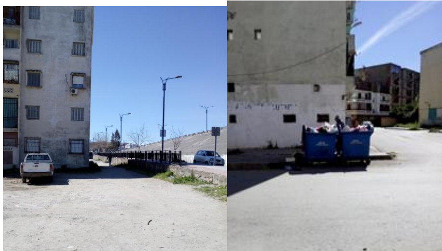
Photos 14 et 15 : Aménagement rudimentaire d'un espace public de la Cité Oued-Edheb limité au revêtement de la chaussée. (Auteur, 2018)
