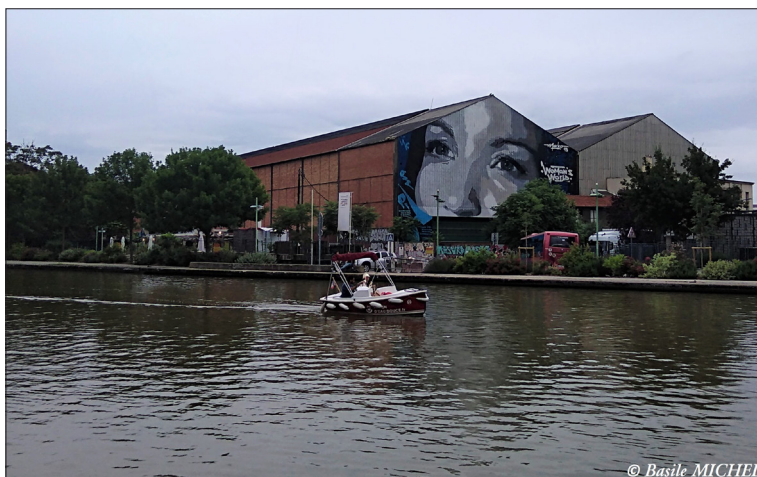
Photographie 14 : Les Grandes-Serres de Pantin au bord du canal de l'Ourcq
