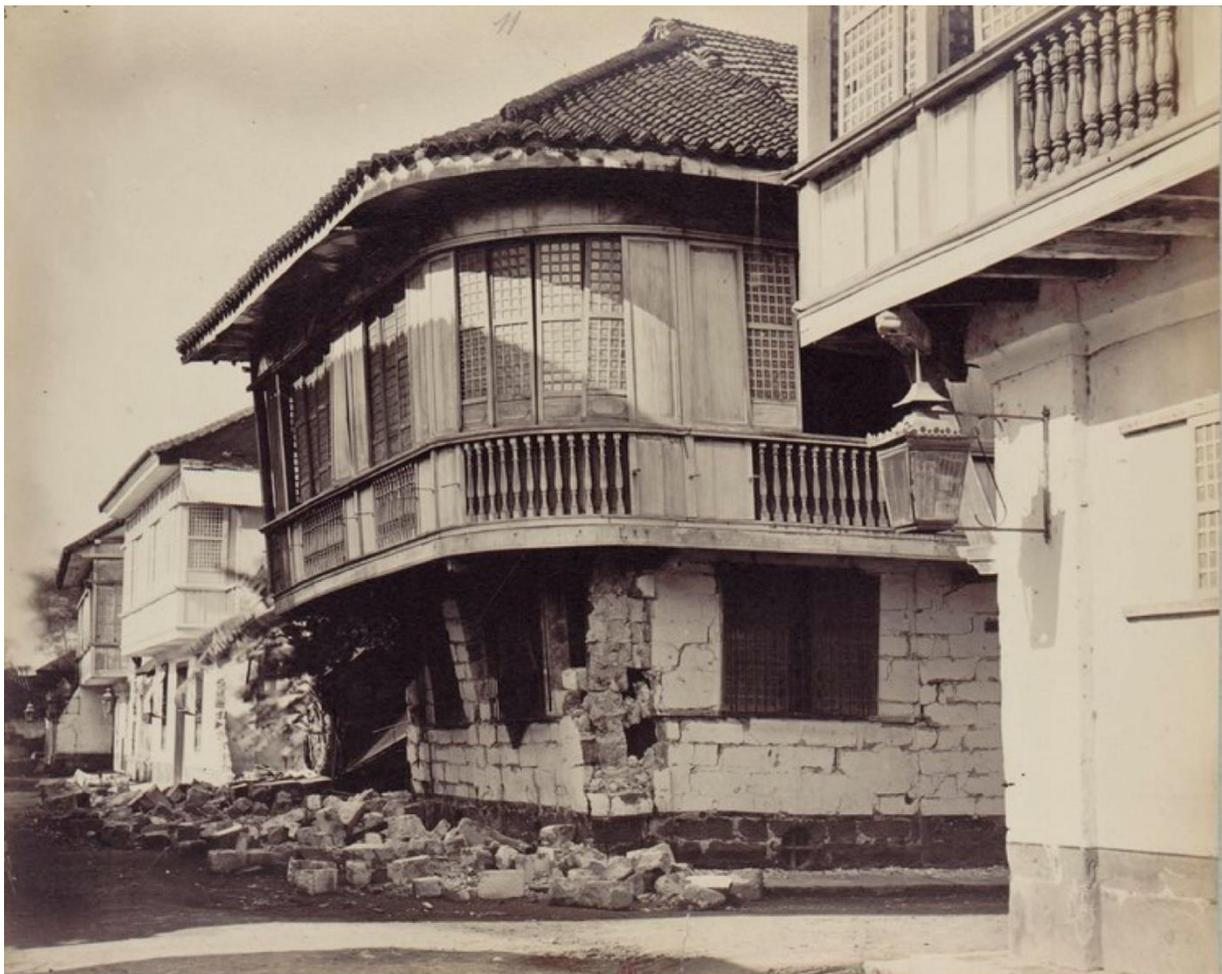
**Fig.3** - Une maison de maçonnerie à l'angle de la rue Centeno, dans le quartier de Santa Cruz. La photographie a été prise peu de temps après les séismes des 18 et 20 juillet 1880. Les murs de maçonnerie du rez-de-chaussée se sont effondrés, mais l'étage et la toiture supportés par les poteaux de fond ont résisté aux secousses.
