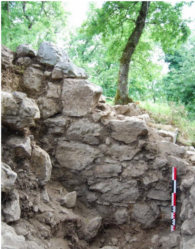
Fig. 66. Parement externe du mur MR5004 (pièce PCE6) clôturant le côté nord de l'espace ESP7. Crédit : T. Lasnier.
