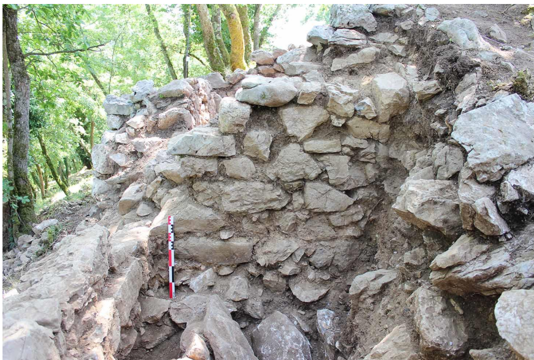
Fig. 63. Dégagement partiel des ruines de la pièce PCE6 jusqu'à ses fondations.
