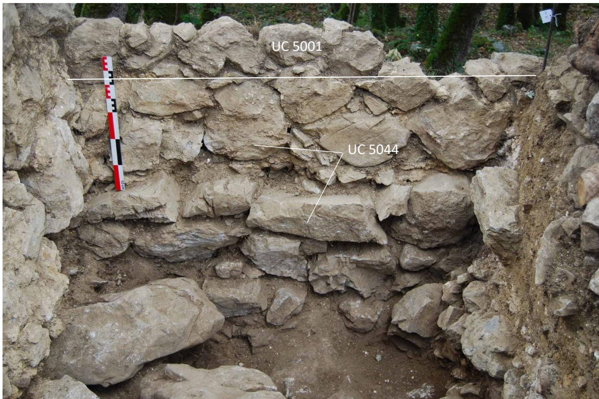
Fig. 58. Soubassement interne du mur MR5001, reposant sur le lapiaz, et comportant un ressaut (UC 5044 - PCE5), avec vestiges de départ d'élévation (UC 5001 - PCE5). Crédit : T. Lasnier.
