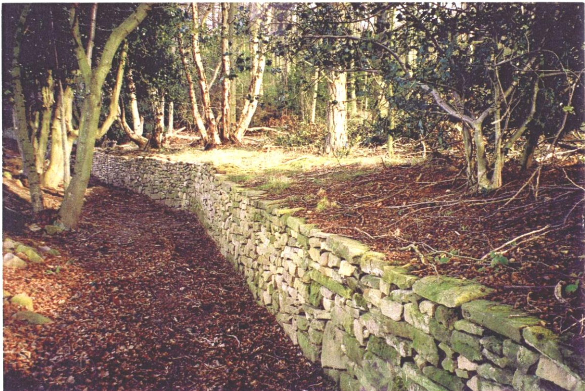
Fig.7 – Restauration du Ha-ha (Angleterre)
