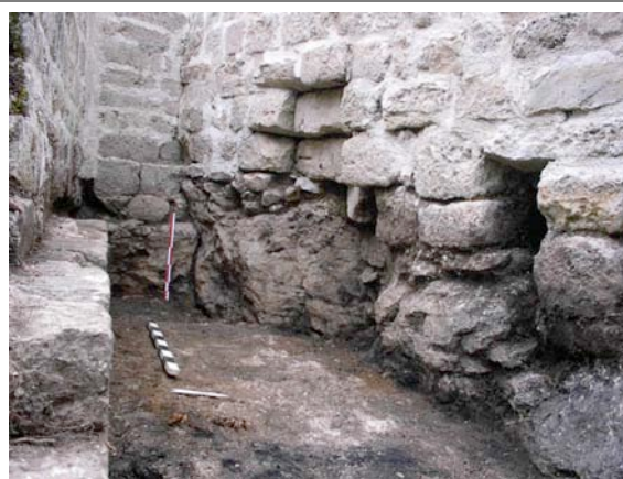
Cliché est du ressaut et de la réservation.
