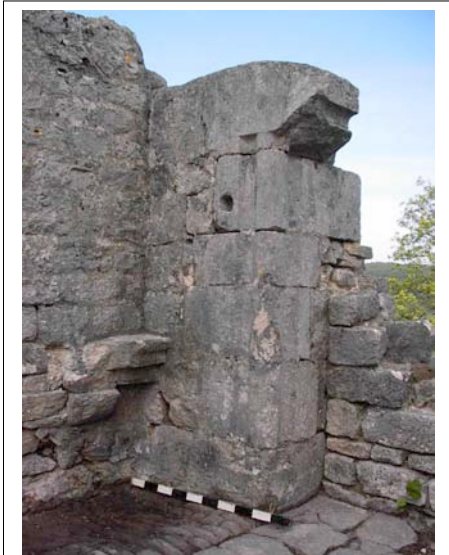
Cliché du piédroit nord de la CHE 414 .
