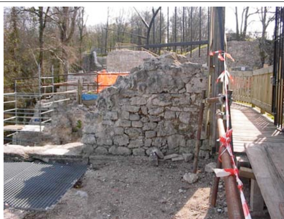
Cliché sud du MUR 321 .
