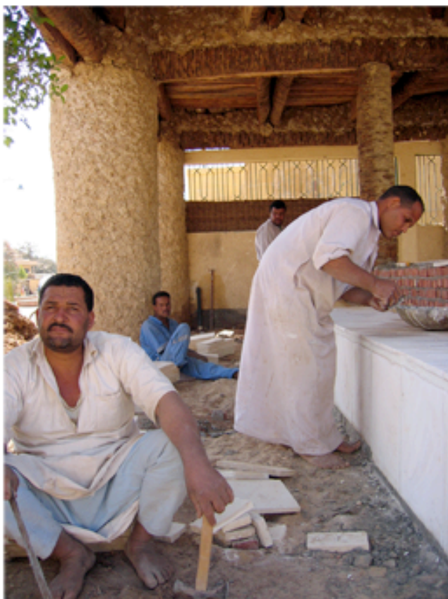
Néo-tradition siwi : construction de la nouvelle gare routière de Siwa (19 mars 2005). (Vincent Battesti)
