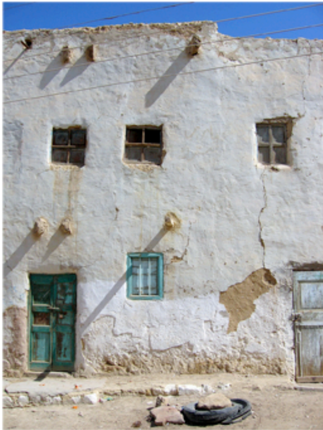
Ancienne maison en tlaght peinte de chaux en contrefort du vieux Shâli (21 fév. 2006). (Vincent Battesti)
