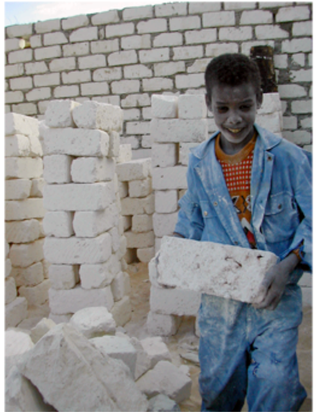
Construction en tôb blanc d'une nouvelle marbu'a (10 janv. 2004). (Vincent Battesti)
