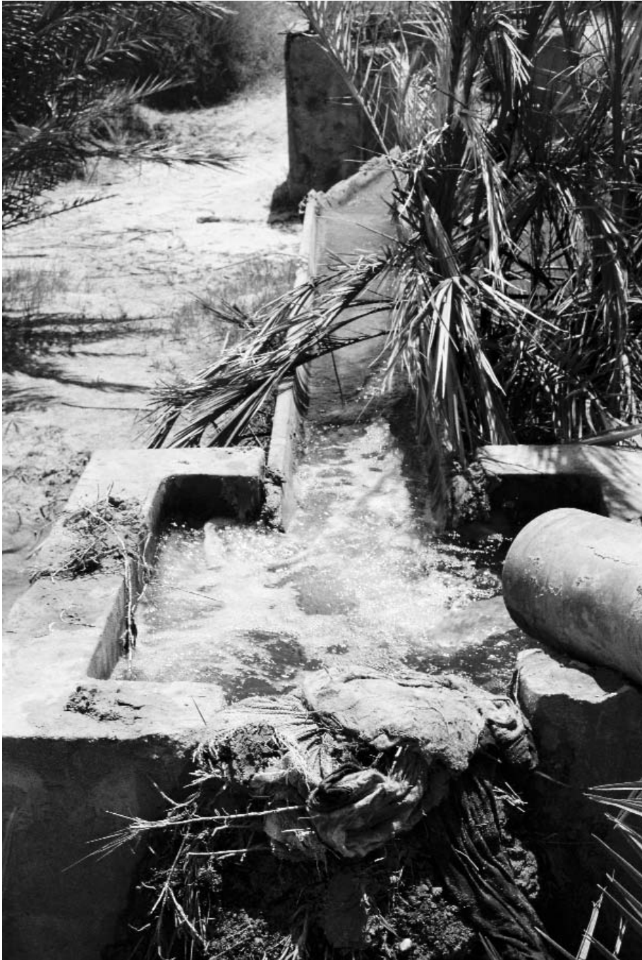
Réseau d'eau étatique bricolé. Juillet 1995, Nefta (Tunisie). Une partie du réseau d'eau installé par l'État à Nefta est enterrée, une autre aérienne. Les jardiniers se les réapproprient partiellement en les « bricolant ».
