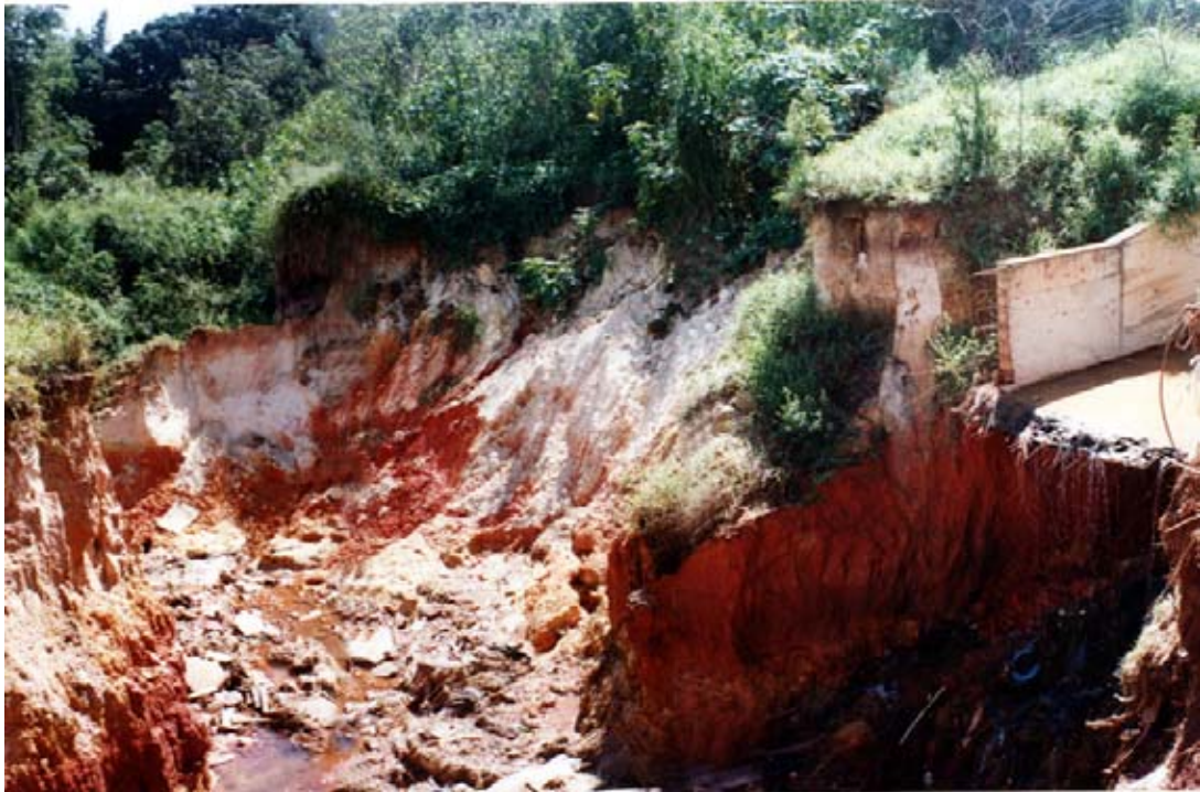
Photo 28 : Erosion sur le Riacho Fundo.
