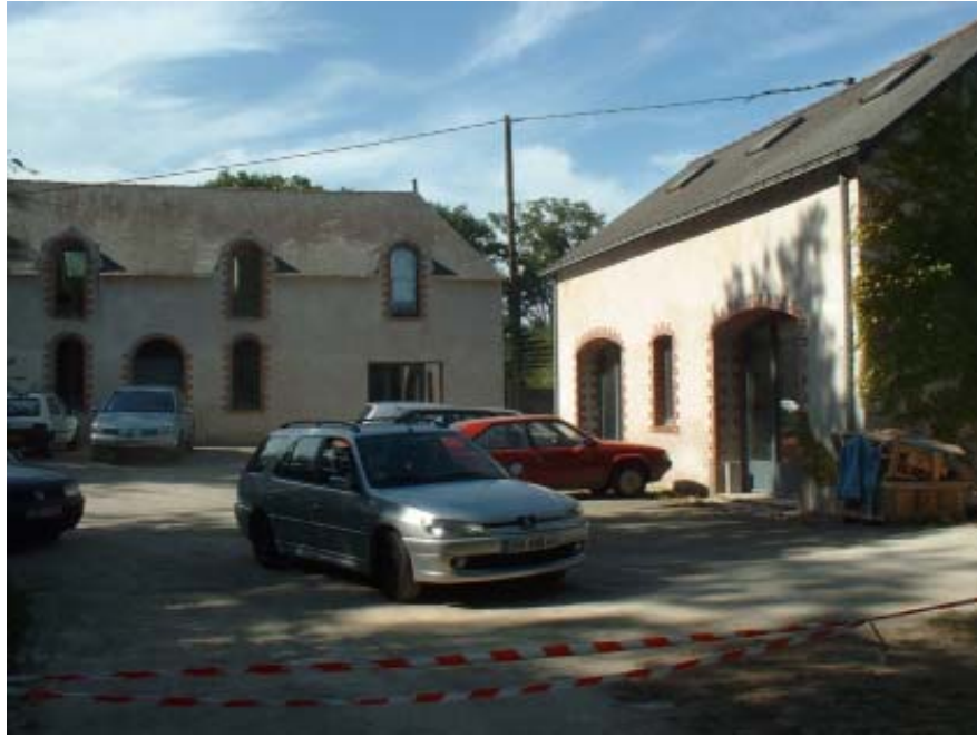
Photo 117 : Les anciens communs du château de la Fleuriaye offrant des ateliers et des logements pour les artistes en résidence, Carquefou Cliché : Teodoro Gilabert (2003)
