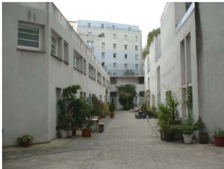
Photo 38 : Ateliers - logements gérés par la ville de Paris ( Rue Darius Milhaud XIXème arrondissement)
