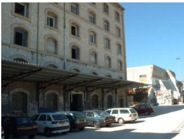
Photo 53 : Un des bâtiments de l'ancienne manufacture des tabacs, Marseille Cliché : Teodoro Gilabert (2002)
