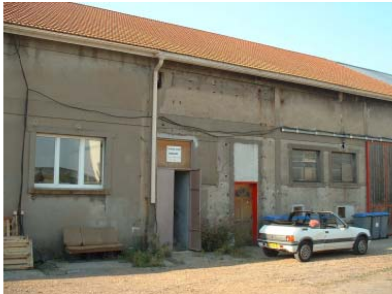
Photo 134 : Vue de l'extérieur des ateliers des frères Paulico et de Tanaquil Pétry, Nantes
