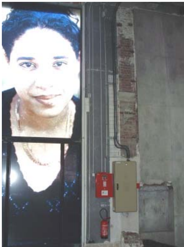
Photo 111 : On a retiré volontairement les revêtements muraux du Palais de Tokyo pour laisser apparaître le béton, Paris Cliché : Teodoro Gilabert (2002)
