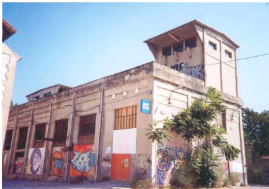
Photo 99 : Un ancien transformateur d'EDF de 500m 2 a été réaménagé en un immense laboratoire de formes et d'images, faisant appel aux technologies nouvelles, autour de l'idée de la métamorphose du corps, Avignon (Vaucluse)
