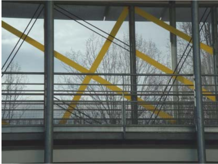
Photo 147 : Assemblage n°3, IS 0013.21, 2003-2004 (passerelle entre deux bâtiments du lycée Aristide Briand), Saint-Nazaire
