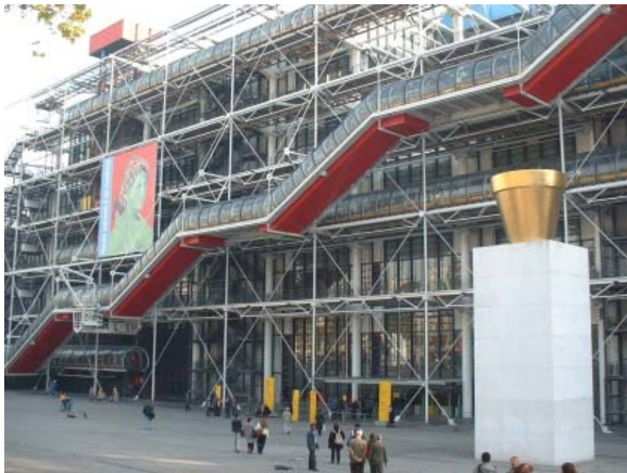
Photo 51 :Le Centre Pompidou, dont l'architecture constitue elle-même une gigantesque culture contemporaine monumentale, au cœur de Paris. Au premier plan le Pot Doré de Jean-Pierre Raynaud, installé sur la piazza depuis 1998 (après avoir circulé de Jouy-en Josas (1985) à Pékin (octobre 1996), en passant par Berlin (mai 1996)).
