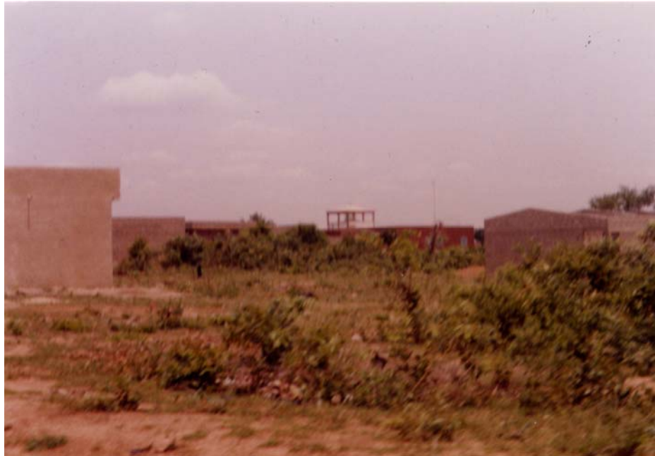
Photo 13 : Habitat individuel en construction au quartier résidentiel à Korhogo juillet 2002, cliché de l'auteur.
