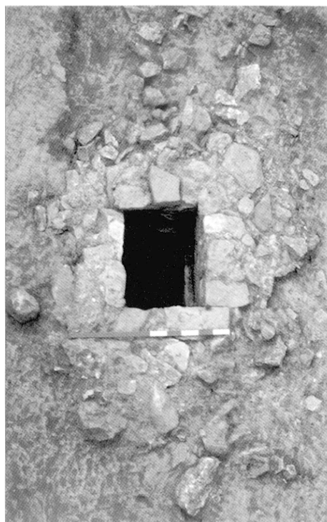
Fig. 117 – Aqueduc du Traversan : le regard 1, le plus à l'amont, intégralement conservé (cliché P. Poupet, CNRS et R. Harfouche).
