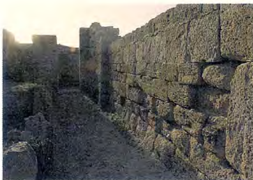
Qal'at al-Bahreïn, secteur du « Palais d'Oupéri », Rue et porte monumentale.
