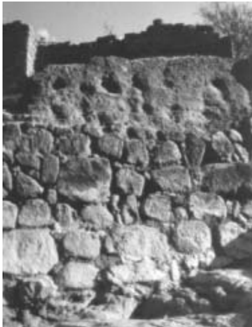
Illustration 1 : Muraille mixte à Vascos (base en pierres, sommet en tapial )
