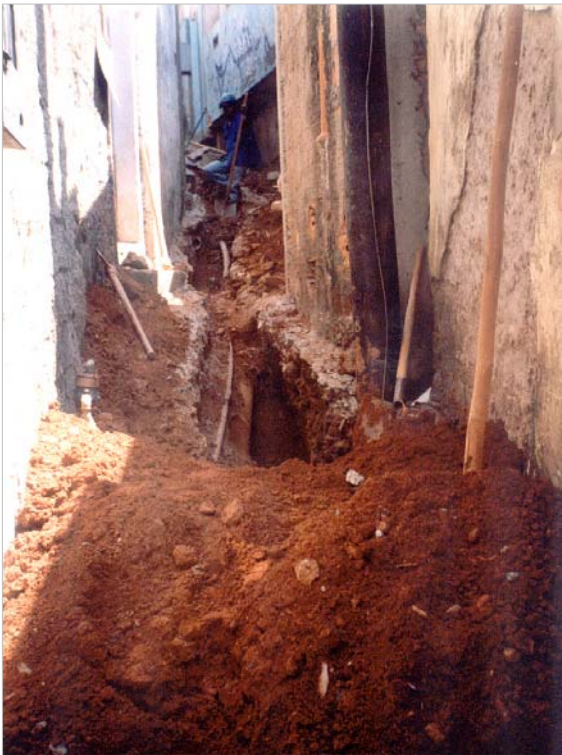
Figure 7: Exemple de travaux d'assainissement dans les favelas effectués d'après l'OP bassin versant Vitoria (photo COPASA 2005).
