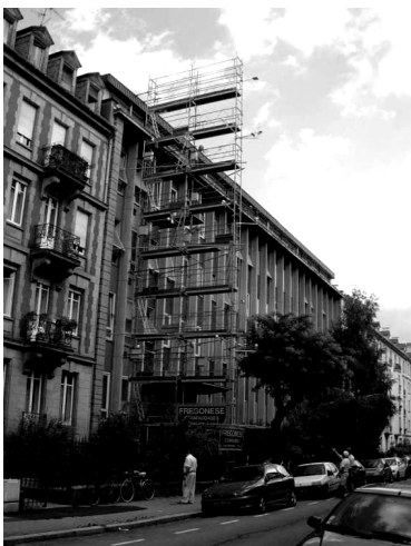
Figure 1 : Echafaudage mis en place rue de l'Argonne (Strasbourg).
