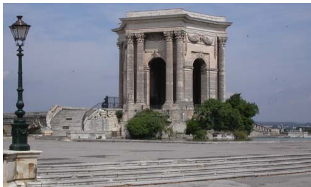
Figure 2 : le château d'eau du Peyrou
