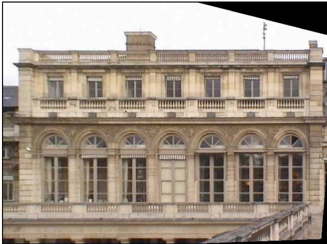
Fig.4. Image rectifiée de la façade du Palais Royal
