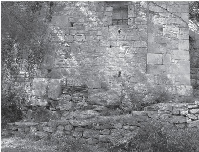
Fig. 10: Substruction de gros blocs sur laquelle s'appuie le mur en petit appareil de la nef romane (à gauche) et repose la travée de plan barlong ainsi que le chevet (à droite) (cliché J.-L. Fiches).
