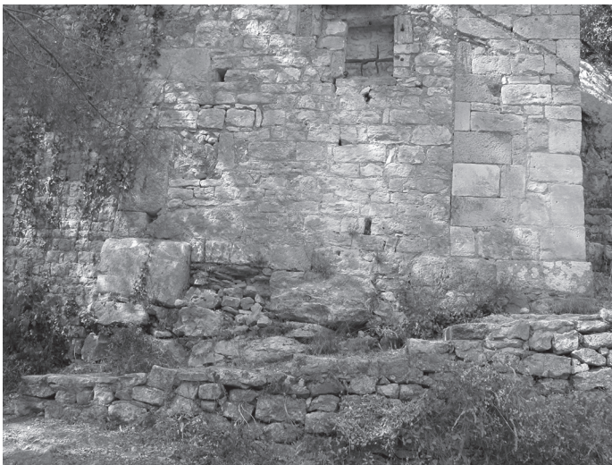
Fig. 10: Substruction de gros blocs sur laquelle s'appuie le mur en petit appareil de la nef romane (à gauche) et repose la travée de plan barlong ainsi que le chevet (à droite) (cliché J.-L. Fiches).
