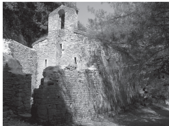
Fig. 8 : La nef romane raccourcie à la fin du XVII e s. par un mur transversal, surmonté d'un clocher-arcade (cliché J.-L. Fiches).
