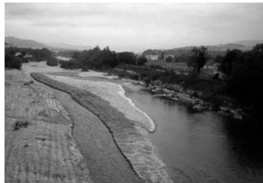
Photographie 4 – Essartage, dessouchage, scarification et tranchée de re-mobilisation dans une zone endiguée (cliché N. Landon, 2003)
