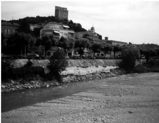
Photographie 3 – Déchaussement de la Digue de Crest (cliché N. Landon, 1996)
