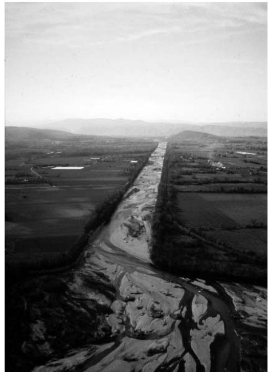
Photographie 2 - Endiguement de la Drôme dans sa basse vallée à l'aval de Crest (cliché N. Landon, 1995)
