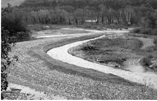
Photographie 5 - Essartage, dessouchage, scarification et tranchée de re-mobilisation dans un banc de convexité d'un méandre (cliché N. Landon, 2003)
