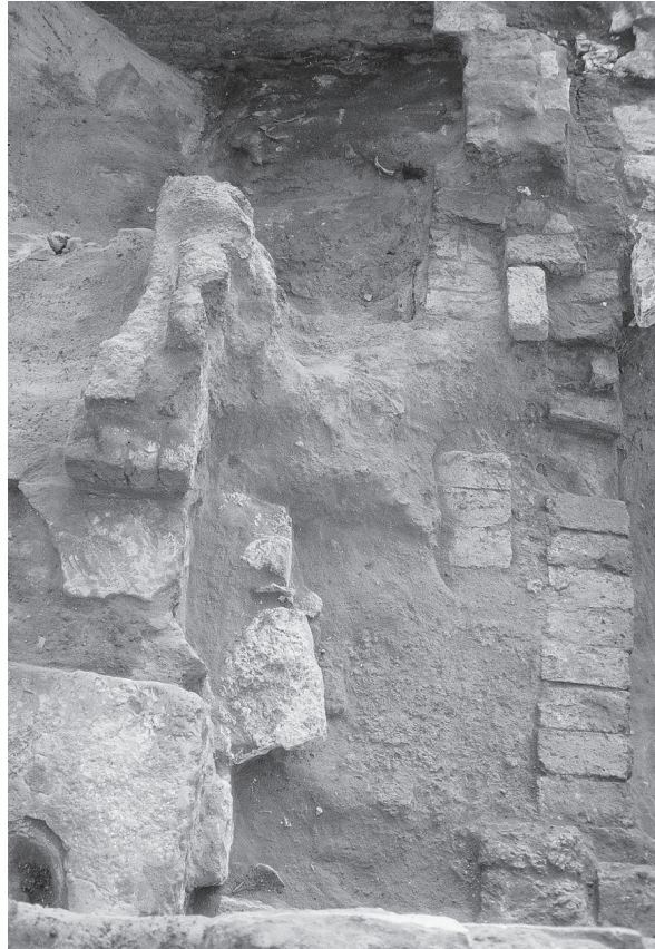
13. L'escalier au nord de la pièce 13 et le mur de chaînage X171. Vue de l'ouest.
