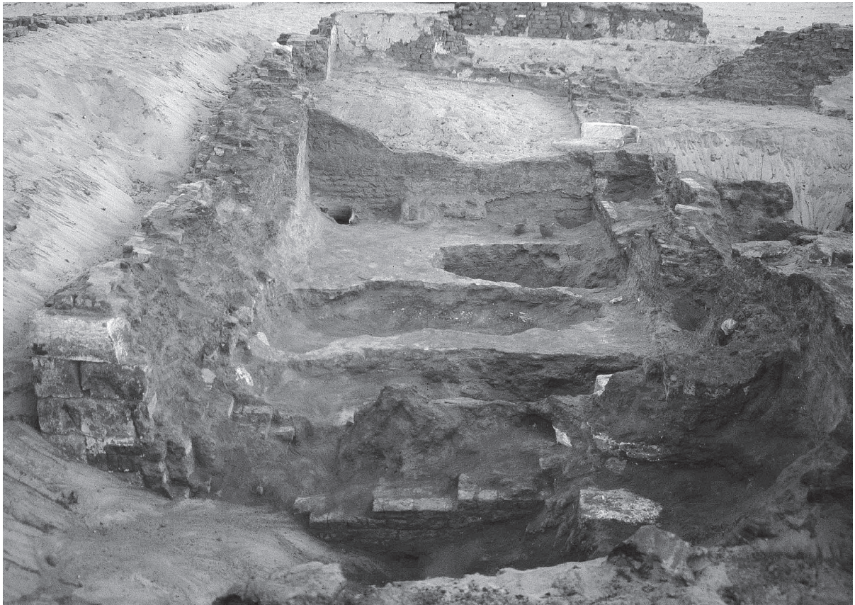
26. Sol X95 (état 3-4), pièce 10. Vue du sud.
