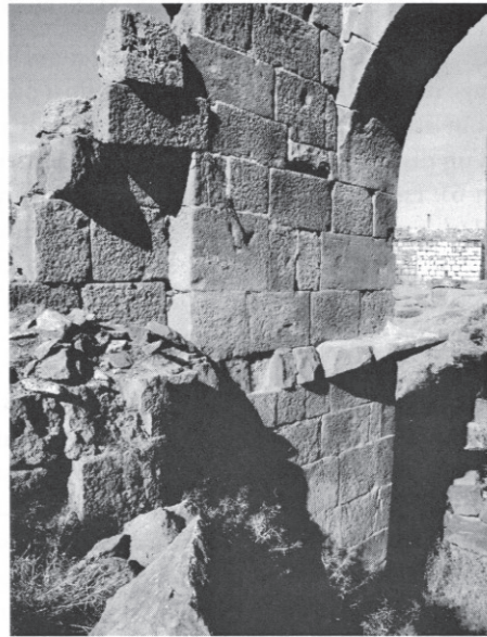
Fig. 4-5 - Salle de chauffe nord-ouest, emplacement de la chaudière du caldarium e, depuis le nord-ouest (4) et le nord-est (5) (cl. Th. Fournet).
