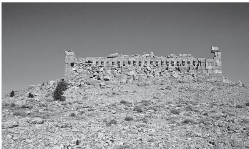
Fig. 12 Galerie effondrée au sud de l'ensemble architectural proto-byzantin.
