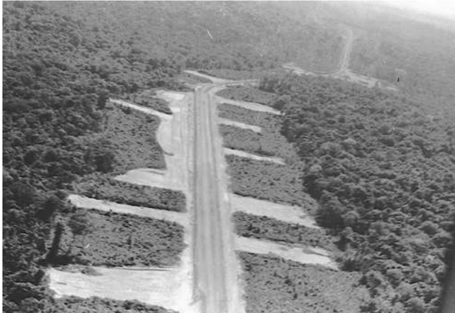
Photo 9 : Vue aérienne du chantier de la Perimetral Norte en 1975 136 .
