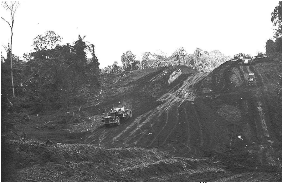
Photo 11 : les difficultés du chantier 140 .
