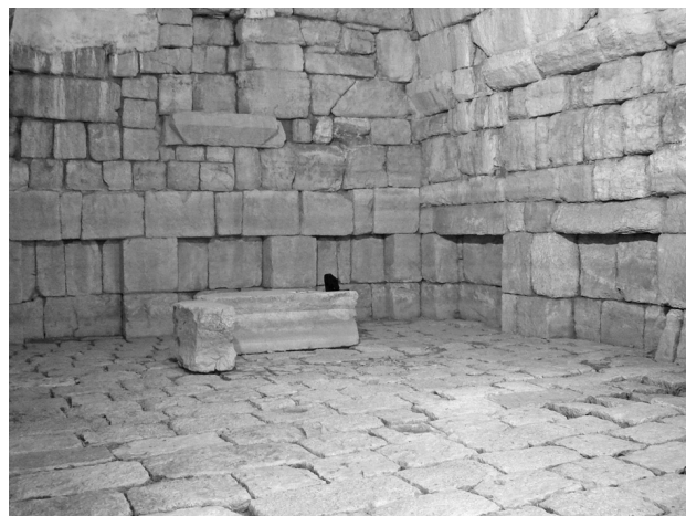
Figure 10 : Réservoir antique englobé dans la station de captage, en contrebas du site (photo Kh. Kiwan, 2007).
