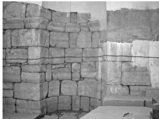
Figure 9 : Vestiges de l'exèdre englobée dans la station de captage, en contrebas du site (photo Kh. Kiwan, 2007).
