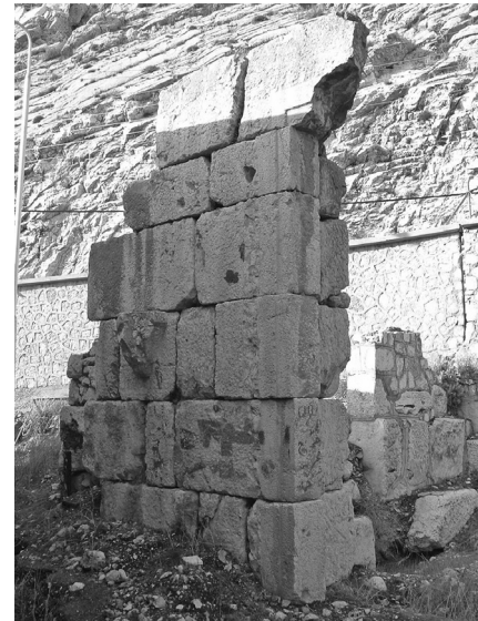
Figure 7 : Façade du temple, vue du sud (photo I. Omeri, 2003).
