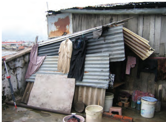
Abri de 1,5 m 2 sur le toit terrasse du cinéma Heam Cheat, centre-ville.
