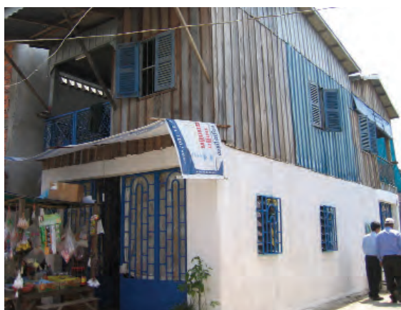
Travaux récents de surélévation à Prek Tanou.
