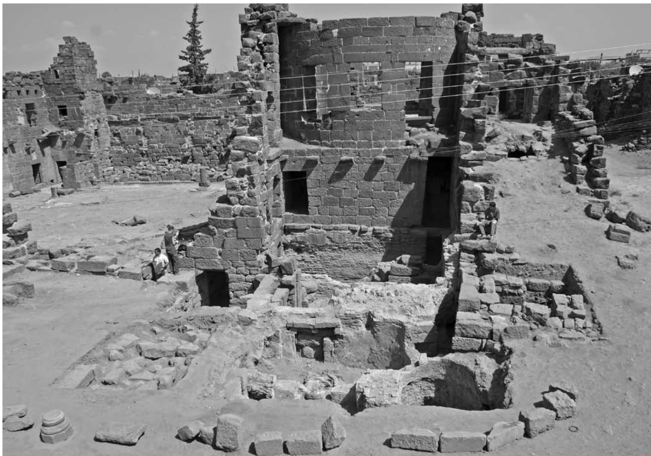
Fig. 3 Vue d'ensemble du chantier en cours de fouille, des bains et du palais, vers l'est.
