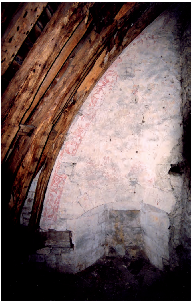
Fig. 9 : Bandeau de peintures rouges suivant le profil de la voûte.
