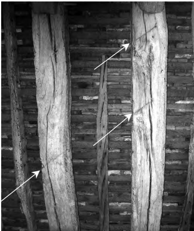
Fig. 35 : Grange Saint-Lazare de Beauvais (1220d) : traces d'ébauchage sur des chevrons.
