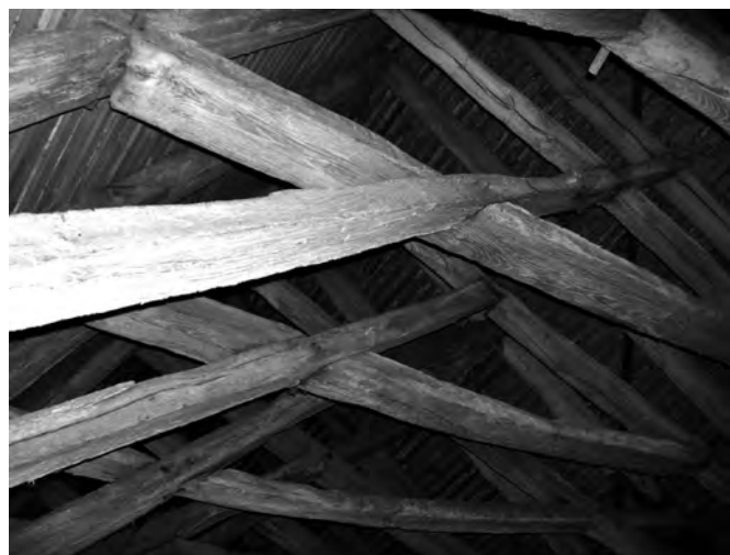
Fig. 43 : Écharpes et entrails retroussés taillés dans des bois fendus à la hache, chapelle de Chanu (1183-1192d) dans l'Eure.
