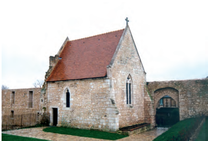
Fig. 2 : Vue sud-est de la chapelle, après restauration.
