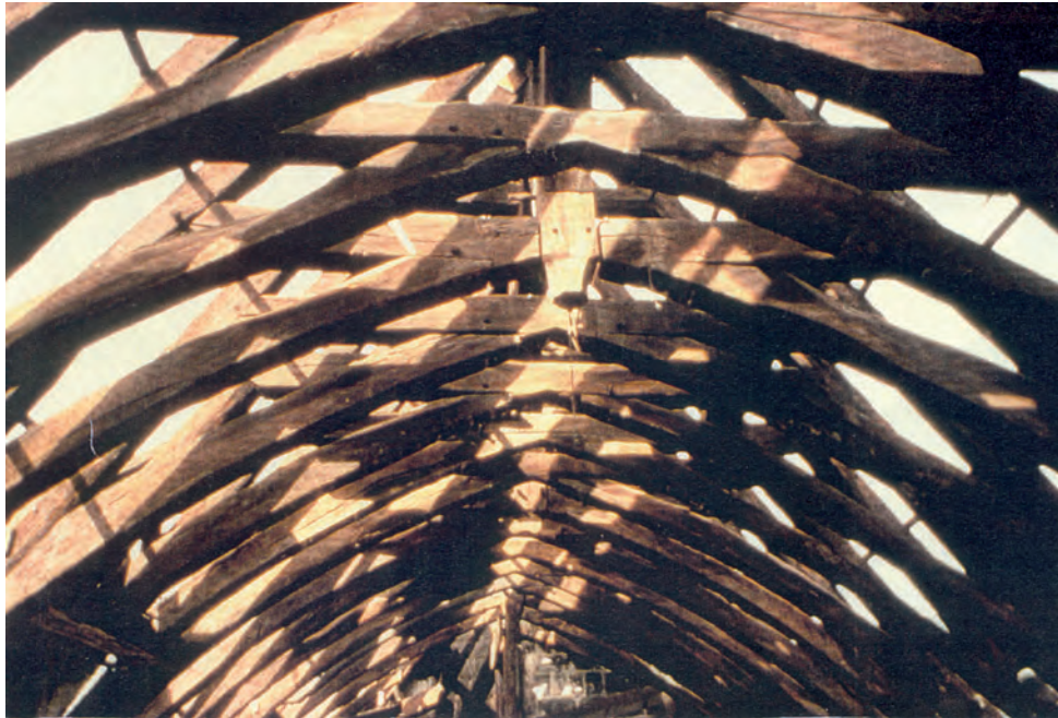
Fig. 5 : Charpente du comble (cl. Ratier).
