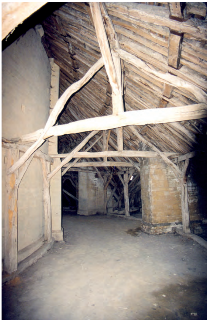
Fig. 27 : Charpente du déambulatoire, travée tournante sud.
