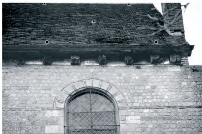
Fig. 149 : Entrails débordants, X e -XI e siècle. Église de la Basse-Cœuvre de Beauvais.
