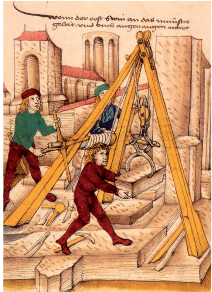
Fig. 90 : Début de la construction de la Grande Église de Bern, Chronique privée de Bern, dite de Spiez, de D. Schilling, 1420/1421, détail, Bern, Bürgerbibliothek (ms. Hist. Helv. I-16 fol. 755).
