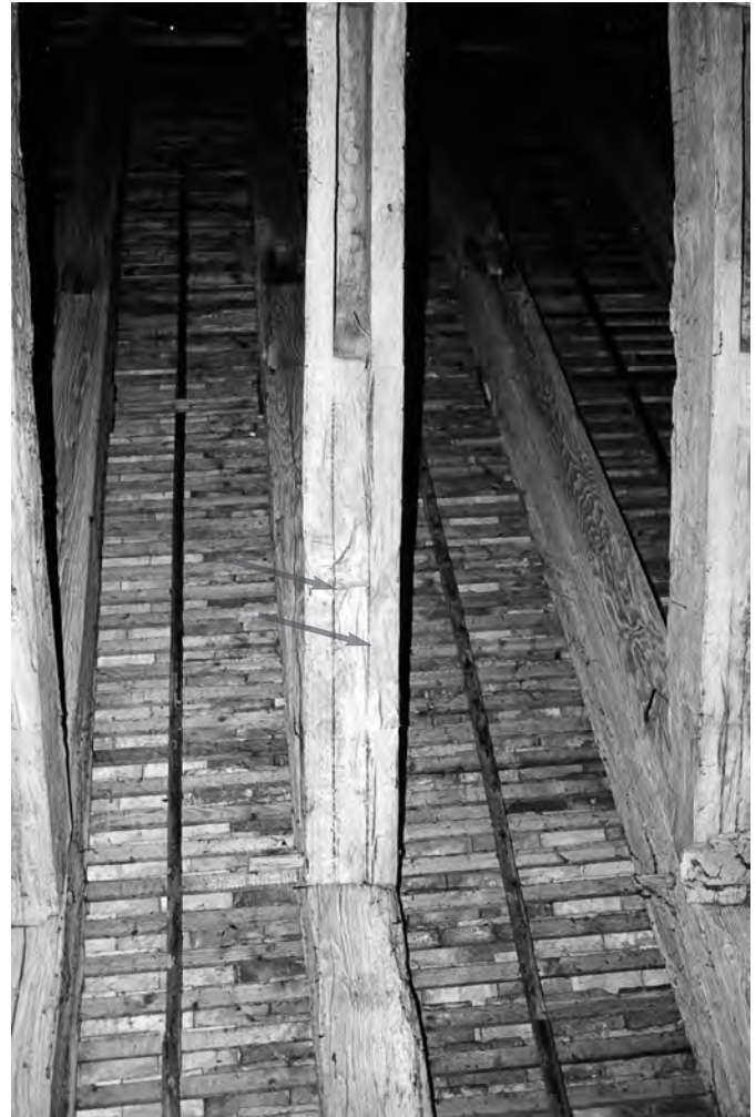
Fig. 49 : Lignage à double traits. Abbaye de Bonport (Eure), dortoir (1221d), entrail retroussé.
