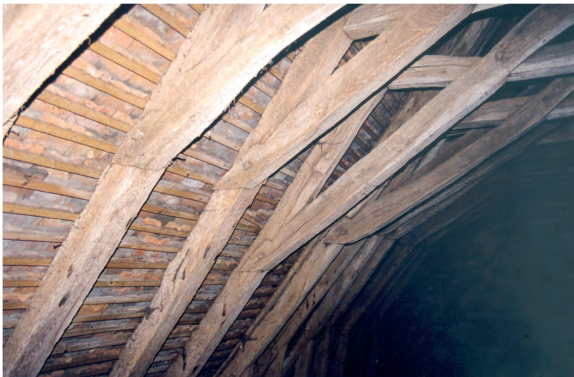
Fig. 8 : Assemblages à mi-bois avec ergot du pied des écharpes.
