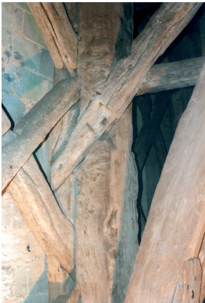
Fig. 26 : Poteaux d'ossature taillés dans un bois d'émonde particulièrement noueux. Beffroi de la cathédrale de Bayeux, 1195d.
