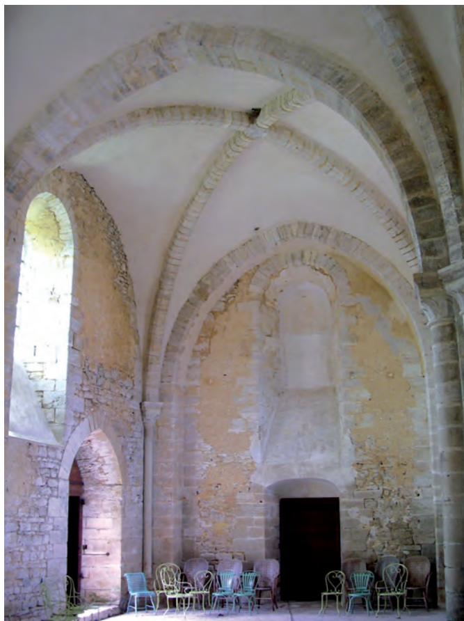
Fig. 4 : Voûtes sur croisée d'ogives de la travée ouest.
