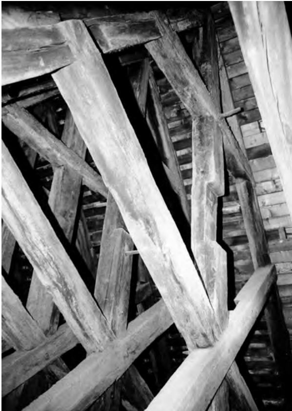
Fig. 18 : Ferme principale de la charpente de la nef.
