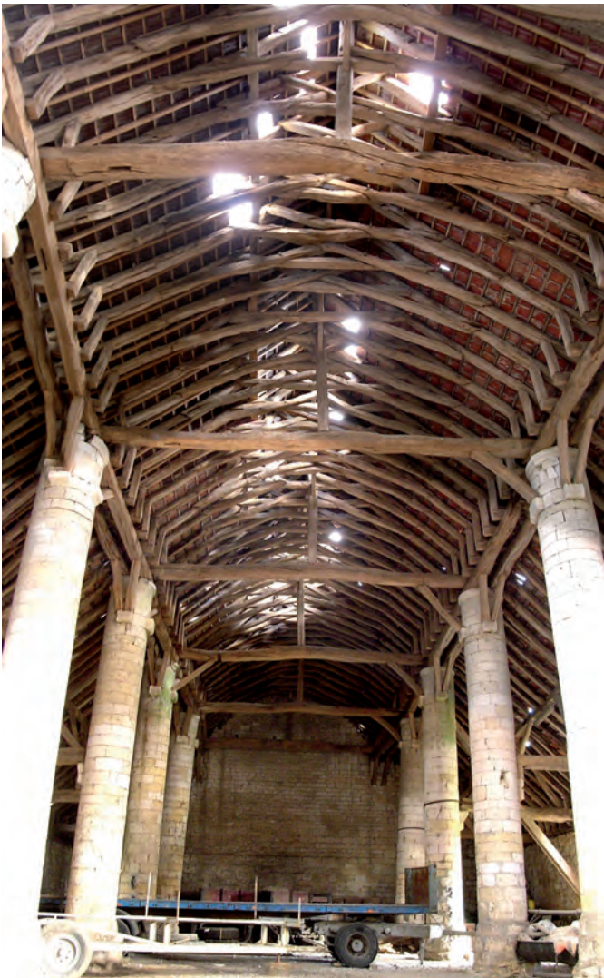
Fig. 158 : Charpente de la grange de Warnavillers, 1189/1190d (Oise).
