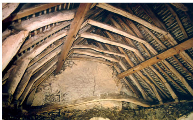
Fig. 12 : Charpente du chœur : entrain tors de la ferme principale orientale pour franchir le bombement de la voûte aujourd'hui disparue.
