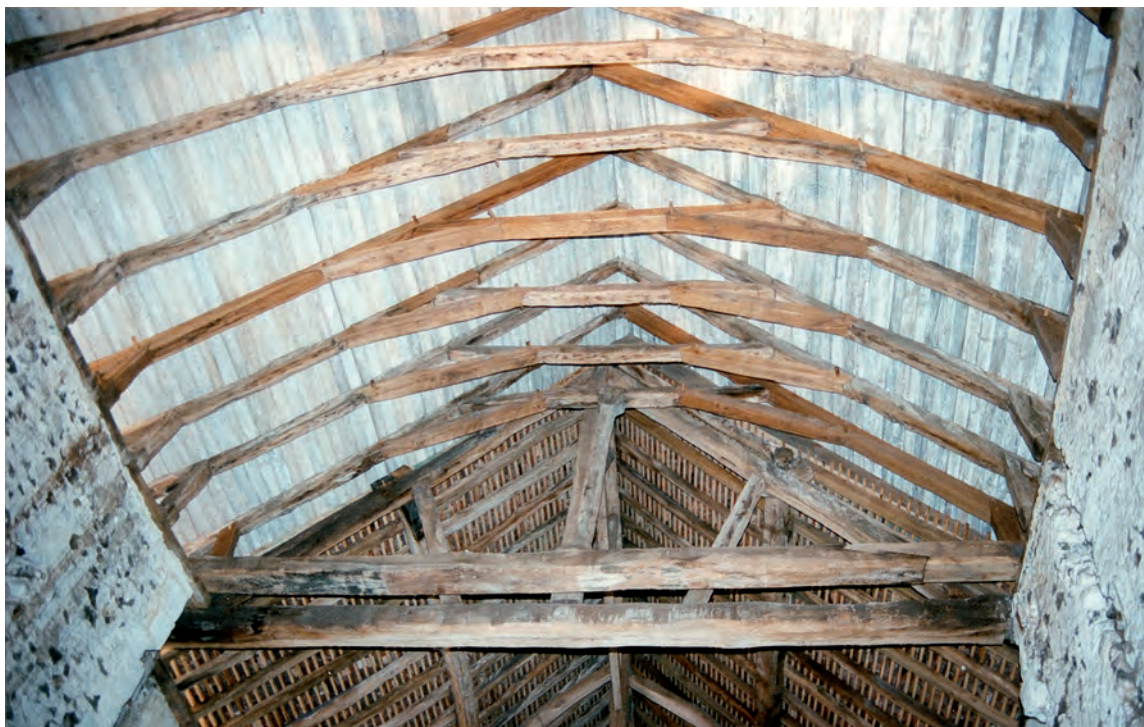
Fig. 6 : Charpente du bâtiment C, ferme principale.
