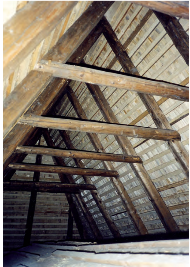
Fig. 111 : Charpente à chevrons-formant-fermes de l'église de Rozavlea, Maramures (Roumanie).
