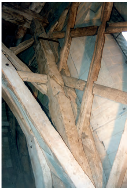
Fig. 13 : Raccord du pan médian au pan est.
