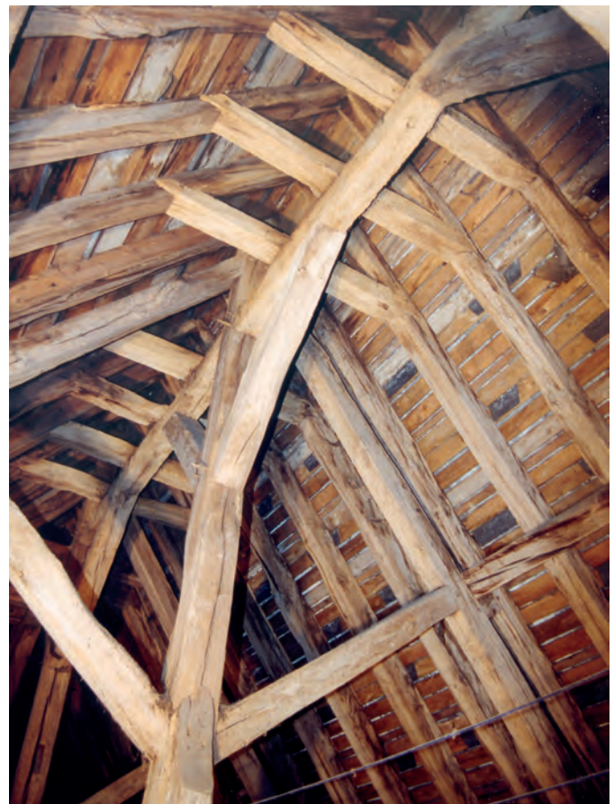
Fig. 8 : Partie haute des fermes.
