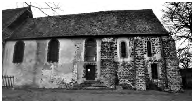
Fig. 2 : Mur sud du chœur avec la prolongation du chevet vers l'est en grison au XII e siècle.
