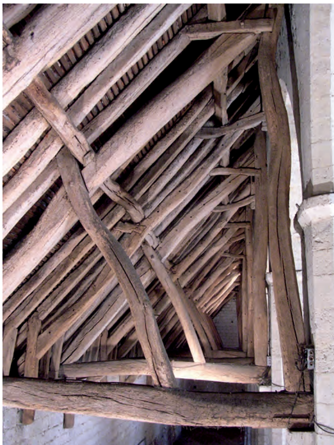
Fig. 23 : Bois tors de la grange Saint-Lazare de Beauvais (1219/1220d). On note comment les bois ont été disposés selon leur courbure pour répondre au mieux à la reprise des charges ou pour épouser les contours des maçonneries.
