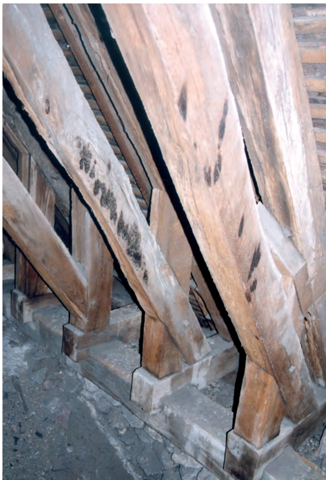
Fig. 35 : Traces de combustion laissées par des lampes à huile.
