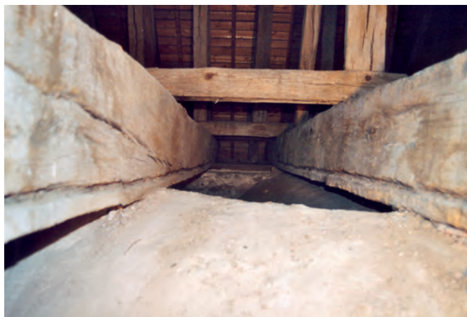
Fig. 13 : Rainures taillées sur le flanc des entrails du transept.
