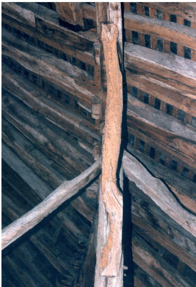
Fig. 39 : Lien oblique taillé dans un bois tors ayant perdu son aubier.
