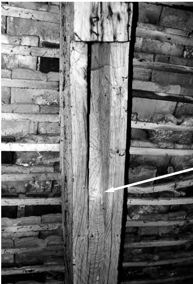
Fig. 12 : Marque d'assemblage de la ferme 80 inscrite dans la mortaise.
