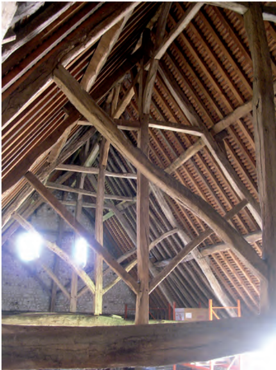
Fig. 24 : Charpente de la grange de l'abbaye de Bonport (1228d).
