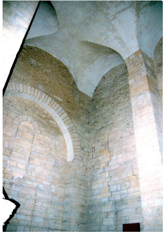
Fig. 6 : Premier étage de la tour nord.
