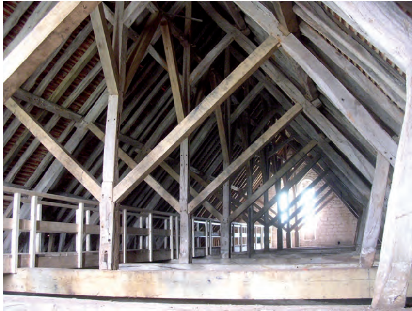
Fig. 17 : Charpente après restauration avec restitution des contrefiches et des liens de contreventement.
