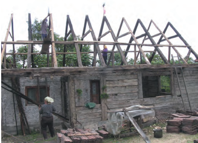
Fig. 126 : Maison traditionnelle en bois avec des fermes rapprochées indépendantes, assemblées à mi-bois, contreventées provisoirement. Maramures, Roumanie.
