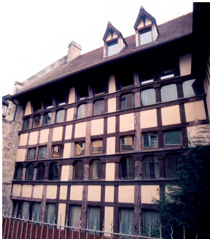
Fig. 7 : Façade sud du logis après restauration.
