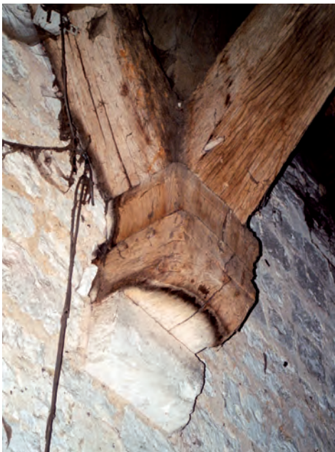
Fig. 8 : Sabot sculpté supportant un potelet de ferme principale.
