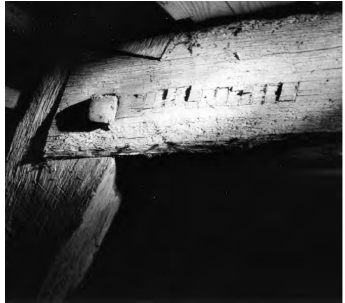
Fig. 82 : Encombrement des treize traits d'une marque à bâtonnets. Église de Saint-Sulpice-sur-Risle (fin du XII e siècle).
