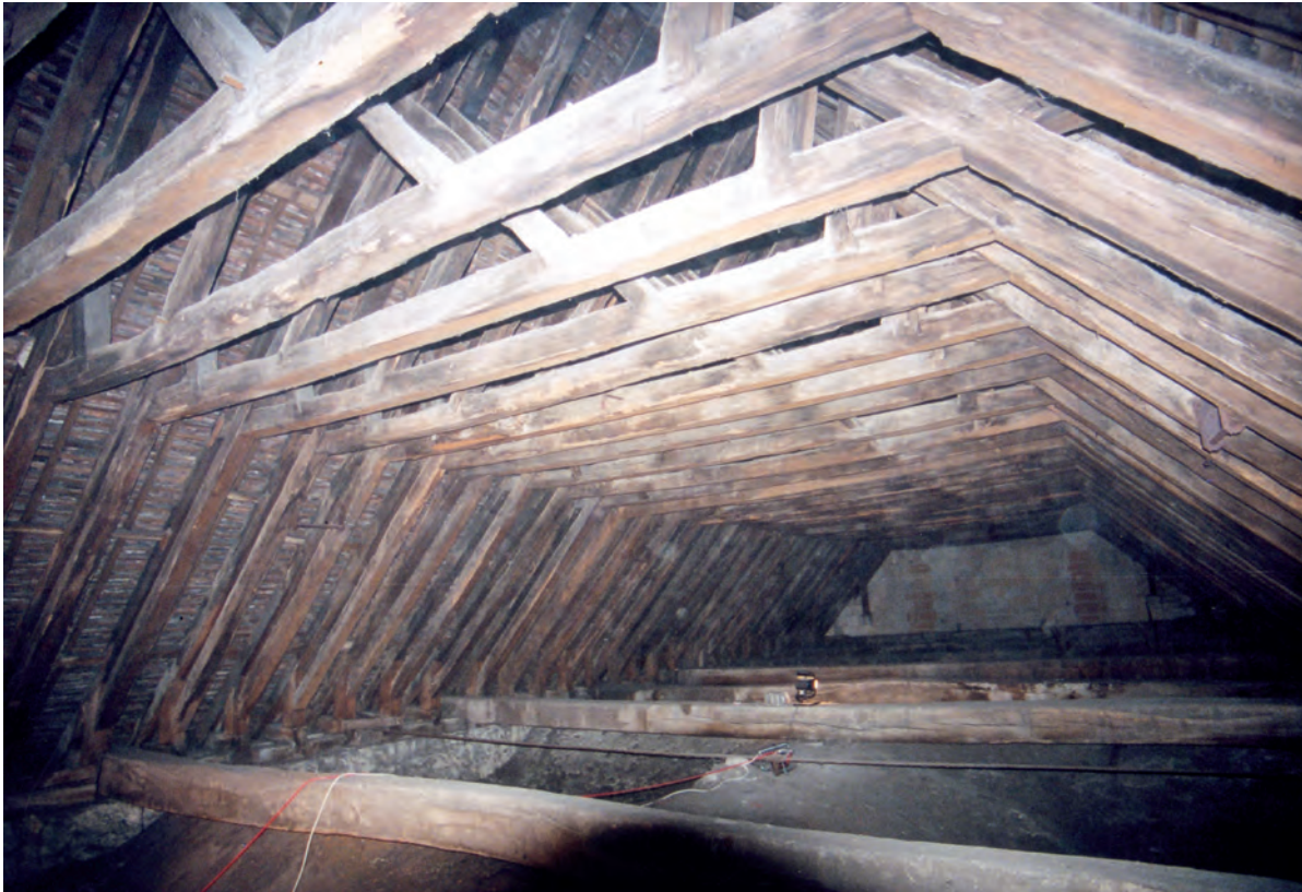
Fig. 25 : Charpente du chœur (1200-1206d).
