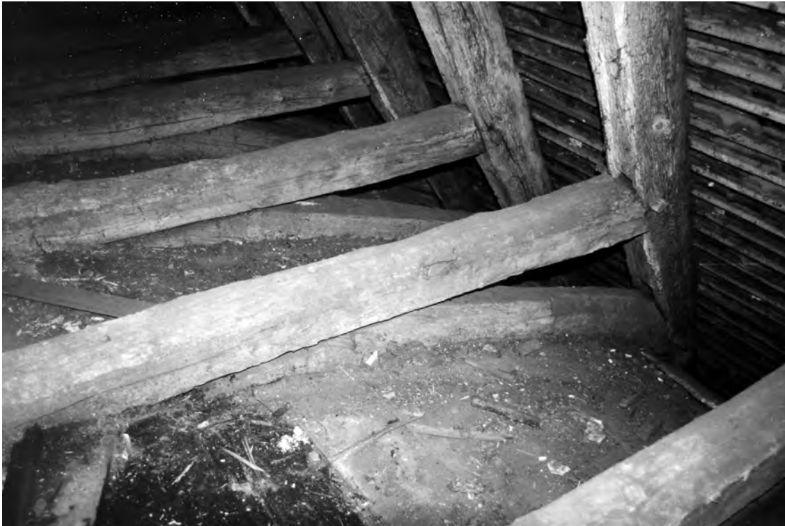
Fig. 7 : Aisseliers courbes de la voûte lambrissée.
