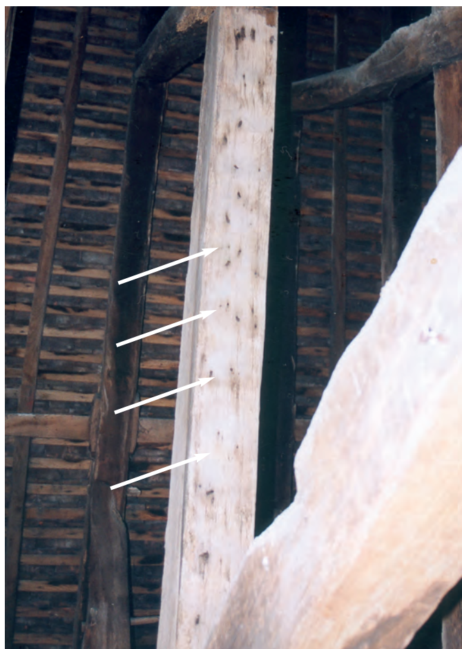
Fig. 116 : Négatif du lattis de la couverture d'origine sur un chevron de 1182d réemployé. Cathédrale de Lisieux, nef.
