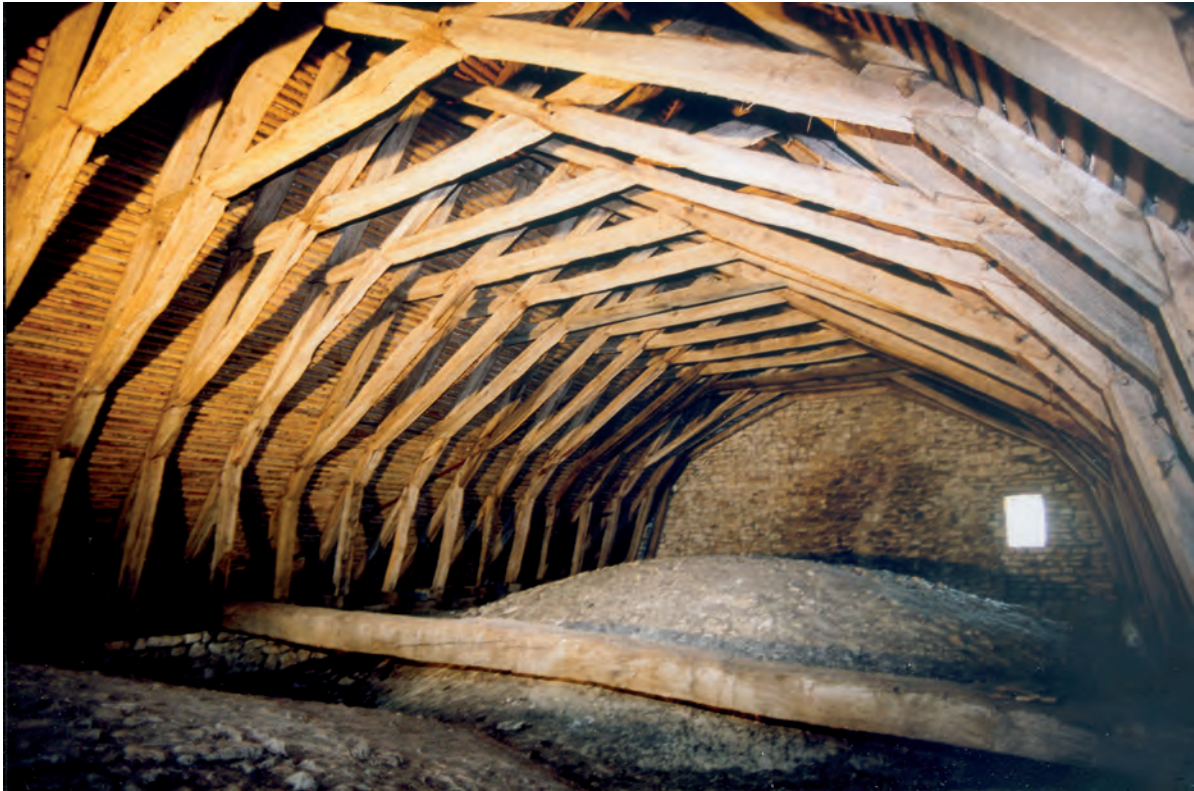
Fig. 7 : Fermes de la charpente du comble (1183-1192d).
