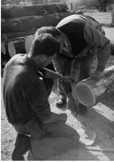
Fig. 33-1 : Tracé de la section de la pièce aux abouts de la grume.
