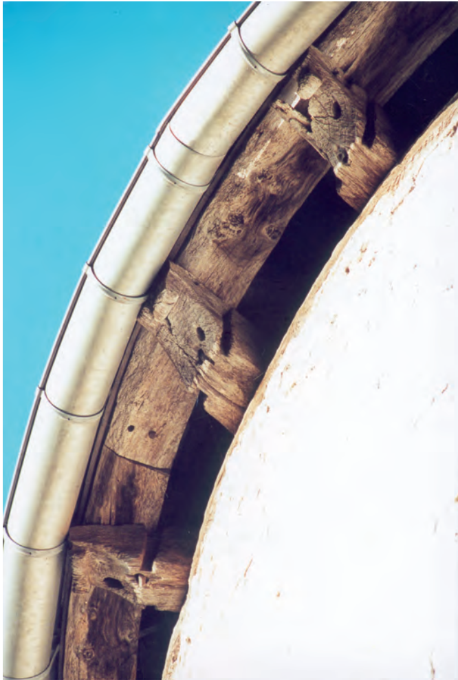
Fig. 14 : Abouts sculptés et rainurés des entrails de la croupe.
