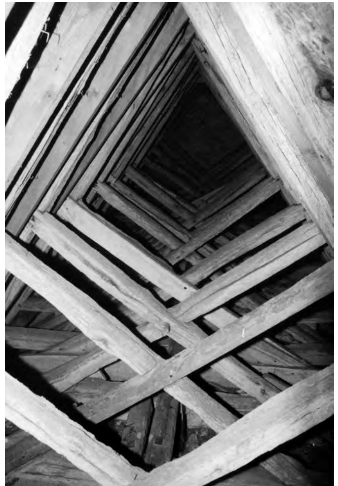
Fig. 7 : Fermes de la charpente du chœur, face ouest.
