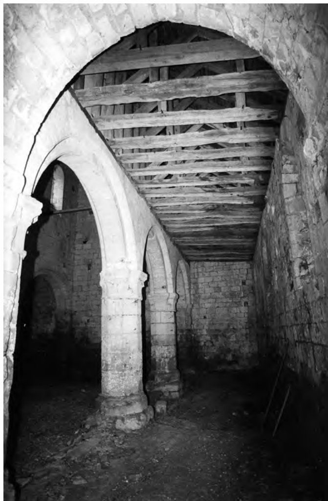
Fig. 143 : Charpente romane du bas-côté nord de l'église de la maladrerie Saint-Lazare de Beauvais, seconde moitié du XII e siècle.
