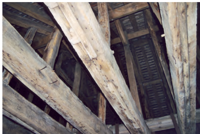
Fig. 146 : Couvre-joints et départs de lambris en place en sous-face des entrails, 1164-1174d. Église Saint-Pierre de Montmartre, Paris.
