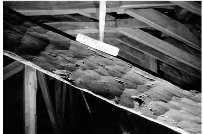
Fig. 36 : Cupules laissées par l'équarrissage à la doloire, cathédrale de Rouen.
