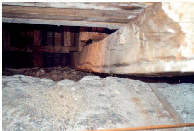
Fig. 14 : Déviations de la rainure.
