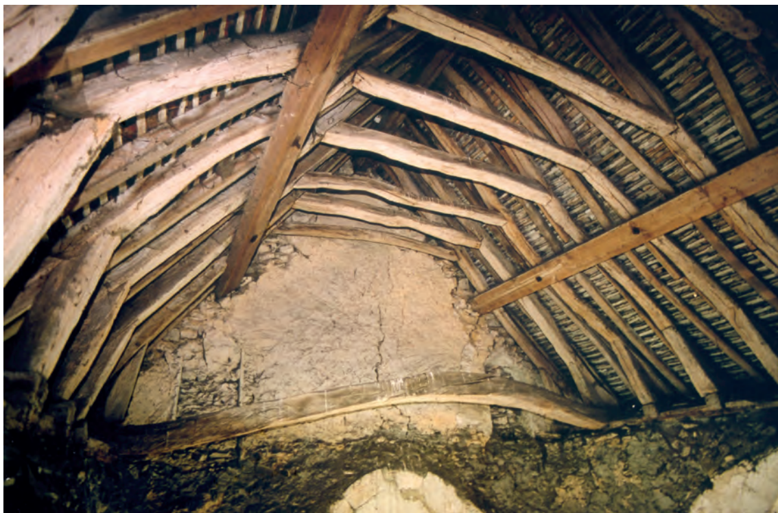
Fig. 25 : Entrait courbe assurant le franchissement de l'extrados des voûtes maçonnées (disparues), chapelle de Vaux, Gisors (Eure), 1224d.
