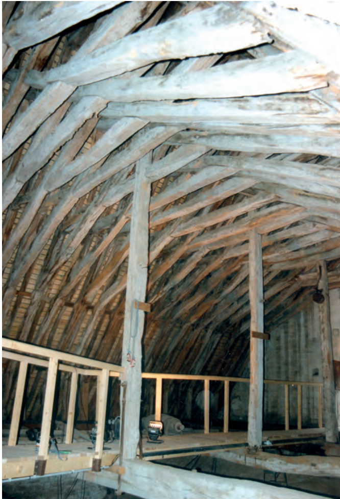
Fig. 78 : Charpente du croisillon nord.
