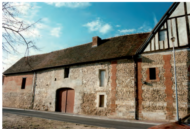
Fig. 4 : Bâtiments C et D, façade sur rue.
