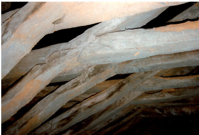
Fig. 81 : Assemblages des deux pièces d'une écharpe à l'entrait retroussé.
