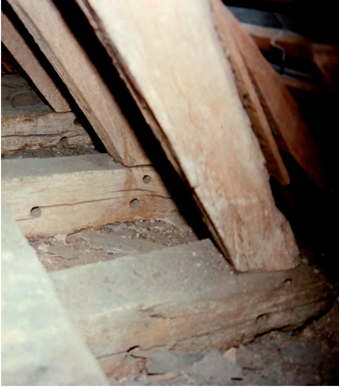
Fig. 9 : Blochets des pieds de fermes secondaires.
