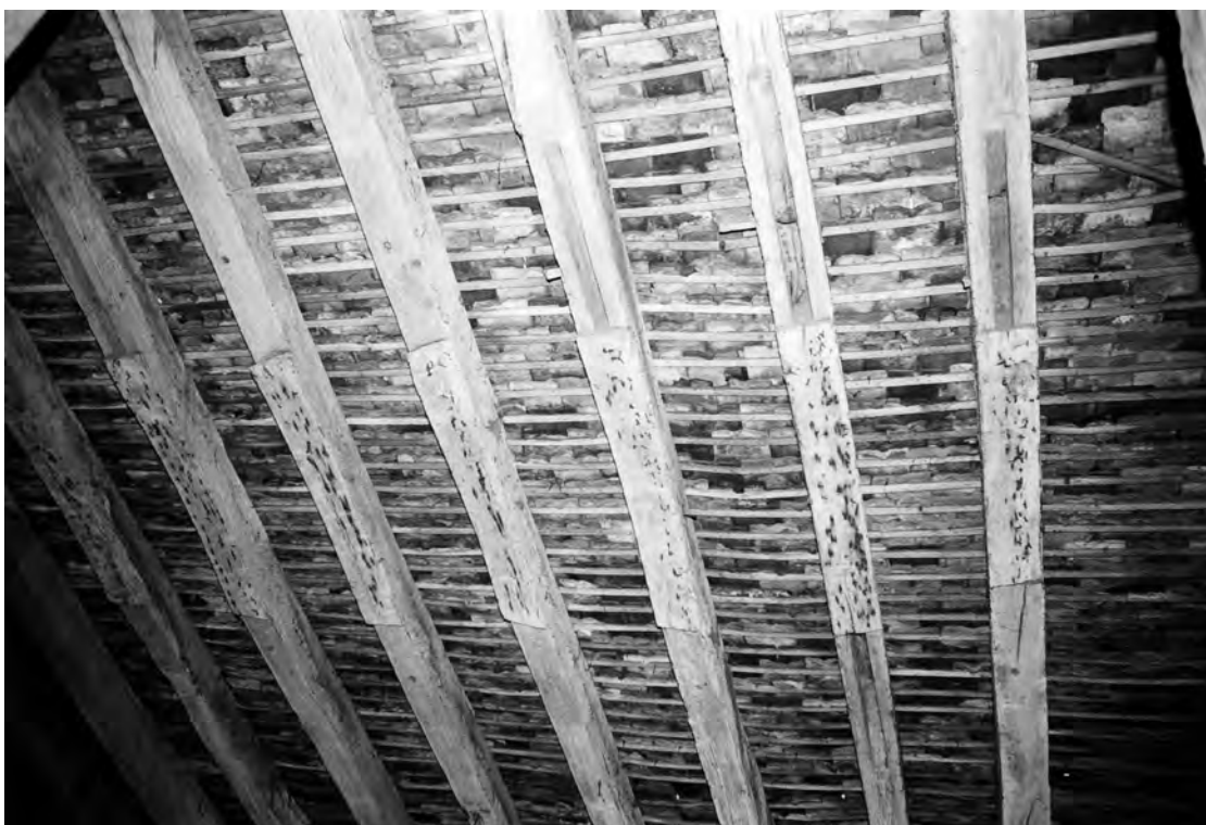
Fig. 8 : Mortaises vides et entailles d'embrèvements des aisseliers et des jambes de force aux chevrons.
