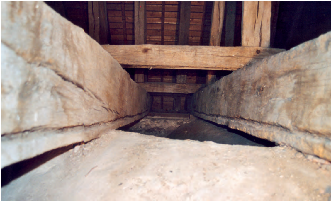
Fig. 144 : Rainures des entrails, 1120-1130d. Église Saint-Georges de Boscherville (Seine-Maritime).
