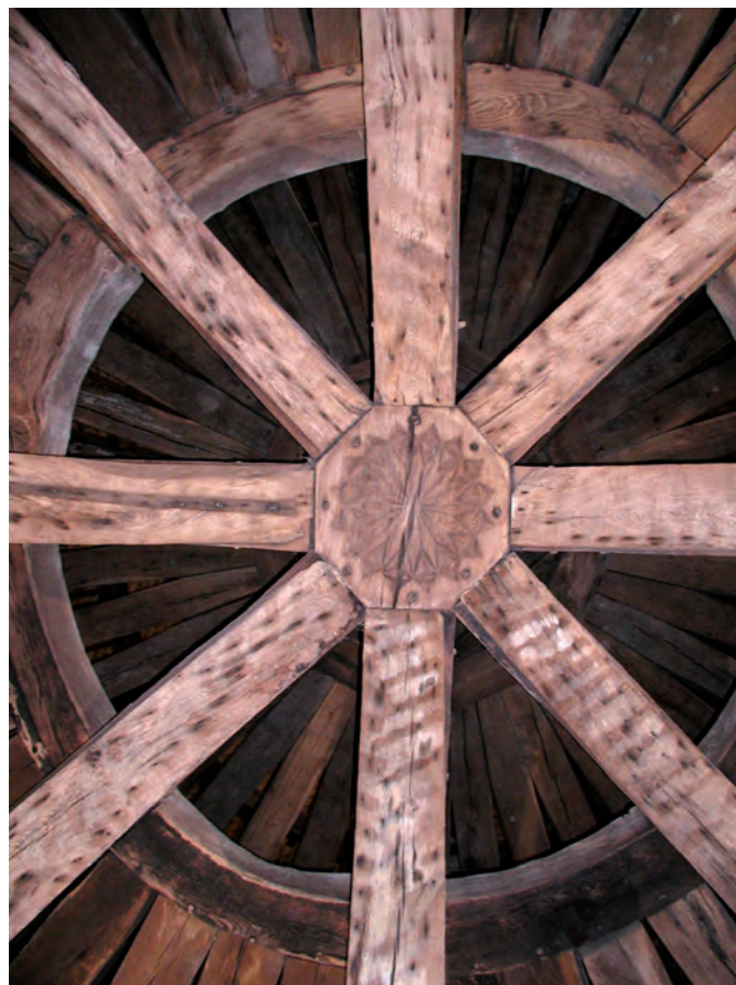
Fig. 24 : Enrayure du hourd de Laval. Des arbres naturellement cintrés ont été spécialement recherchés pour ce chantier. La présence de noeuds et de départs de branches abondants, ainsi que de cernes cicatriciels, suggère l'emploi d'arbres de lisière et/ou de haie (cl. V. Bernard).
