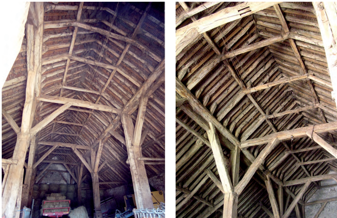
Fig. 2 : Vues intérieures de la charpente.
