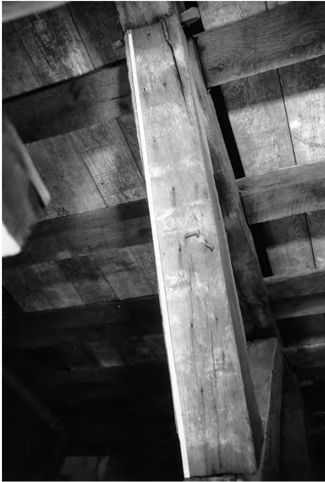
Fig. 118 : Traces du lattis de la couverture en plomb sur un chevron (1195d) en réemploi. Cathédrale de Rouen, nef.
