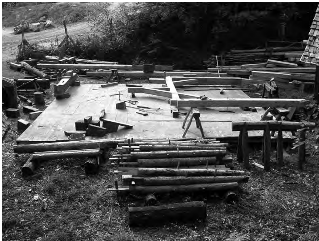
Fig. 62 : Aire d'épures sur plancher provisoire. Chantier expérimental de Guédelon (Yonne).
