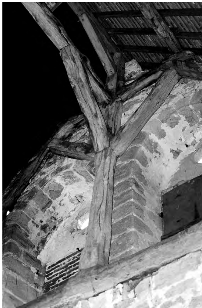
Fig. 6 : Ferme située contre le pignon oriental percé de deux grandes baies.
