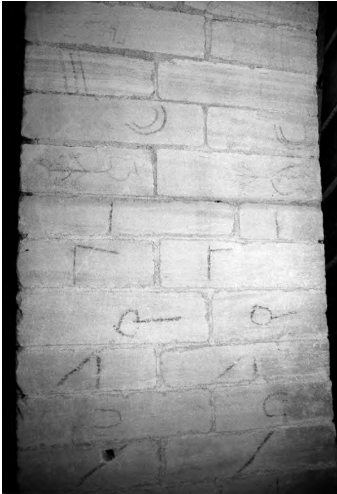
Fig. 68 : Signes lapidaires inscrits au charbon de bois. Cathédrale de Bayeux, arc de décharge de la nef, début XIII e siècle.
