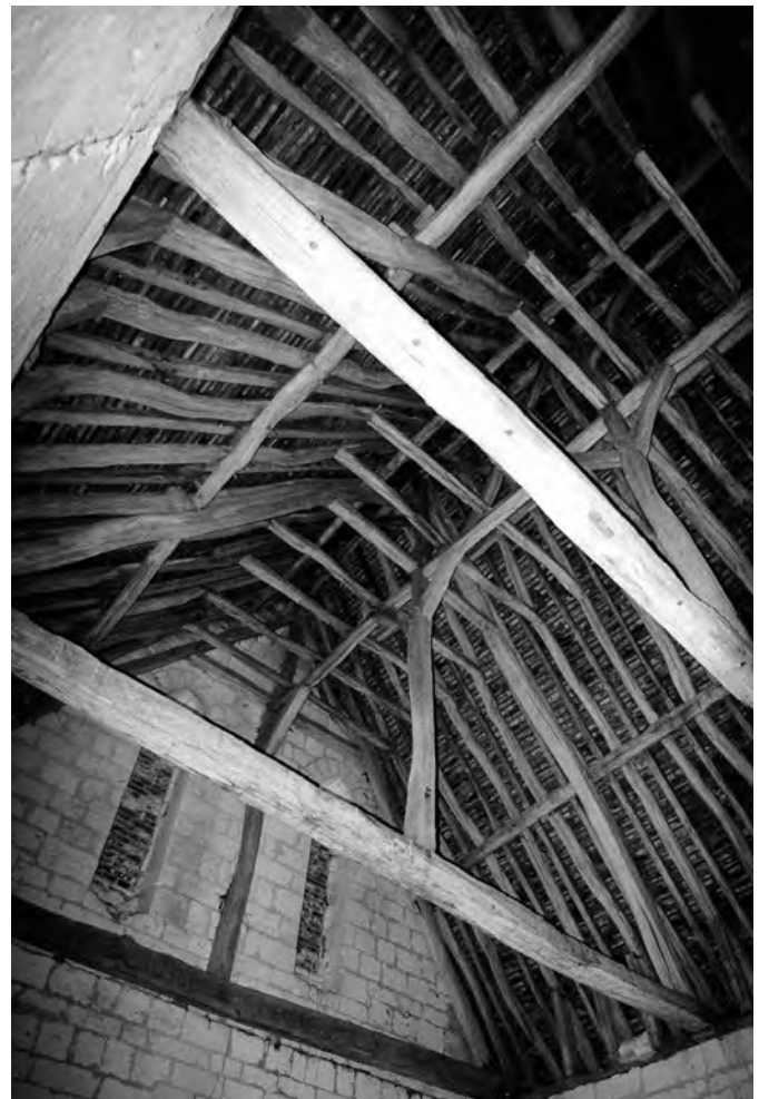
Fig. 179 : Charpente mixte du logis Saint-Lazare de Beauvais (Oise), 1275d.
