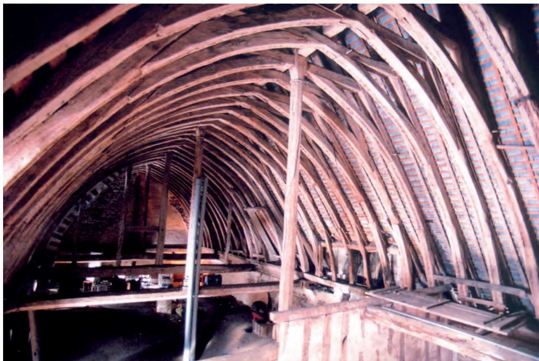
Fig. 5 : Charpente voûtée à chevrons-formant-fermes de la salle haute.
