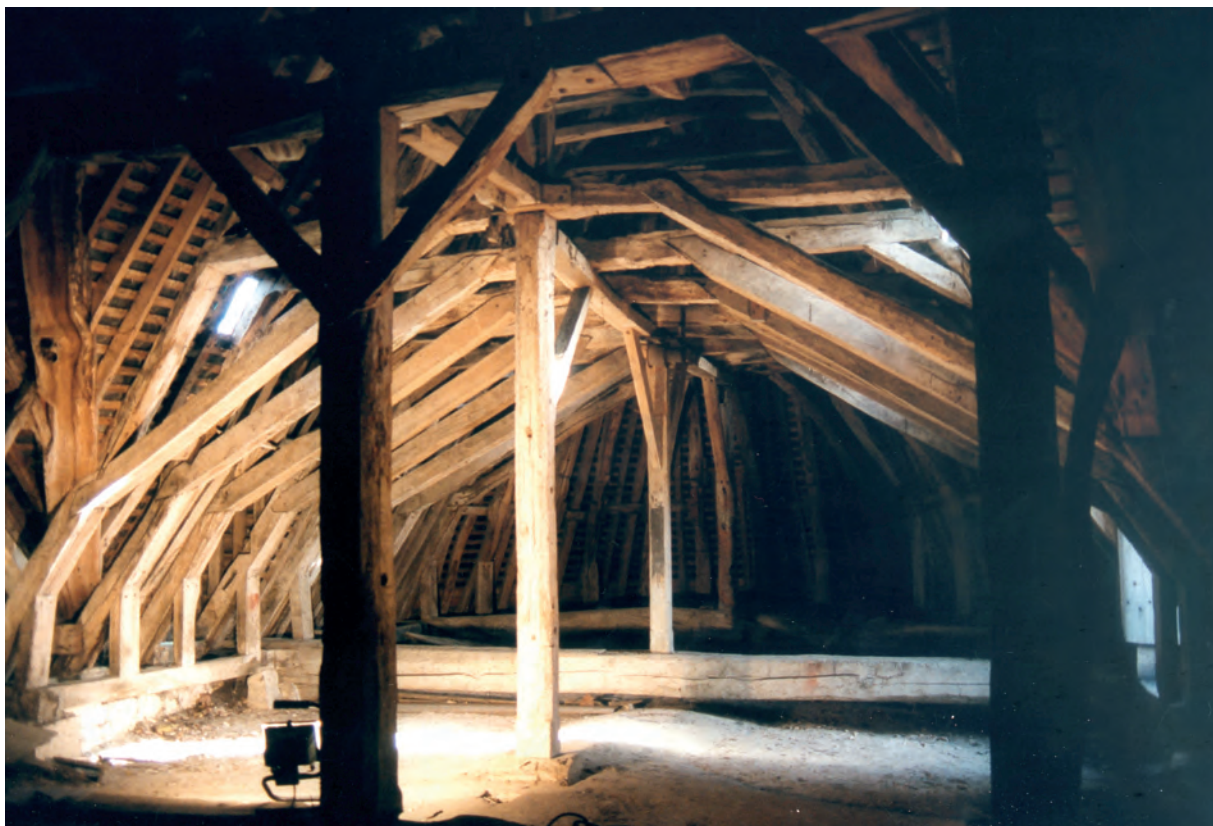
Fig. 42 : Charpente de la chapelle axiale vue depuis le déambulatoire.
