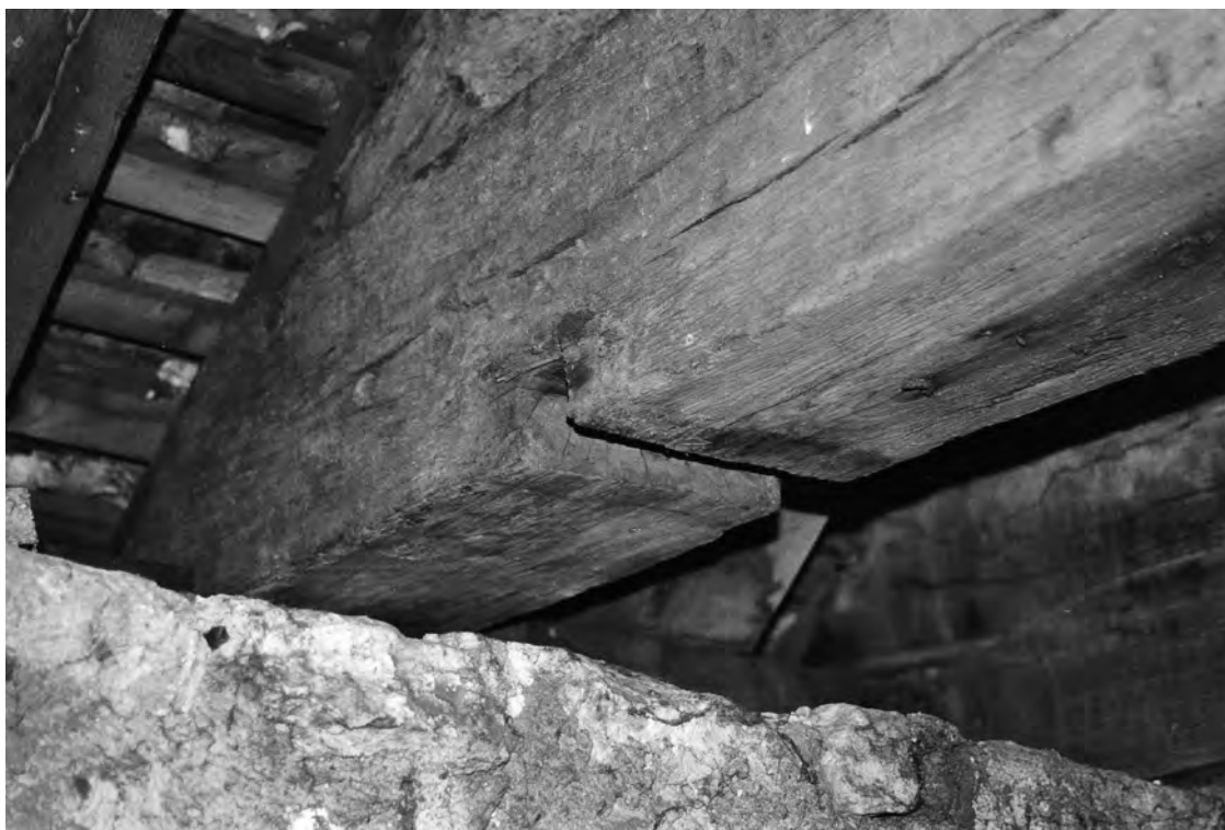
Fig. 142 : Entaille en sous-face d'un entrait pour la languette d'une sablière, 1164-1174d. Église Saint-Pierre de Montmartre, Paris.
