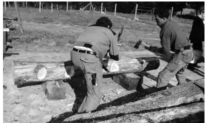
Fig. 33-4 : Des encoches sont taillées le long de ces lignes pour préparer l'équarrissage.
