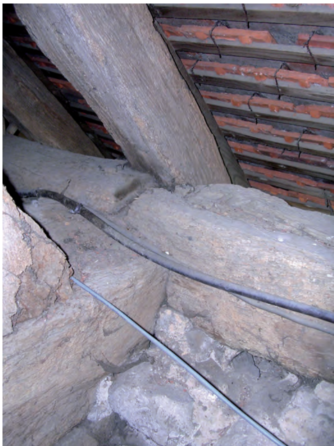
Fig. 27 : Assemblage des entretoises sur l'entrait.
