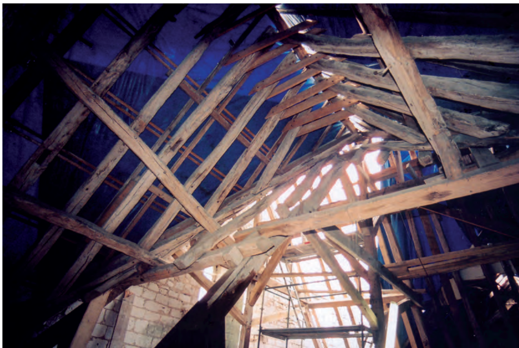
Fig. 22 : Raccord en chevrons-formant-fermes du pignon du chauffoir à la charpente du réfectoire (les pannes sont tardives).
