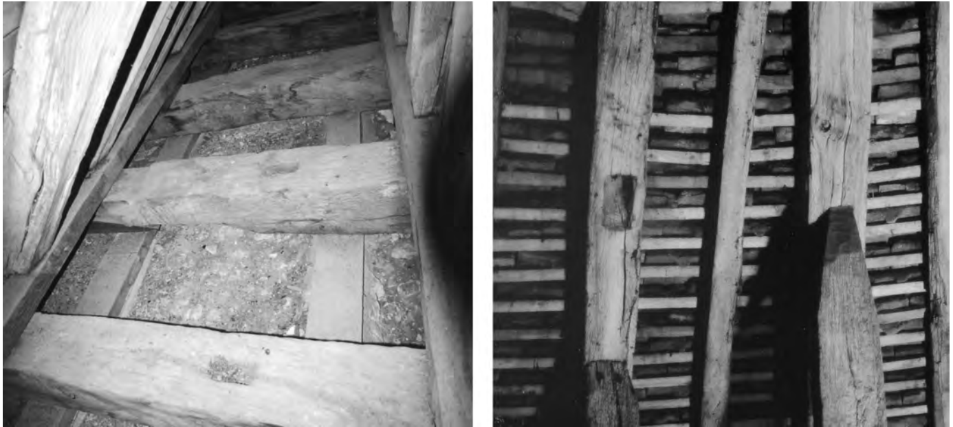
Fig. 134 : Mortaises « primitives », église Saint-Georges de Boscherville (1120-1130d) à droite et église de Neuf-Marché (1127-1133d), Seine-Maritime.
