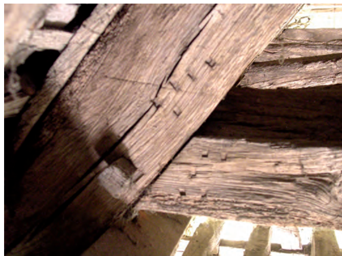
Fig. 8 : Marque d'assemblage à encoches d'une ferme de la nef.
