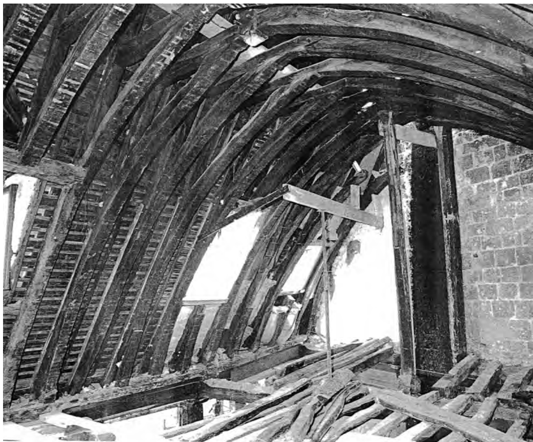
Fig. 3 : Charpente voûtée du logis lors des travaux de restauration de 1984 (Inv. Gén. Haute-Normandie).
