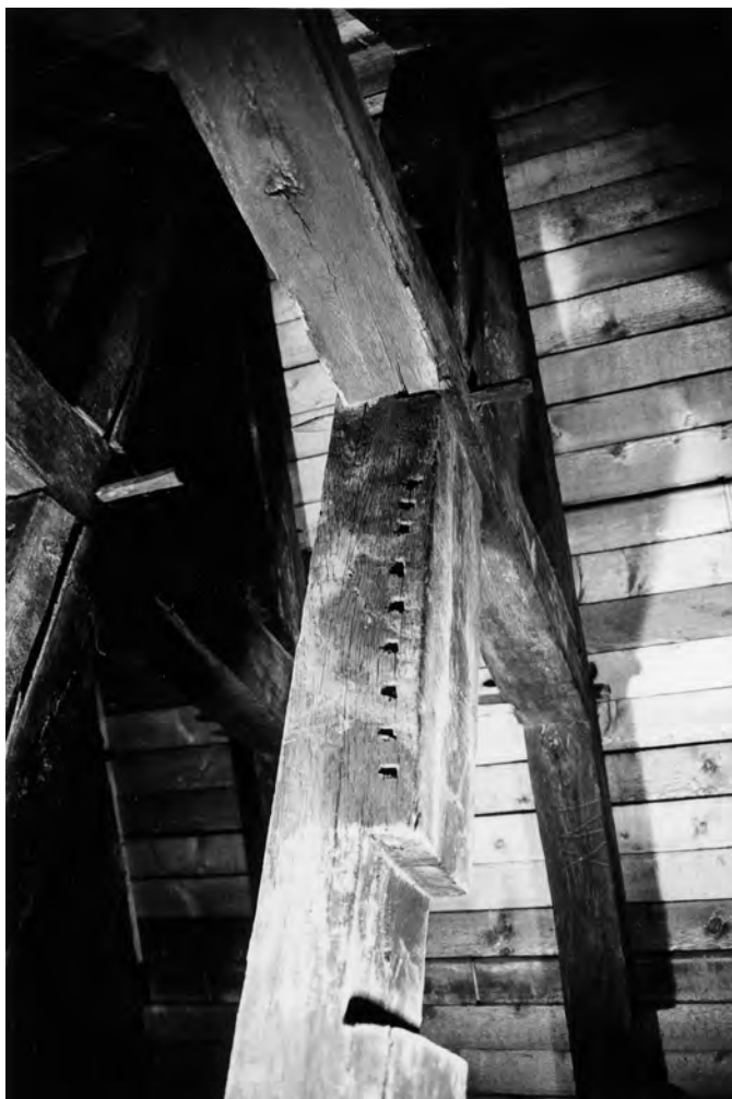
Fig. 73 Marque à encoches. Poinçon en réemploi. Cathédrale de Rouen (1195d).
