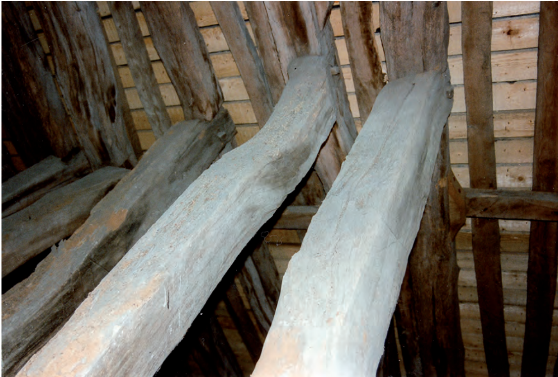
Fig. 83 : Déviation naturelle des écharpes.
