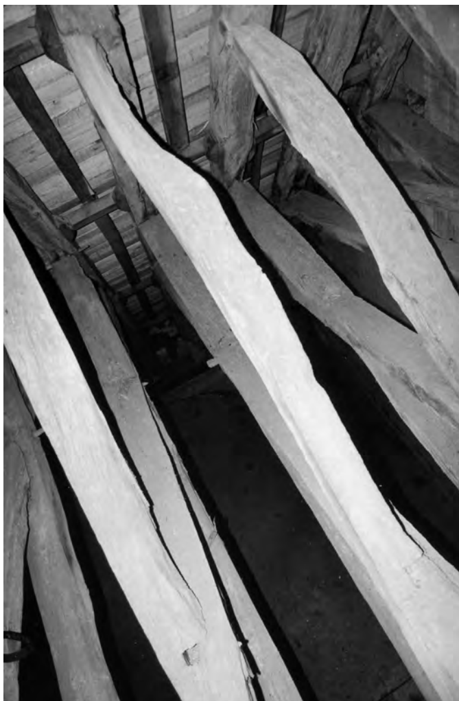
Fig. 39 : Écharpes taillées à la scie de long, cathédrale de Bayeux, bras sud (1223-1226d).
