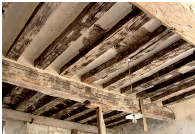
Fig. 10 : Sommier et solives peintes de 1225-1226d en réemploi dans le plancher de la fin du Moyen Âge.
