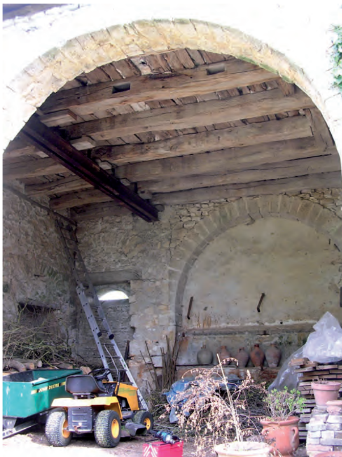
Fig. 13 : Passage charretier et piéton de la porterie et son plafond, le mur de refend a disparu (1197-1214d).
