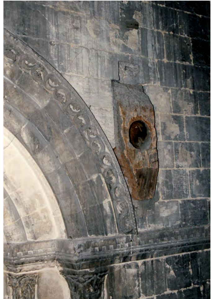
Fig. 102 : Fixation de l'arbre d'un engin de levage, début XV e siècle. Cathédrale de Rouen, tour Saint-Romain.
