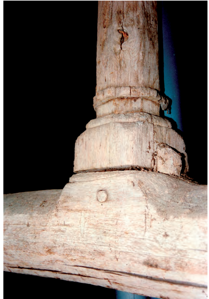
Fig. 7 : Moulures du pied de poinçon.
