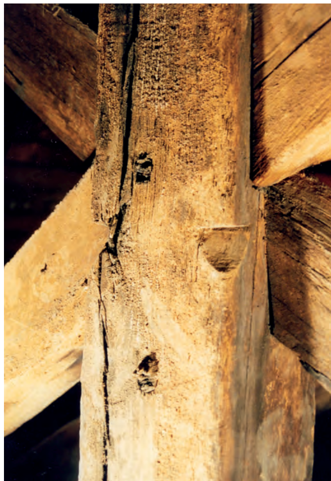
Fig. 85 : Entailles de fixation de cordage sur un poinçon. Cathédrale de Rouen (1227-1232d).
