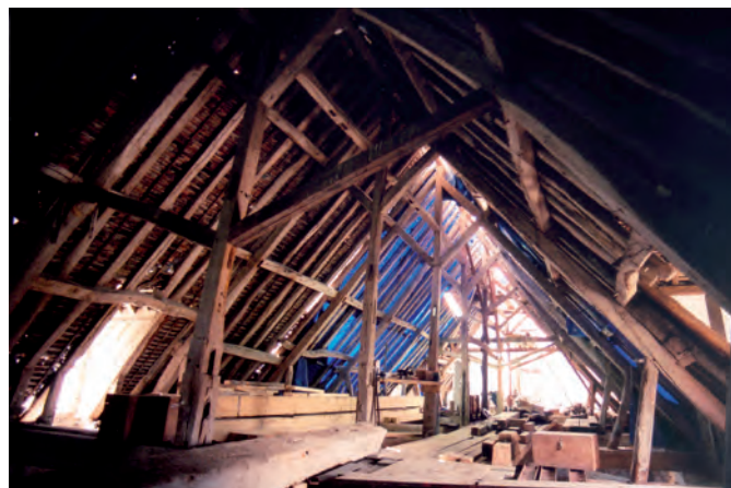
Fig. 16 : Charpente du réfectoire, en cours de restauration.
