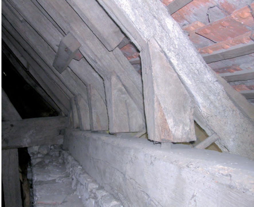
Fig. 29 : Pieds de chevrons, jambettes posées sur la sablière.
