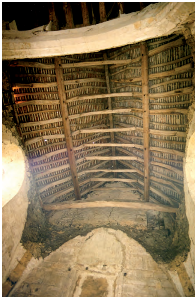
Fig. 10 : Charpente du chœur.
