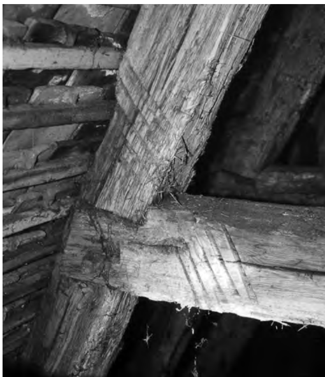
Fig. 9 : Marque à grands traits gravée au ciseau à bois ou à la hache.
