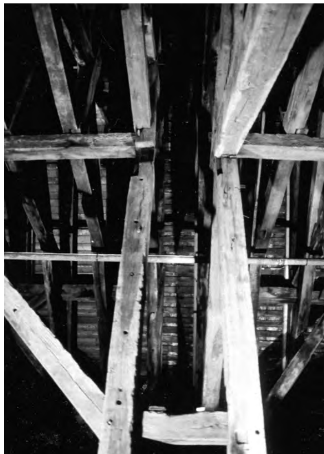
Fig. 32 : Interruption des liernes entre les fermes principales mitoyennes 9 et 10.
