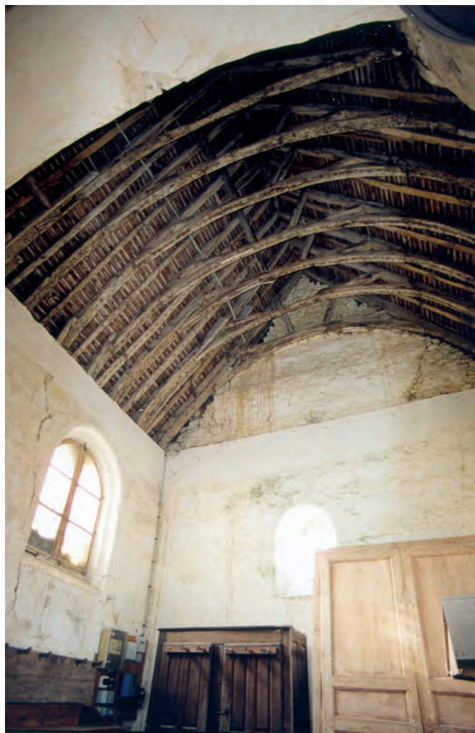
Fig. 4 : Charpente du croisillon nord.
