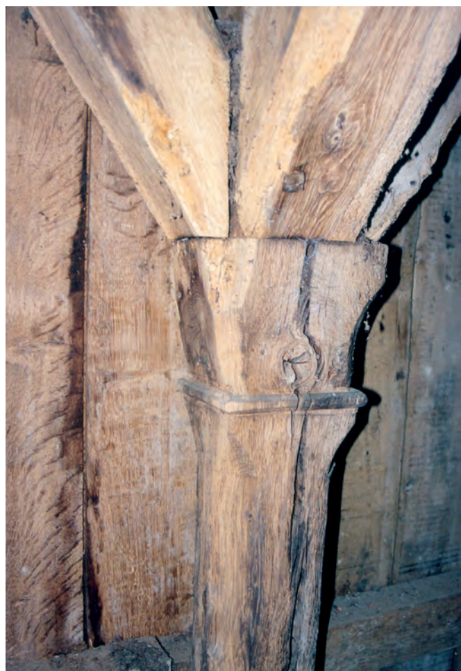
Fig. 9 : Moulures du poteau sous l'assemblages des liens obliques (vers 1290d).
