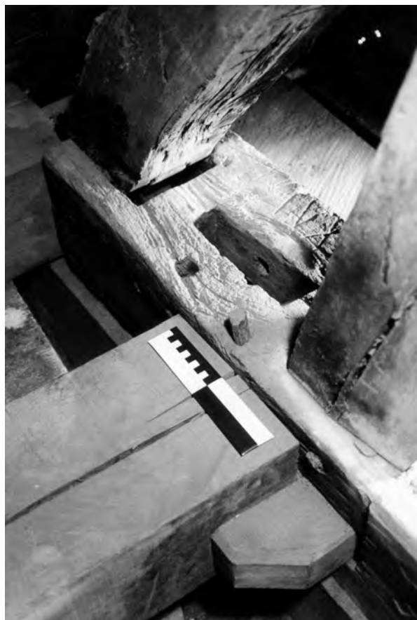
Fig. 24: Pied de ferme principale du premier ensemble.
