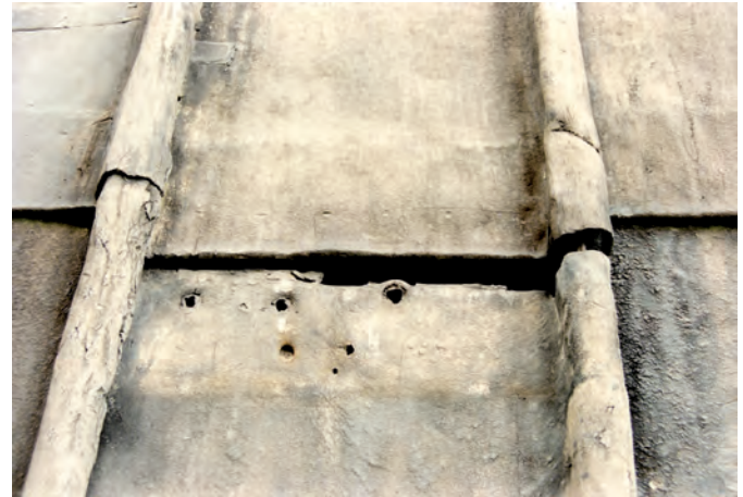
Fig. 123 : Cloutage sur un chevron et enroulement des bords latéraux. Cathédrale de Rouen, nef occidentale.
