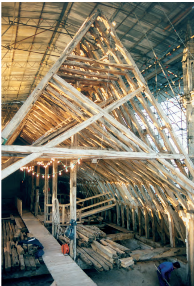
Fig. 50 : Charpente du chœur en cours de restauration, après dépose de la croupe en 1998.
