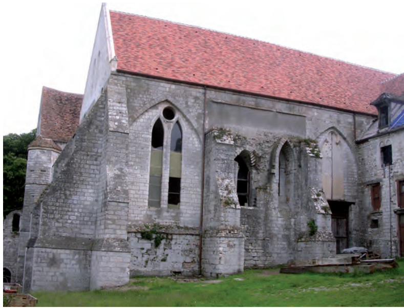
Fig. 13 : Réfectoire, élévations est avec la chaire arrachée.
