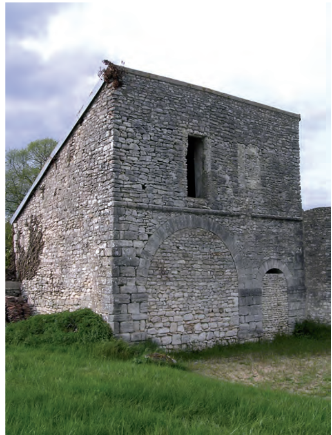
Fig. 12 : Porterie, vue de l'extérieure de la clôture de la commanderie (1197-1214d).
