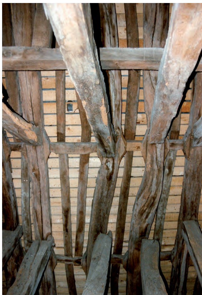
Fig. 82 : Déviation des chevrons et absence d'assemblage des écharpes.
