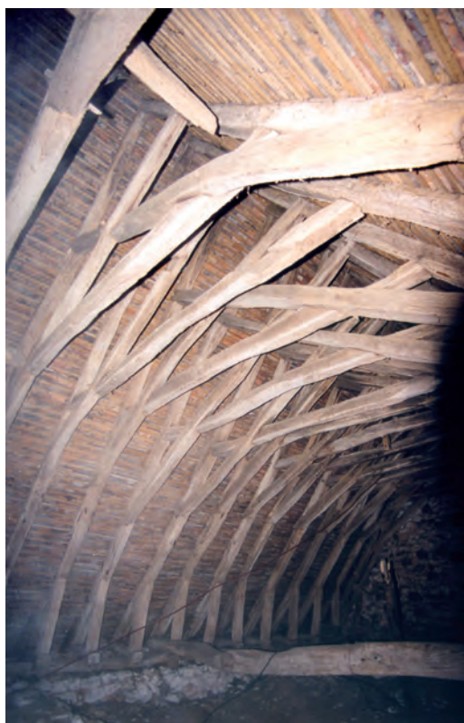
Fig. 5 : Fermes secondaires indépendantes raidies par une croisée d'écharpes et un faux-entrait.
