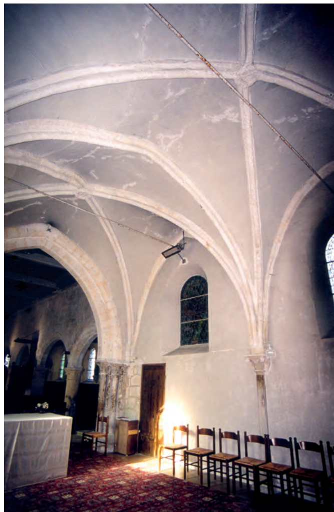
Fig. 3 : Voûtes sur croisées d'ogives du chœur.
