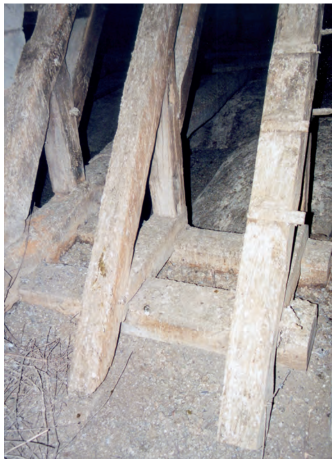
Fig. 20 : Chevron du croisillon sud se prolongeant au-delà du blochet.
