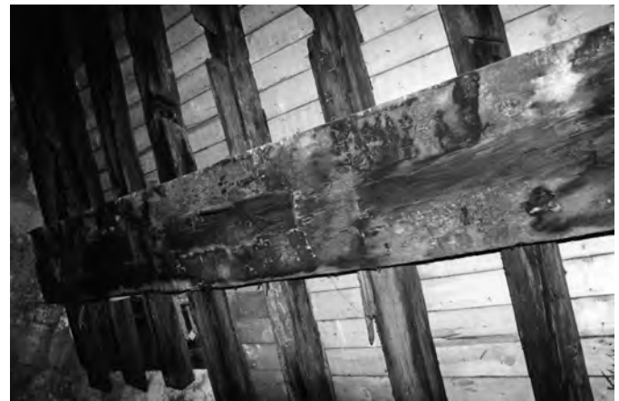
Fig. 140 : Sablière à languette, 1018-1038d. Les languettes ont été bûchées pour le réemploi des sablières comme pannes. Église Saint-Germain-des-Prés, Paris.
