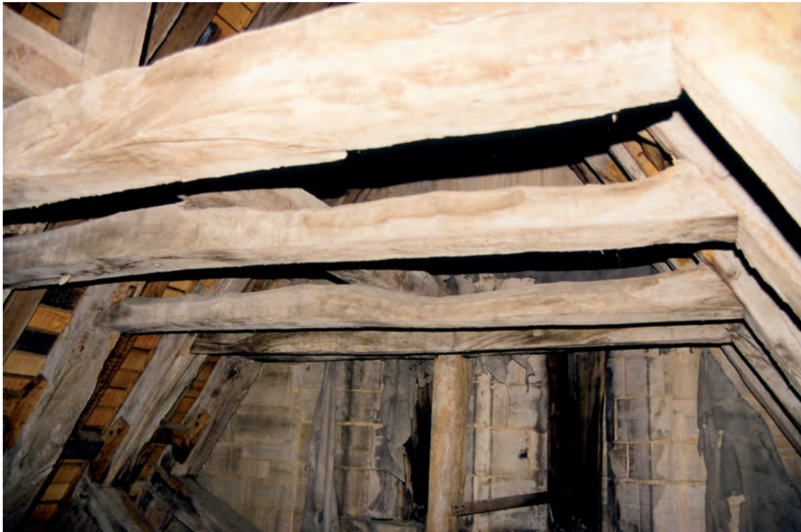
Fig. 73 : Faux-entraits débités à la scie (face inférieure sciée).
