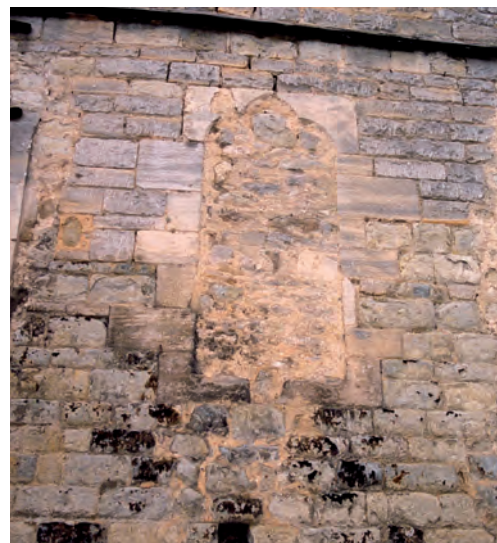
Fig. 3 : Baie à linteau trilobé du pignon oriental.
