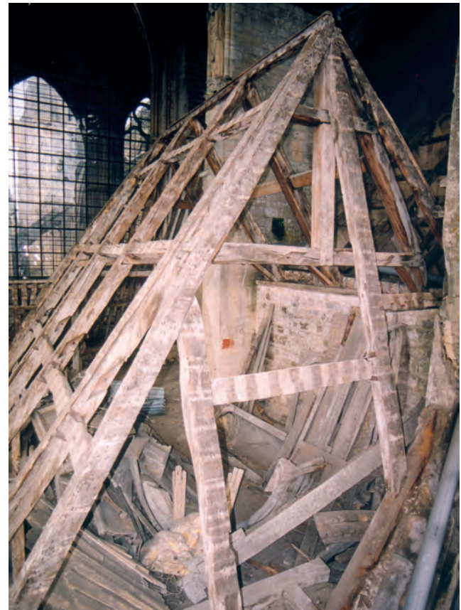
Fig. 48 : Charpente de la chapelle de la Conception.
