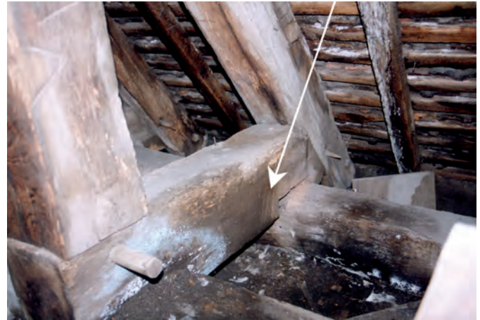
Fig. 19 : Marque du blochet recoupée par l'entaille de la sablière.
