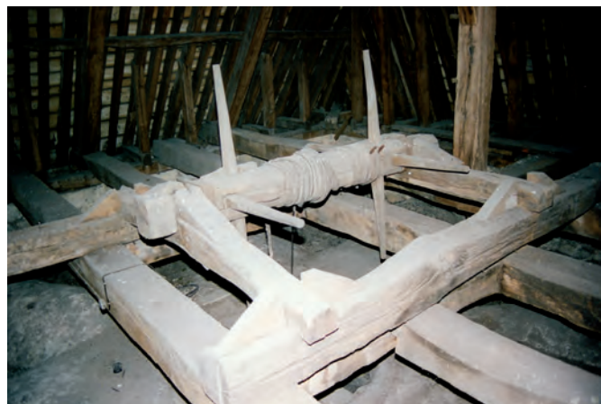
Fig. 95 : Cabestan à deux moulinets. Cathédrale de Lisieux, tour-lanterne.
