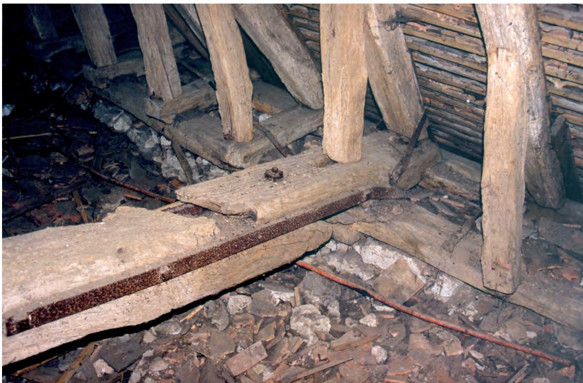
Fig. 27 : Entrait rompu lié à la présence d'un nœud. Église de Quatremare (Eure), début du XIII e siècle.
