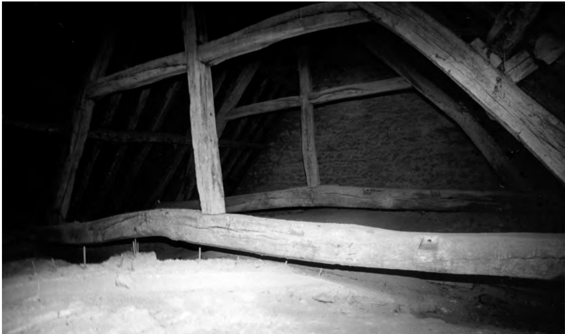
Fig. 44 : Extraits romans courbes pour franchir la voûte, réemployés au XIX e siècle, église de Saint-Clair-sur-Epte (Val-d'Oise).
