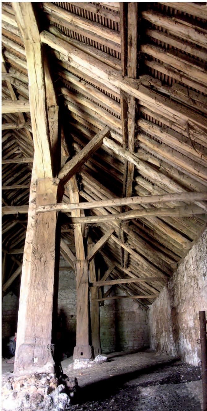
Fig. 12 : Charpente du bas-côté nord.
