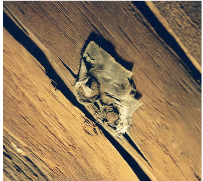
Fig. 119 : Fragment de plomb cloué sur le flanc d'un chevron (1227-1232d). Cathédrale de Rouen, nef.
