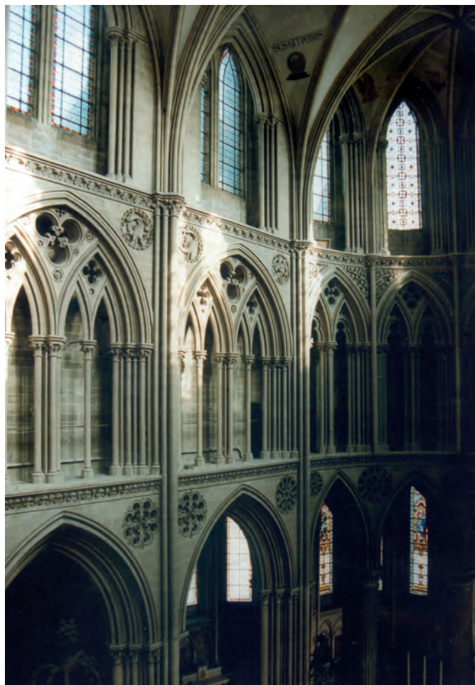
Fig. 25 : Élévations nord du chœur.
