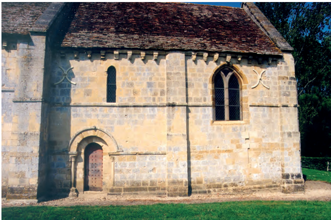
Fig. 10 : Mur gouttereau sud du chœur.
