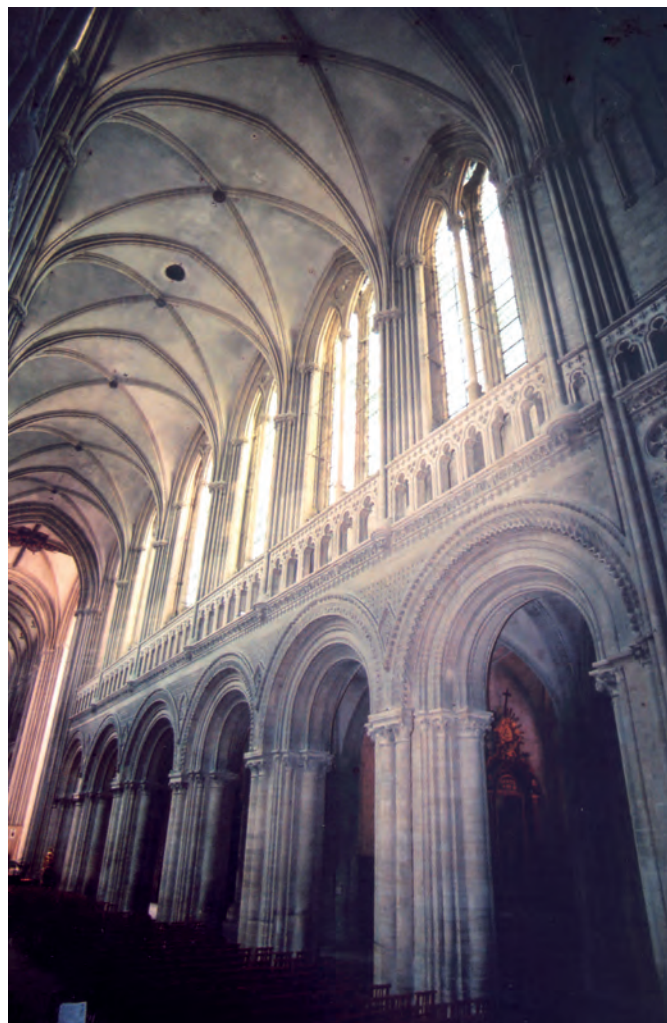
Fig. 7 : Nef, arcades romanes et baies hautes gothiques.
