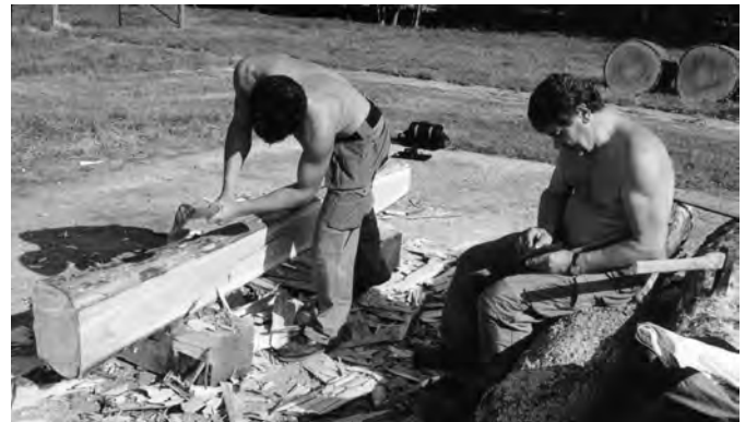
Fig. 33-6 : Finition pour aplanir la face.
