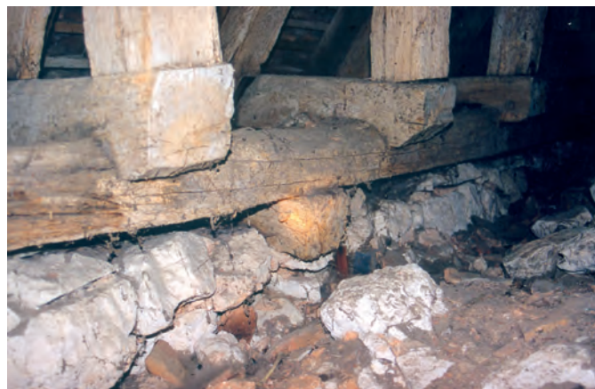
Fig. 10 : Cale placée sous les sablières en milieu de travée.
