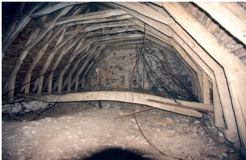
Fig. 4 : Charpente du chœur, entrain tors de la ferme principale médiane.
