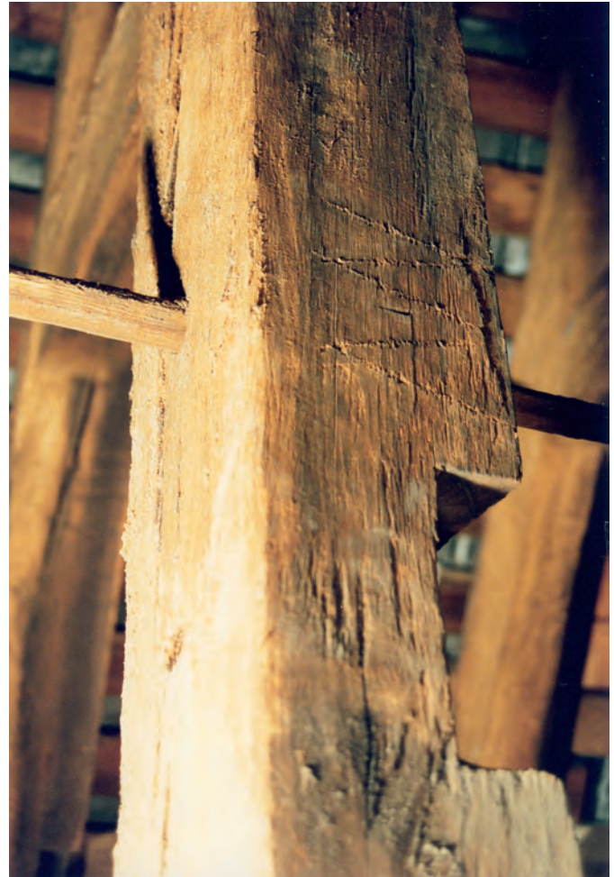
Fig. 13 : Marque particulière gravée au traceret.
