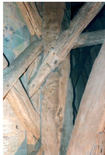
Fig. 15 : Prolongement d'écharpe du pan médian sur le pan est.
