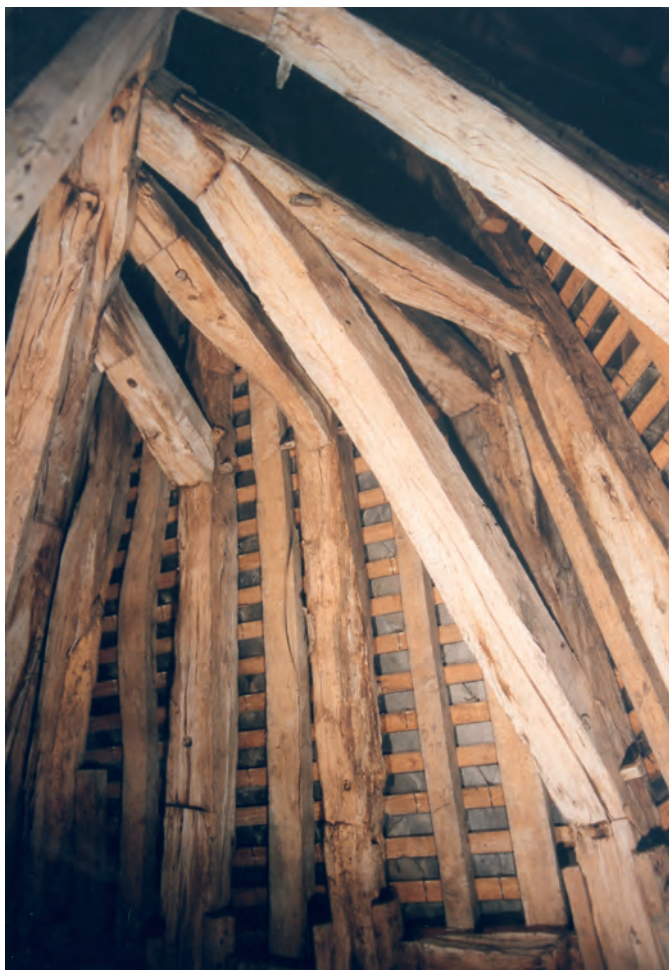
Fig. 45 : Enrayure des entrants retroussés de la croupe.
