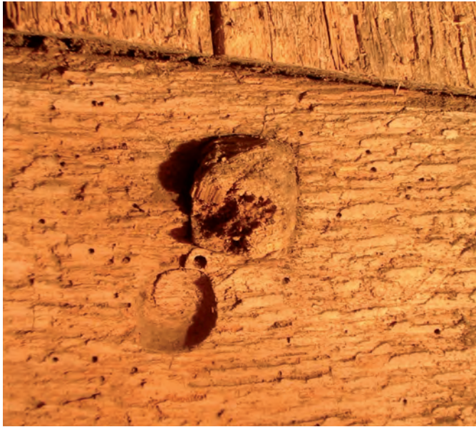
Fig. 108 : Tentative de percement d'un trou de cheville à la tarière à cuiller. Grange Saint-Lazare de Beauvais (1220d).
