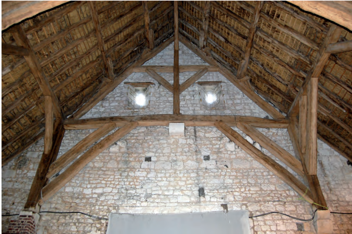
Fig. 3 : Ferme contre le mur-pignon est.
