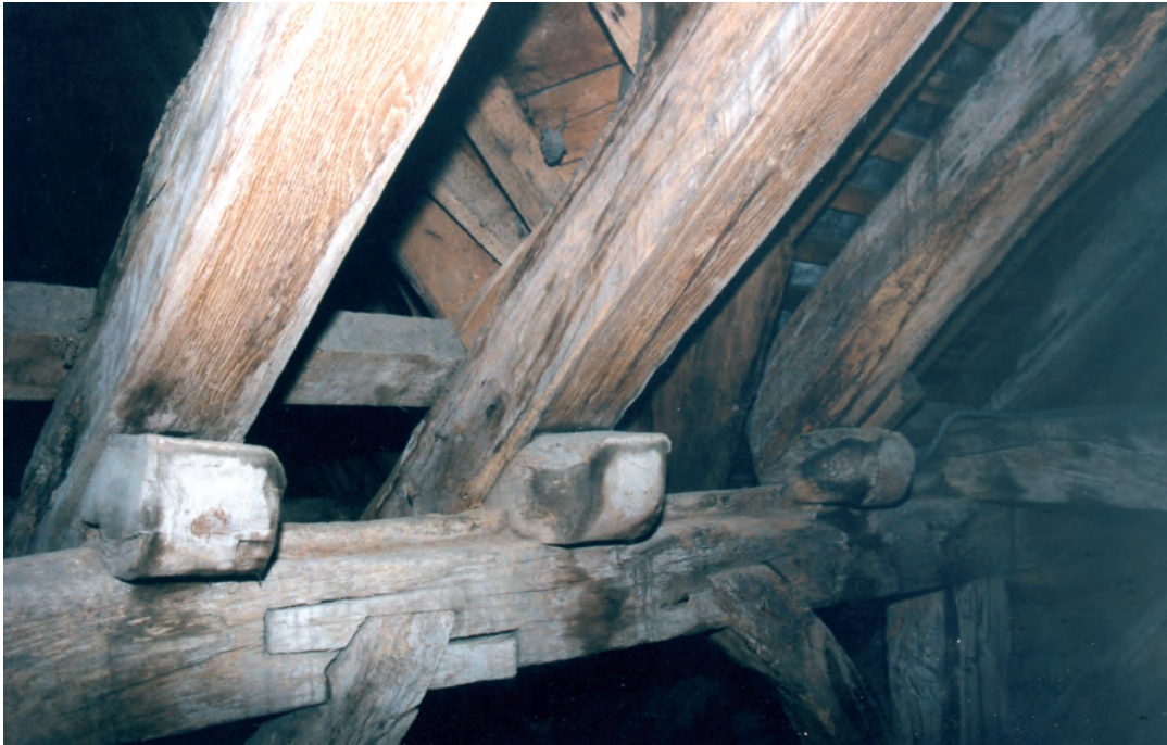
Fig. 35 : Sabots des chevrons assemblés par une languette à la sablière haute du portique.
