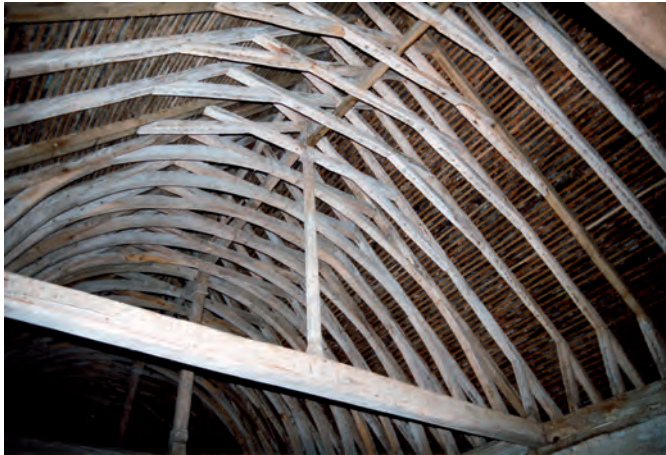
Fig. 5 : Voûte polygonale de la charpente du XIII e siècle avec en arrière-plan la charpente du XVI e siècle, voûtée en plein cintre.
