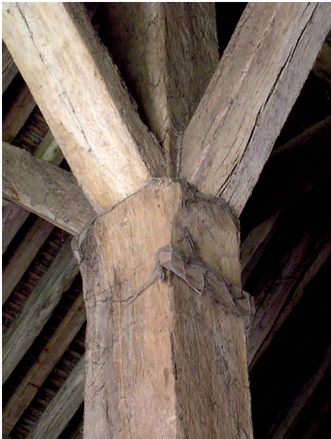
Fig. 10 : Chapiteau de poteau en butée des aisseliers.
