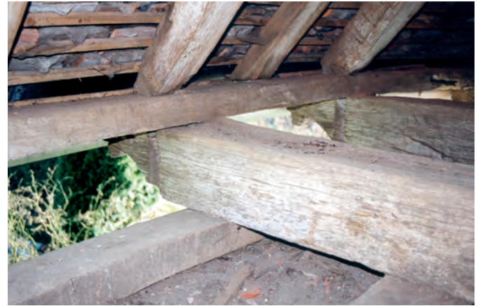
Fig. 15 : Rainure latérale des entrails de la croupe.
