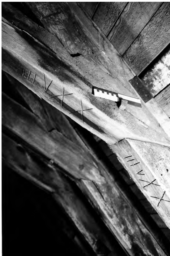
Fig. 35 : Marques d'assemblage en pied d'écharpe.
