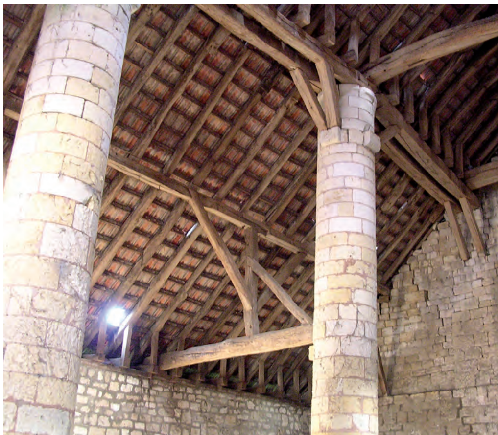
Fig. 160 : Bas-côté de la grange de Warnavillers (Oise), 1189/1190d.
