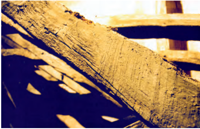
Fig. 71 : Traces de sciage et de taille à la hache.
