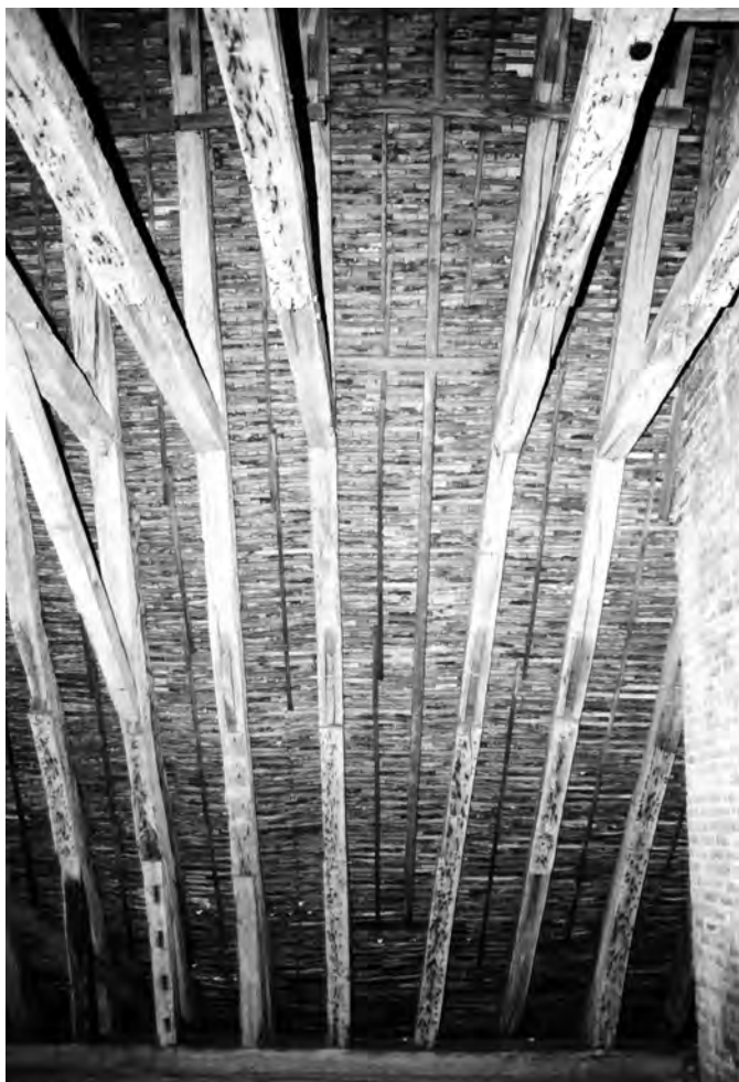
Fig. 9 : Dévers accidentel des fermes du dortoir.
