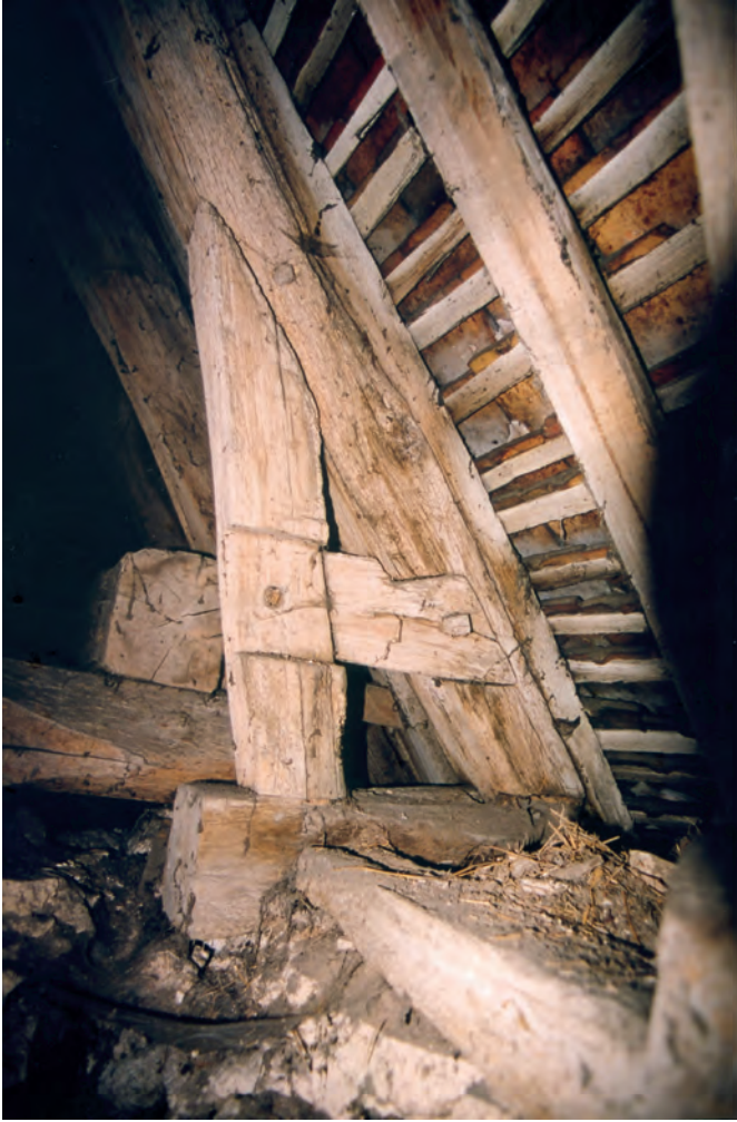
Fig. 13 : Ferme principale occidentale : extrémité de l'entrait assemblé par mi-bois au pied du chevron et de la jambe de force, destiné à « enjamber » la voûte.
