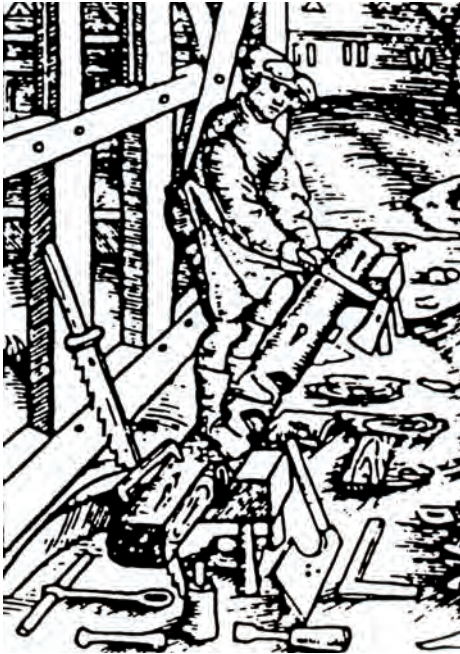
Fig. 34 : Ébauchage : exécution d'entailles préliminaires à l'équarrissage. Gravure allemande du XVII e siècle (HARRIS 1978).
