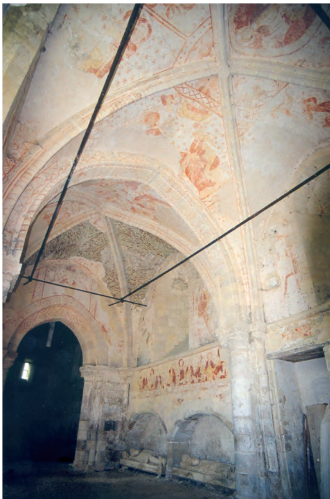
Fig. 11 : Voûtes sur croisées d'ogives du chœur.
