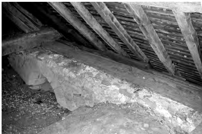
Fig. 139 : Sablière à languette discontinue (1005-1015d). Église de Cormeilles-en-Vexin (Val-d'Oise).
