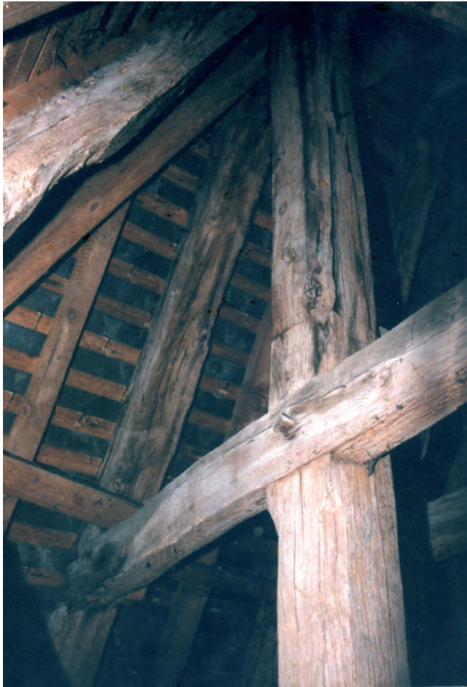
Fig. 43 : Enfourchement des deux parties du poinçon au-dessus du faux-entrait.
