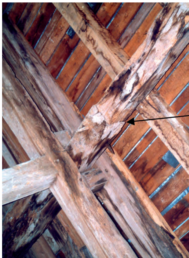
Fig. 12 : Enture pyramidale de deux pannes en surplomb de la ferme.
