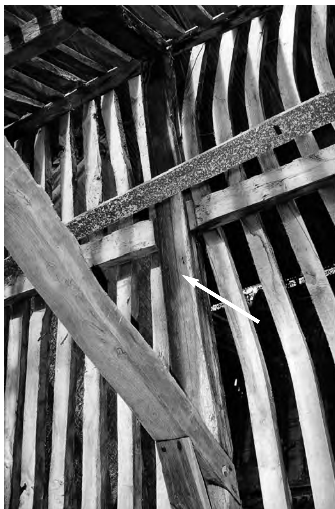
Fig. 48 : Lignage à trait unique. Cathédrale de Bayeux, chapelle de la Conception, chevron en réemploi (1225d).
