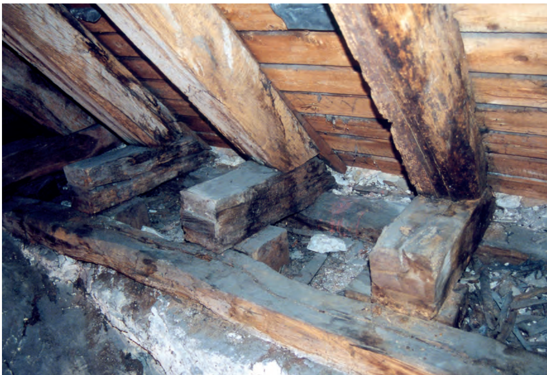
Fig. 13 : Blochets des chevrons avec tenons sciés destinés à l'origine à une entretoise.
