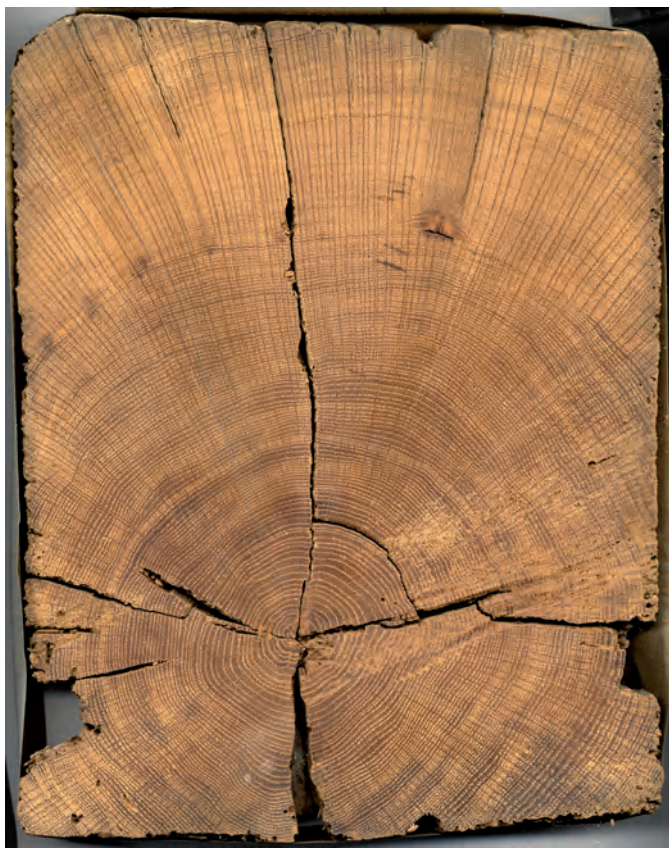
Fig. 15 : Section transversale de chêne (28 x 35 cm) provenant d'un entrain roman de Saint-Martin-de-Boscherville. On notera le grand nombre de cernes chez des individus qui pouvaient atteindre 200 à 300 ans. Dans la partie inférieure de la poutre, deux rainures recevaient les planches du plafond des années 1130 (cl. V. Bernard).
