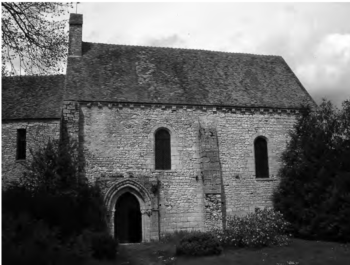
Fig. 2 : Élévations sud de la chapelle (1183-1192d).
