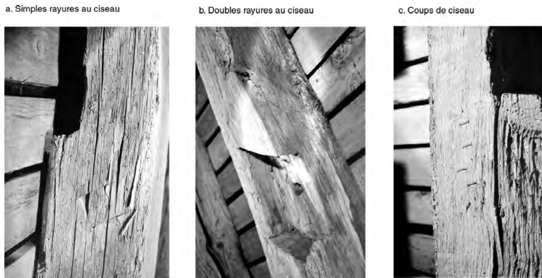
Fig. 20 : Marques d'assemblages des chevrons romans de la nef.
