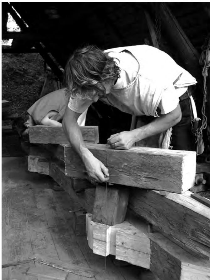
Fig. 63 : Piquage au fil à plomb. Chantier expérimental de Guédelon (Yonne).
