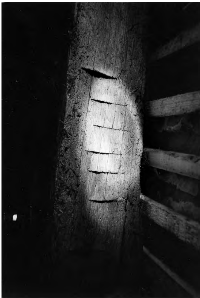
Fig. 76 : Marque à bâtonnets inscrite par griffure au ciseau. Église de Saint-Sulpice-sur-Risle (fin du XII e siècle).
