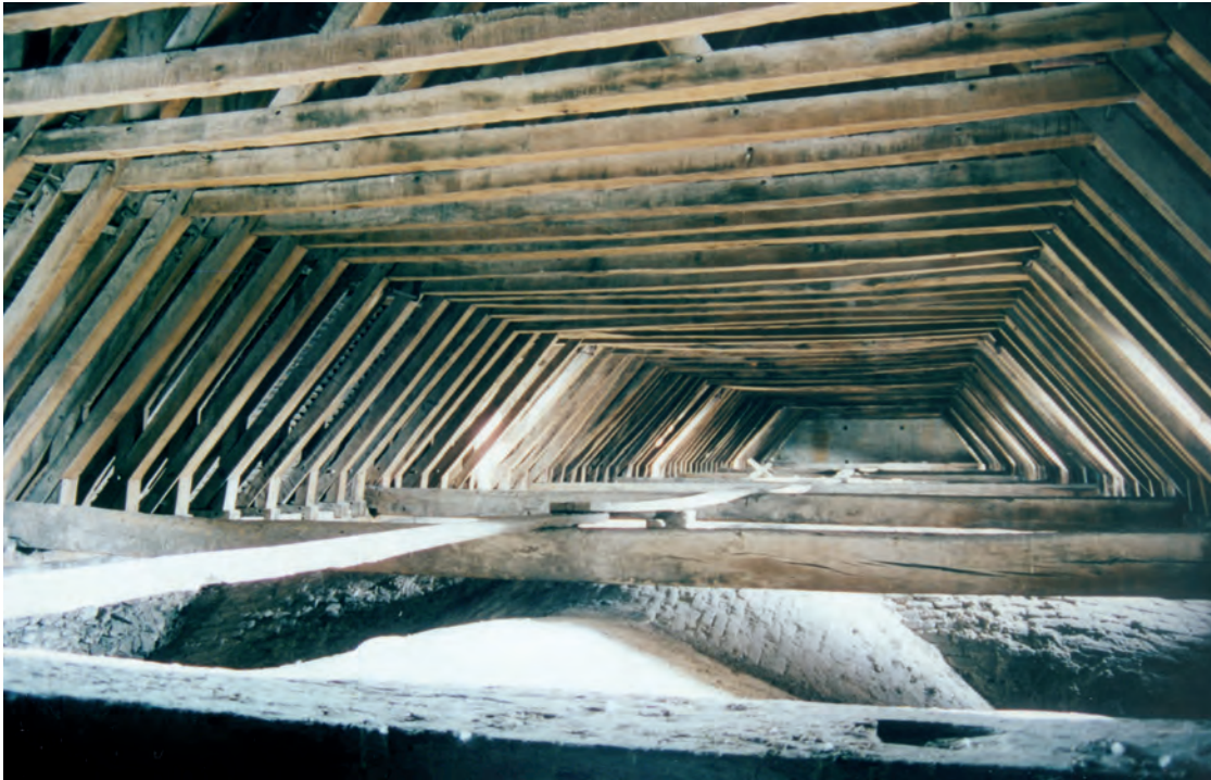
Fig. 9 : Charpente de la nef (1182/1183d).
