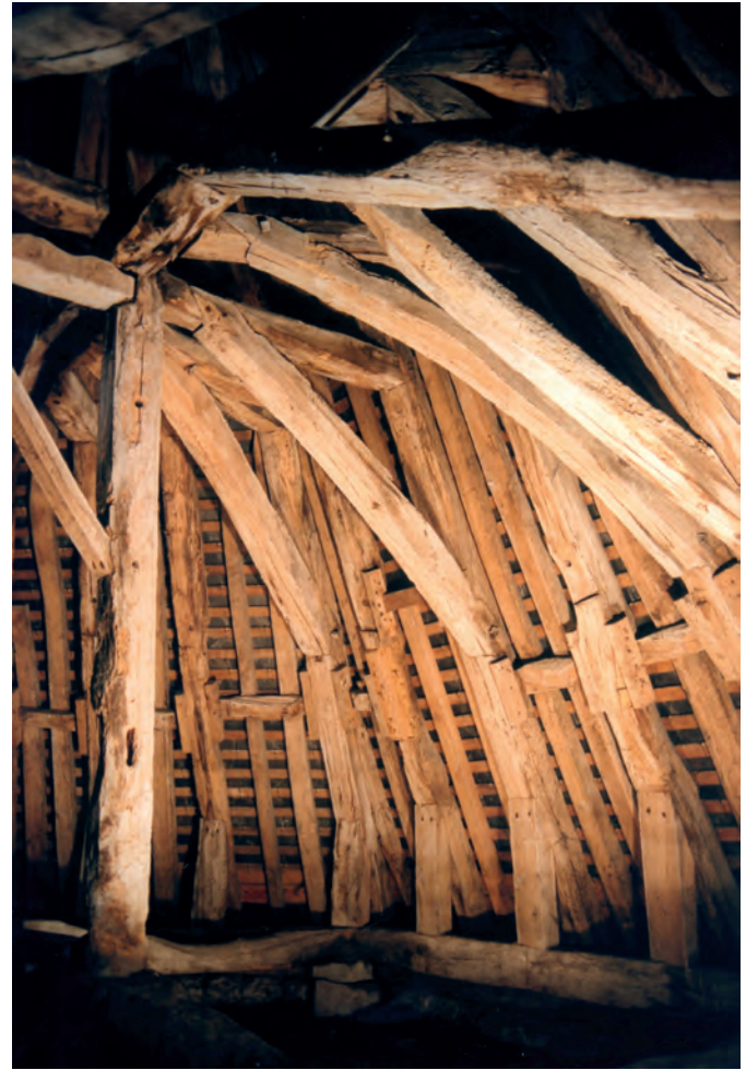
Fig. 44 : Croupe de la charpente de la chapelle axiale.
