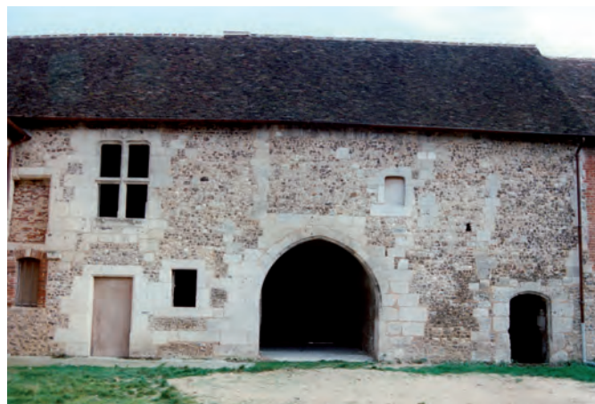
Fig. 5 : Bâtiments C et D, façade sur cours.
