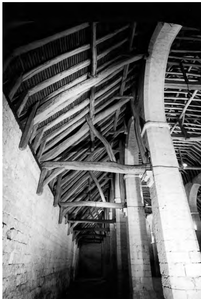
Fig. 172 : Charpente du bas-côté nord de la grange Saint-Lazare de Beauvais, 1219/1220d.
