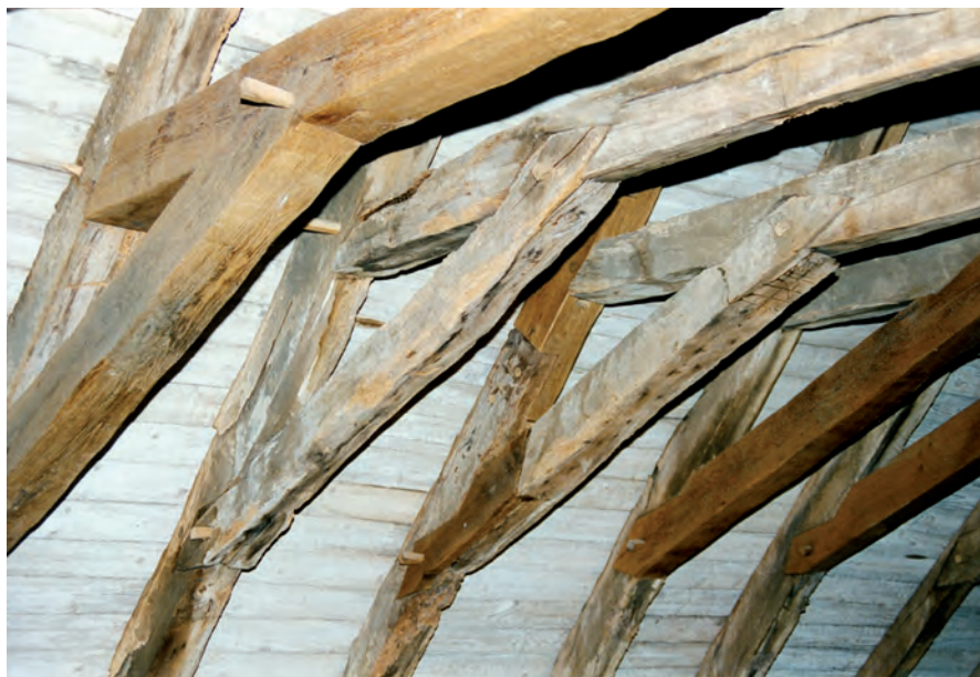
Fig. 8 : Aisseliers droits assemblés par mi-bois.
