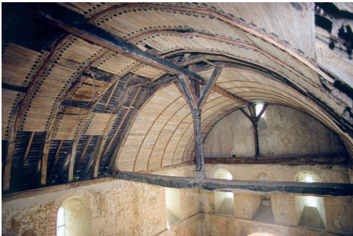
Fig. 5 : Charpente de la nef (vers 1144d) avec son cours de liernes longitudinales (rajouté vers 1290d) soutenant les fermes secondaires.
