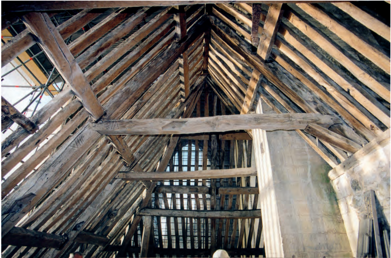
Fig. 49 : Ferme en réemploi.
