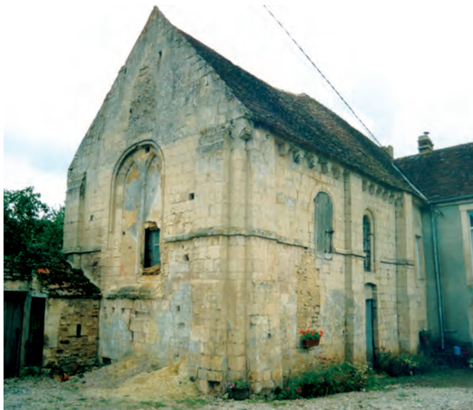
Fig. 2 : Chevet de la chapelle de Voismer vue du nord-est.
