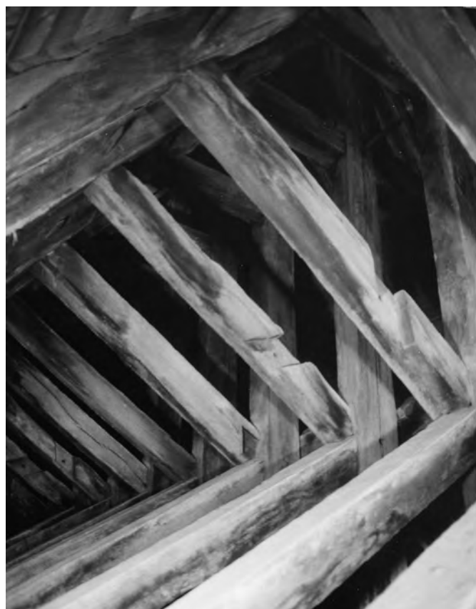
Fig. 29 : Bois de 1195d réemployés dans la charpente de la nef de la cathédrale de Rouen, levée entre 1227 et 1232d.
