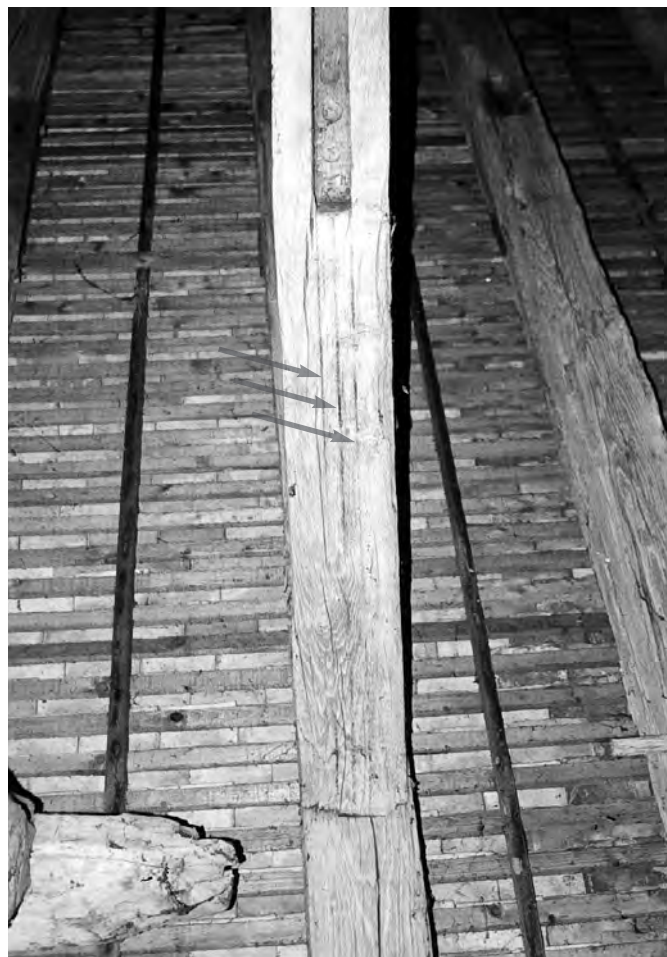
Fig. 50 : Lignage à triple traits. Abbaye de Bonport (Eure), dortoir (1221d), entrain retroussé.
