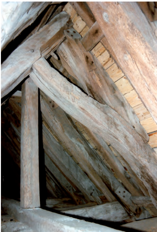
Fig. 84 : Tête torse d'un chevron greffé d'un about.
