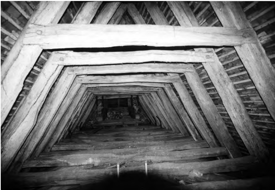
Fig. 6 : Fermes du chœur, face ouest. Faux-entraits assemblés à mi-bois.
