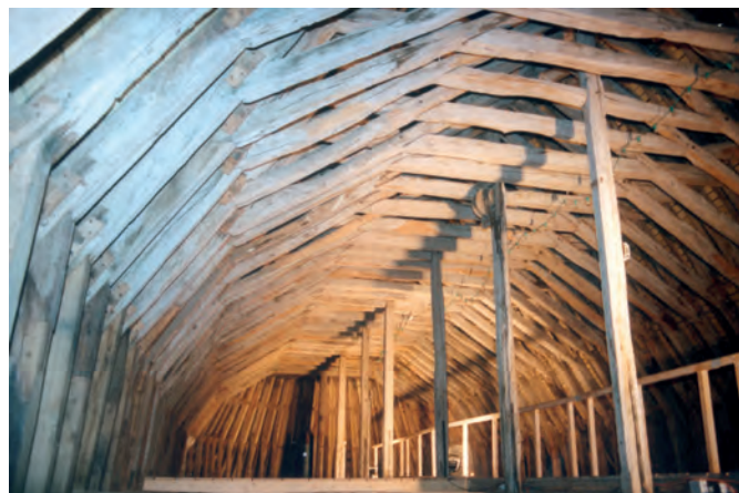
Fig. 51 : Charpente du chœur après restauration.
