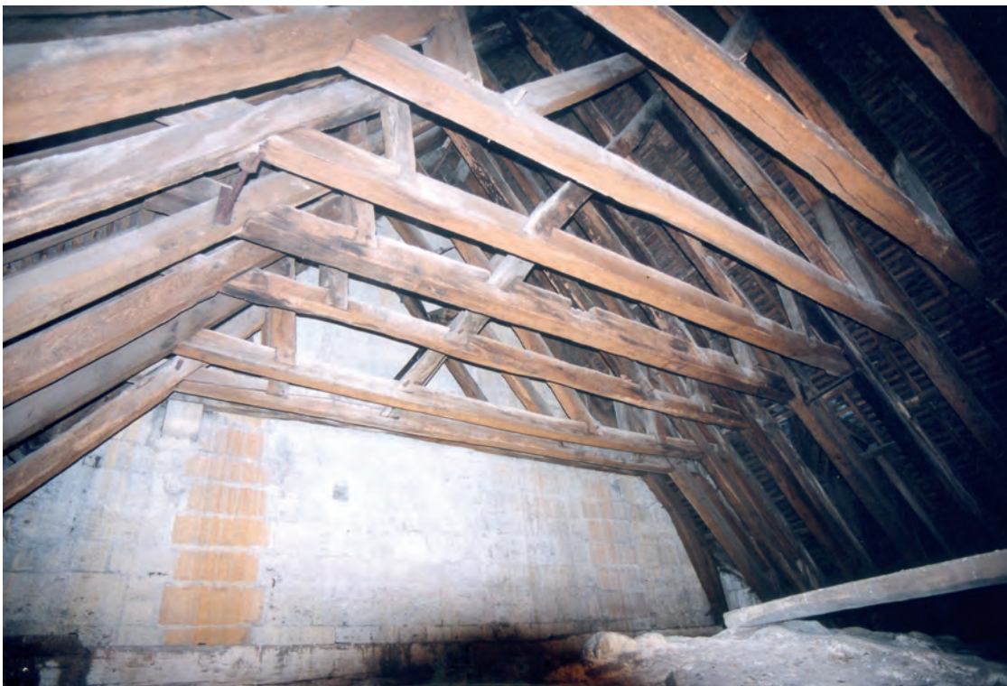
Fig. 10 : Fermes placées contre la tour-lanterne de la croisée du transept.
