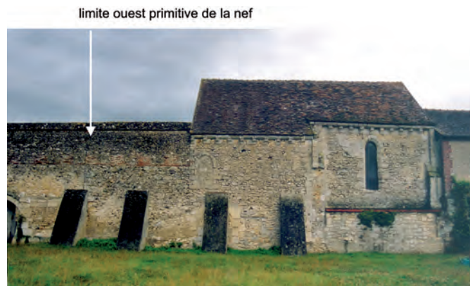
Fig. 2 : Élévations sud intégrées dans le mur d'enclos, avec l'extrémité d'origine de la nef (à droite) et sa baie centrale murée.
