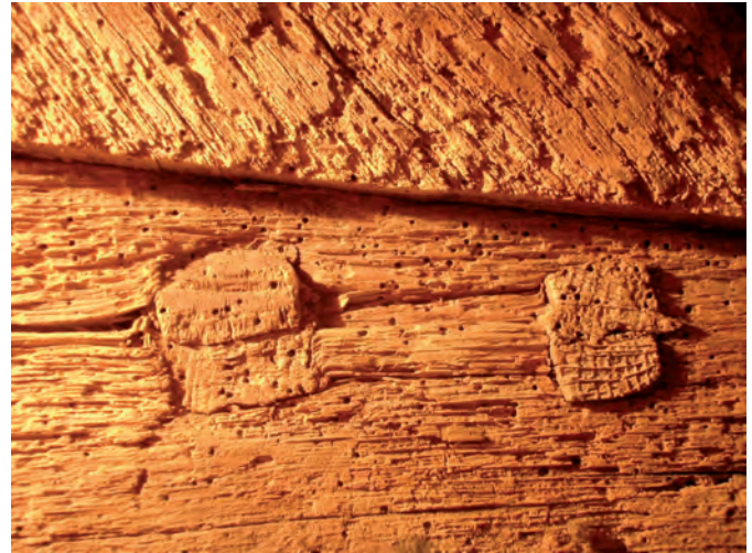
Fig. 105 : Coins enfoncés dans la tête des chevilles. Grange Saint-Lazare de Beauvais (1220d).
