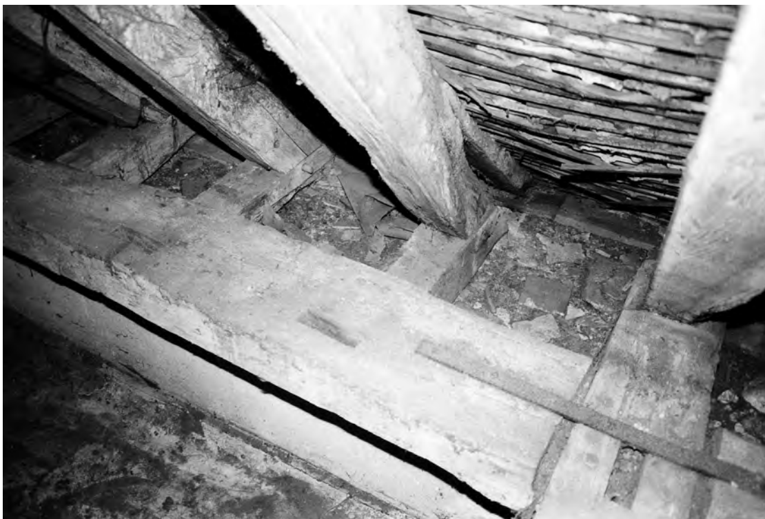
Fig. 7 : Pied de fermes secondaires : blochets assemblés aux chevrons et à l'entretoise.
