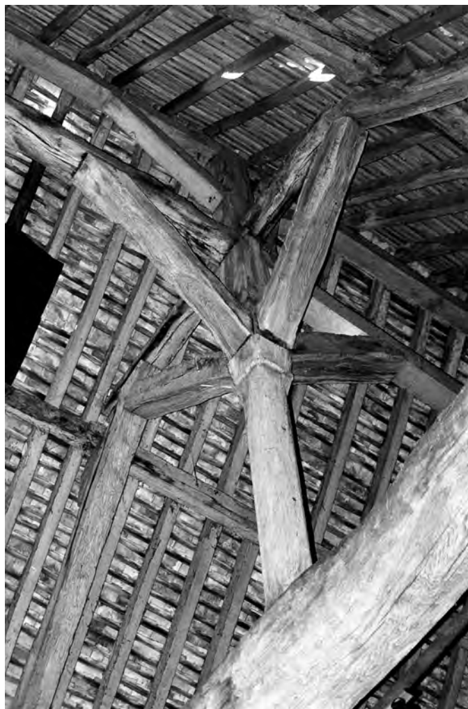
Fig. 5 : Poinçon d'une ferme principale avec les aisseliers retombant en butée sur un chapiteau.
