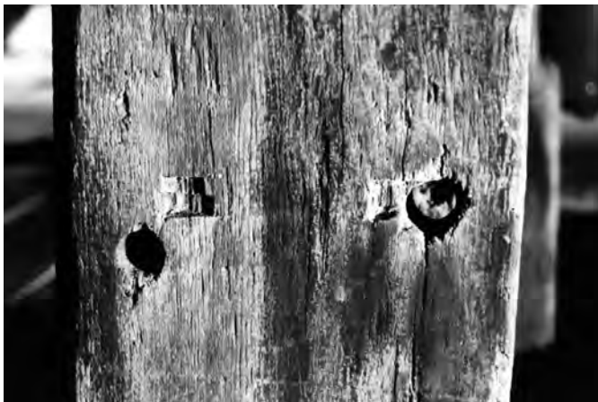
Fig. 66 : Traces de piquage des trous de cheville. Cathédrale de Rouen, vers 1230d.
