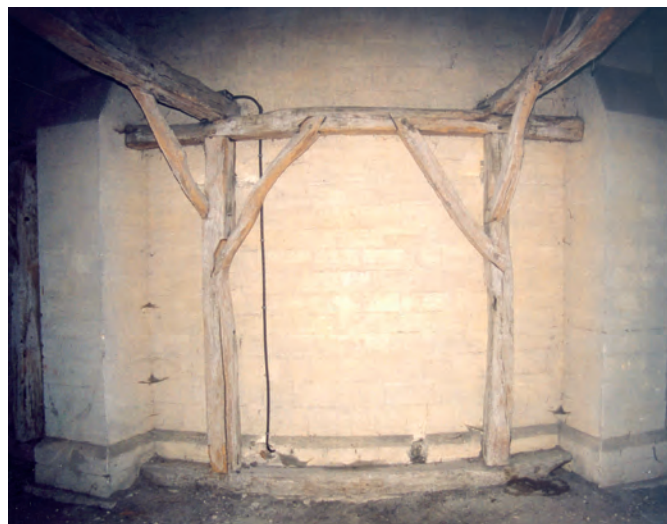
Fig. 28 : Pan interne avec sablières courbes disposées contre le mur absidial.
