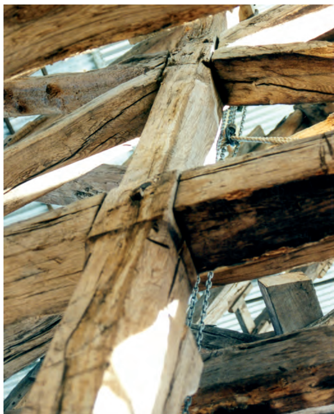
Fig. 55 : Faux-poinçon d'une ferme principale, les chanfreins s'arrêtent au droit des assemblages.
