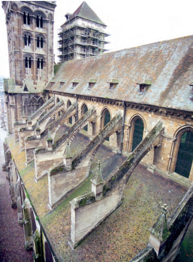
Fig. 4 : Arcs-boutants du bas-côté sud de la nef et tours de façade occidentales.
