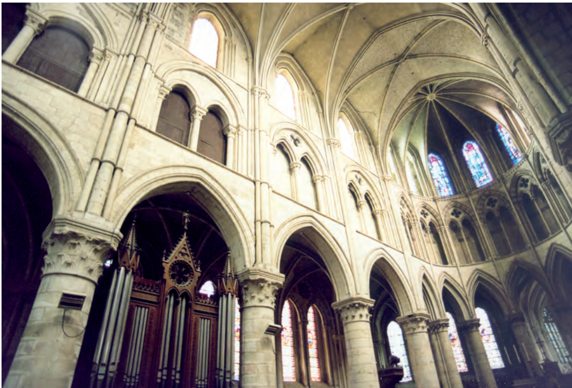
Fig. 7 : Élévations nord du chœur.
