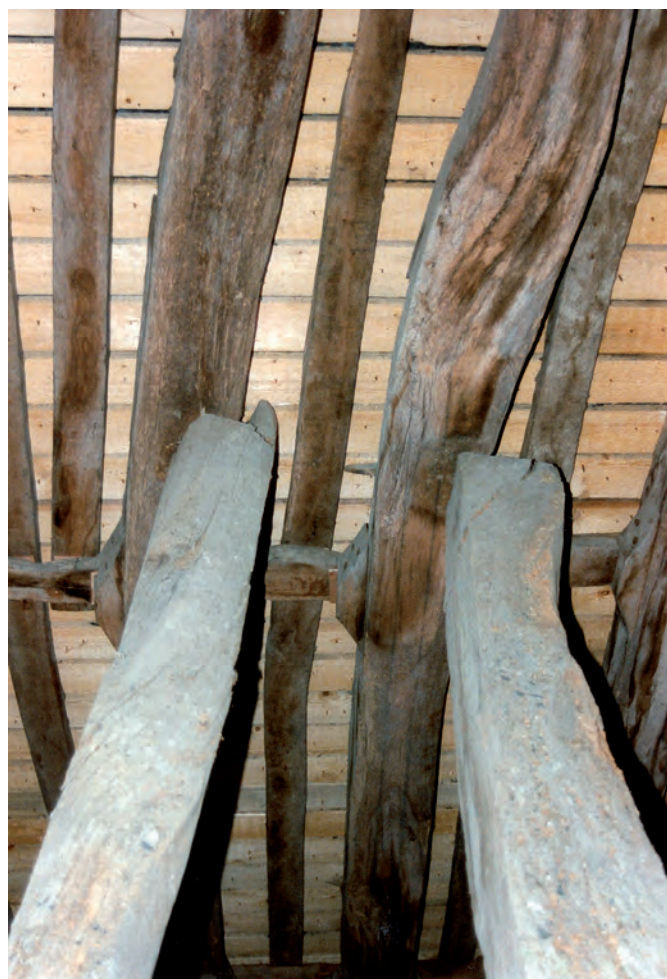
Fig. 82 : Déviation des chevrons et absence d'assemblage des écharpes.
