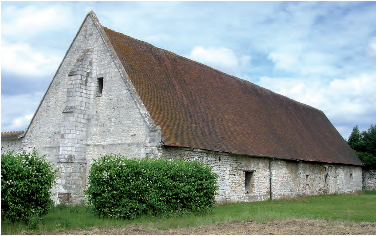
Fig. 23 : Grange de l'abbaye de Bonport, pignon ouest et gouttereau sud.
