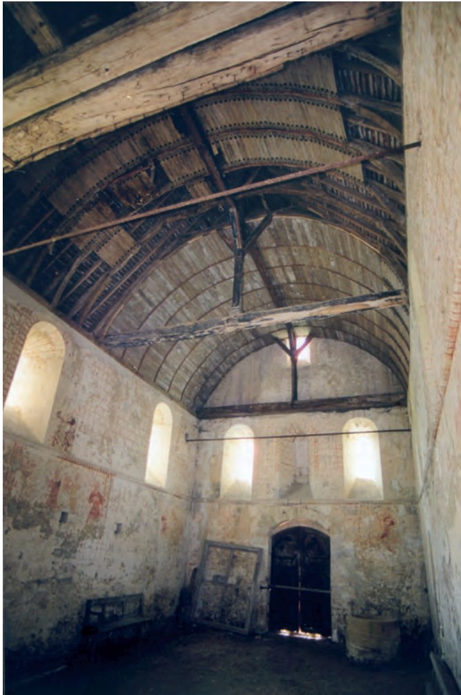
Fig. 4 : Nef vue du chœur avec sa charpente voûtée lambrissée.
