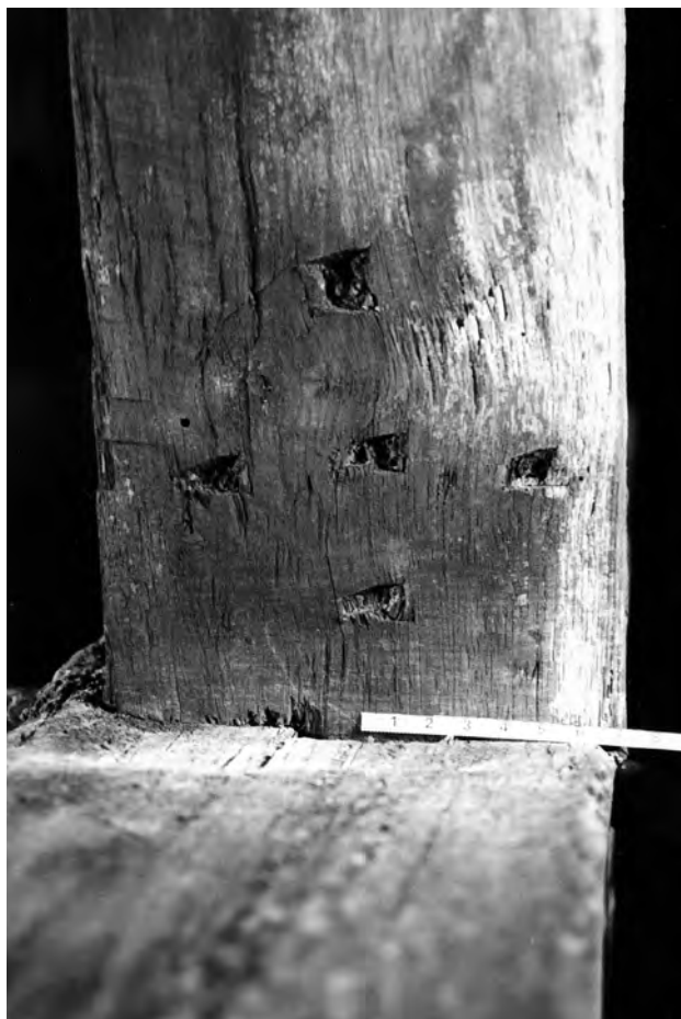
Fig. 14 : Marque particulière à encoches.
