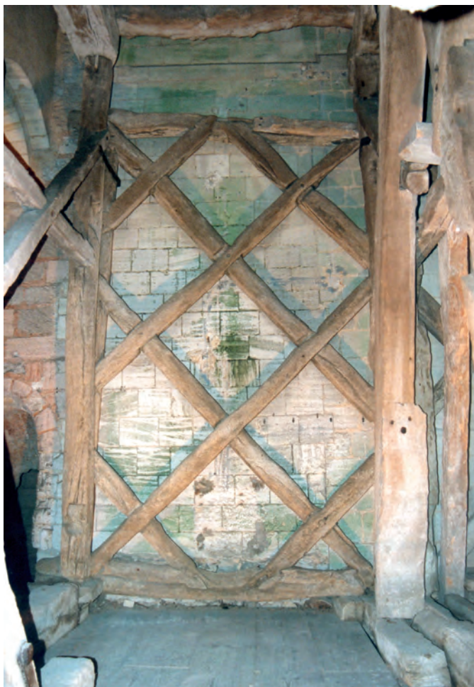
Fig. 9 : Beffroi de la tour nord, pan est.
