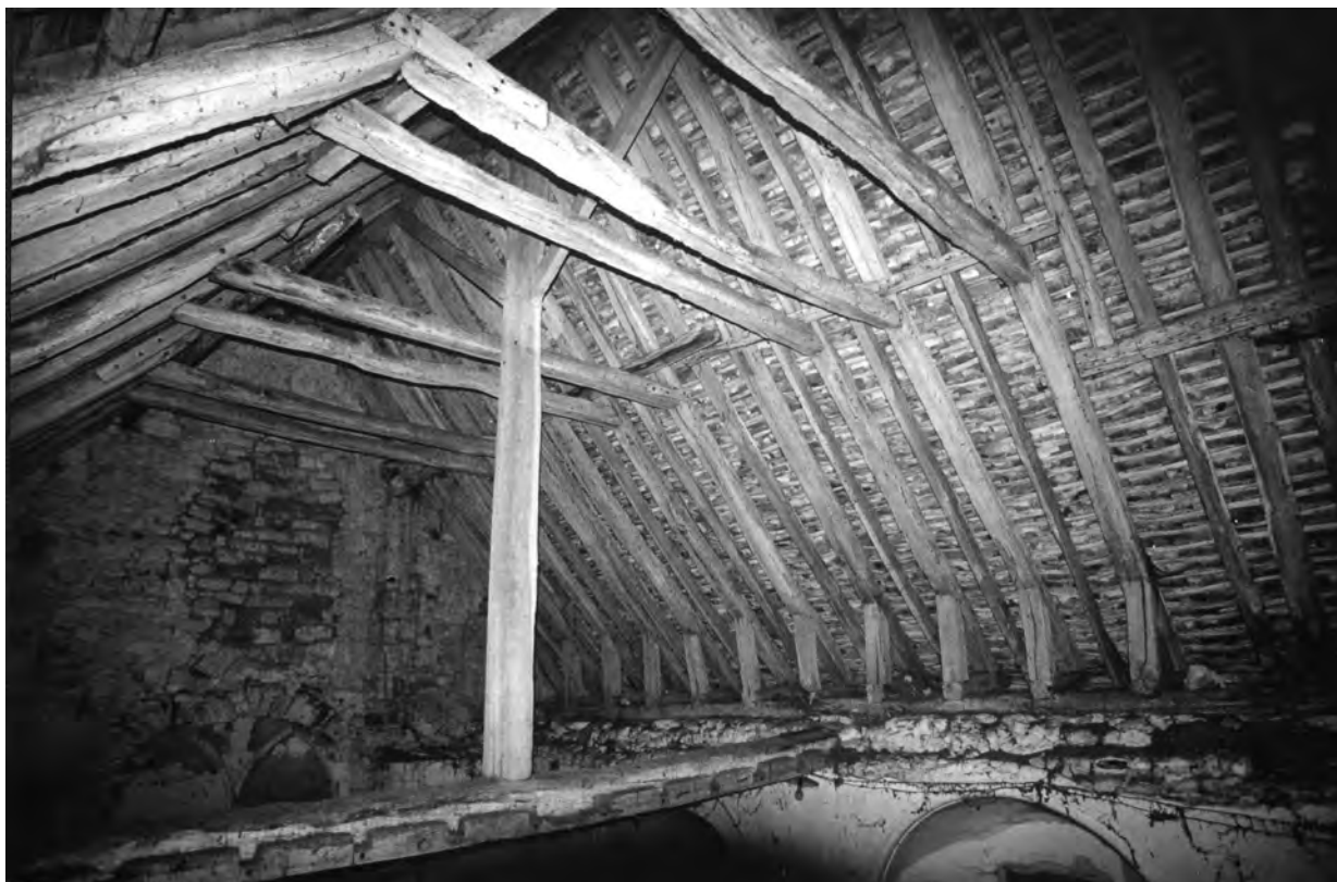
Fig. 7 : Charpente du chœur avec rajout au centre d'une ferme à poinçon pour soutenir un faîtage.
