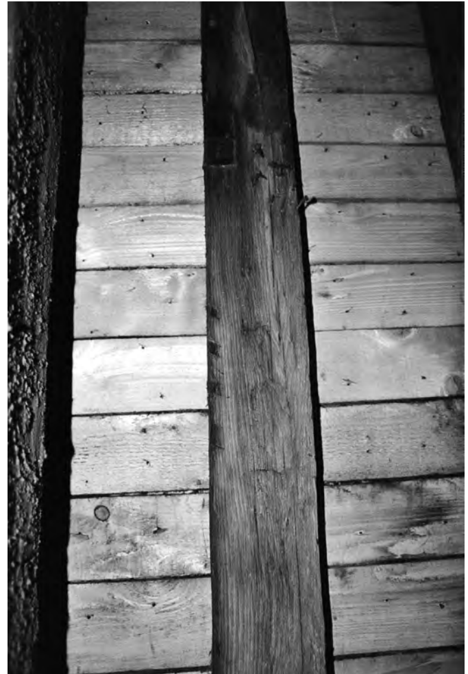
Fig. 72 : Encoches sur arête. Église Saint-Germain-des-Prés, Paris (1018-1038d).
