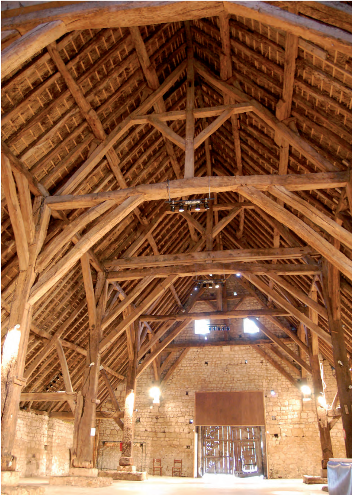
Fig. 2 : Intérieur de la grange.
