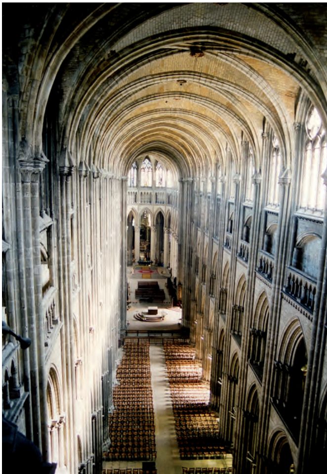
Fig. 2 : Nef vue depuis le massif occidental.
