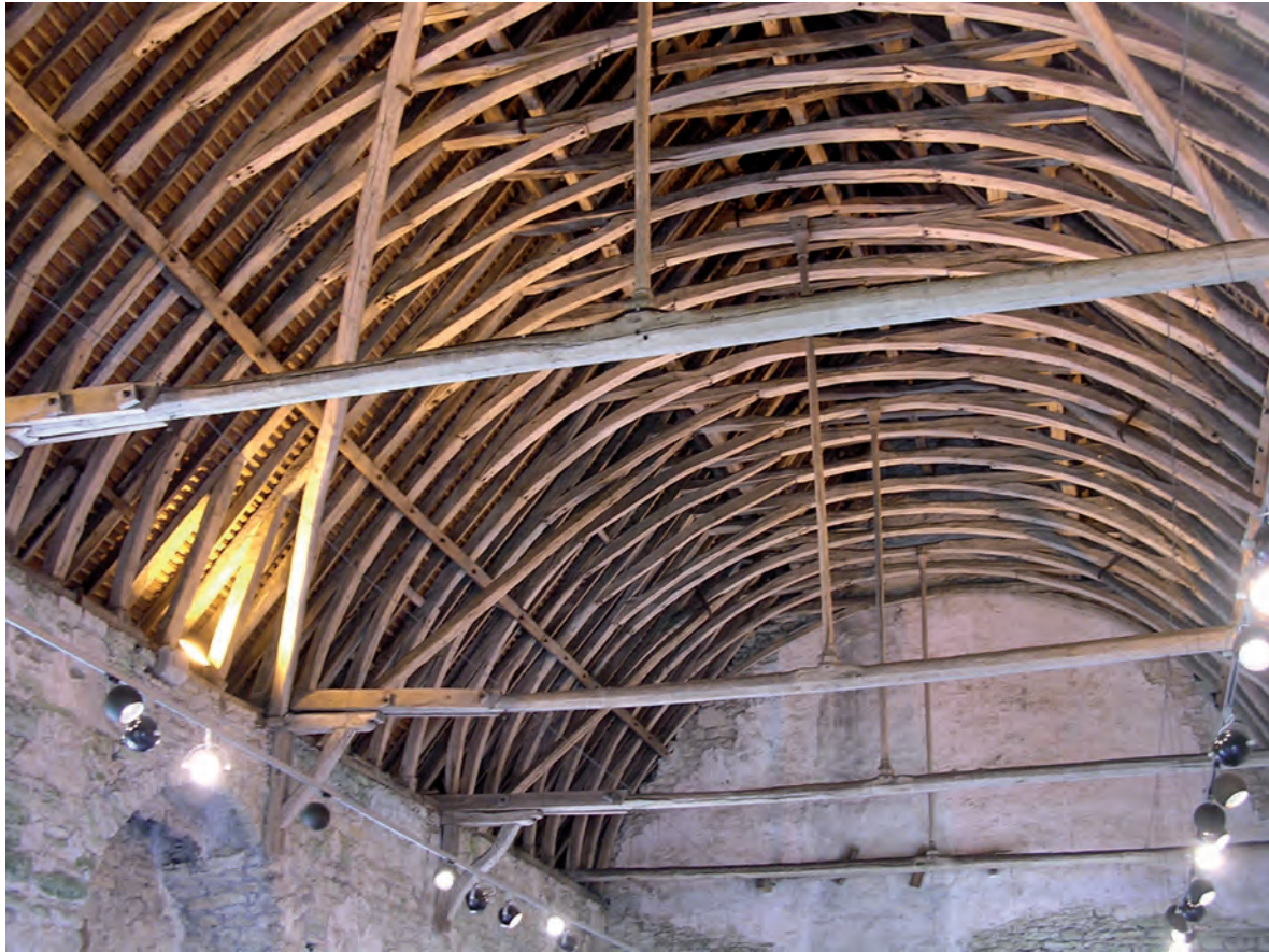
Fig. 162 : Charpente du château de Crépy-en-Valois (Oise), début du XIII e siècle.
