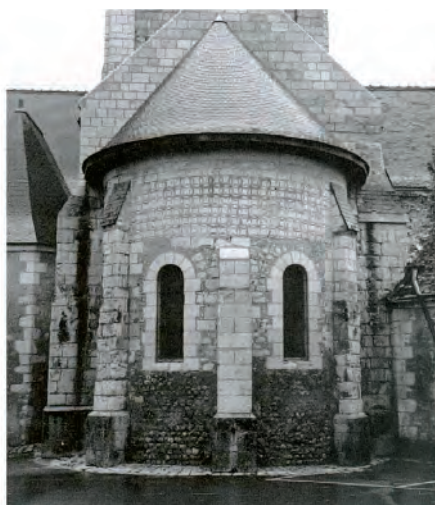
Fig. 152 : Débord de la charpente, vers 1173d. Abside de l'église de Monthou-sur-Cher (Loir-et-Cher) (CRMH 2002, p. 32).
