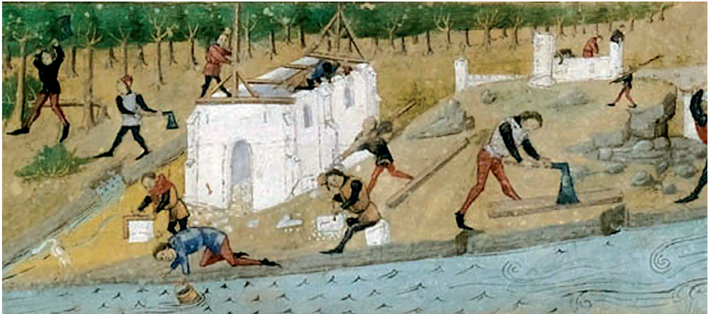
Fig. 91 : Plancher de travail disposé sur des entrâits (Grandes Chroniques de France par Robinet Testard, Paris, BnF, ms. fr. 2609, fol. 12, 1471).
