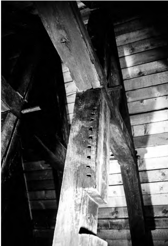
Fig. 12 : Marque à encoches sur un poinçon réemployé (1195-1200d).
