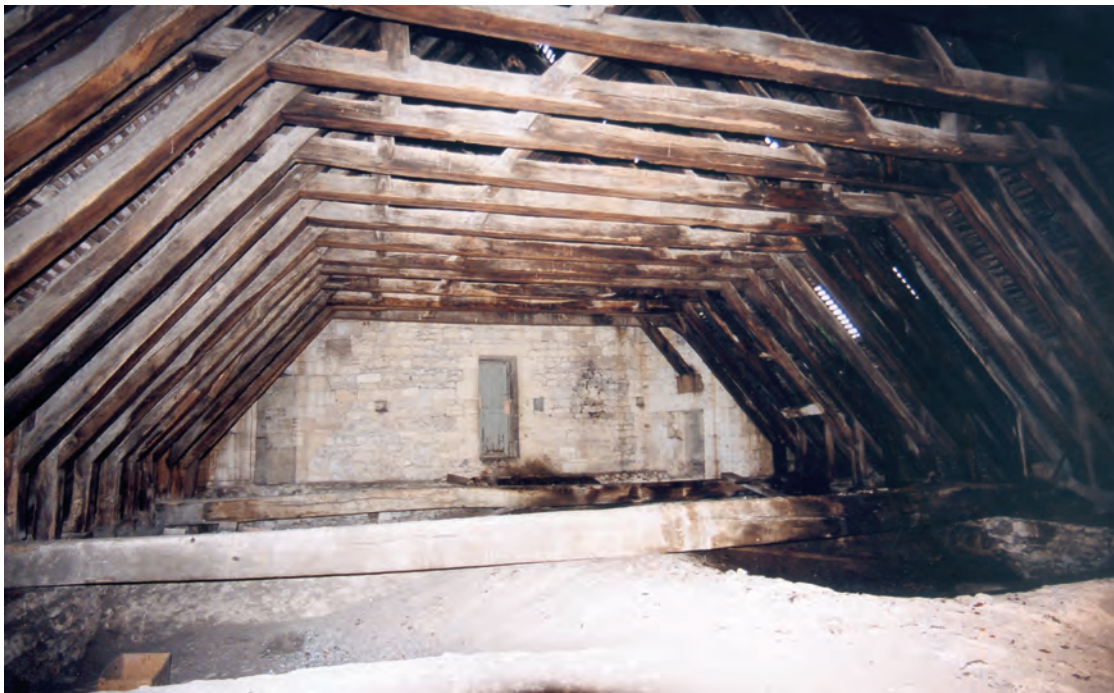
Fig. 16 : Charpente du croisillon nord (1192-1202d).
