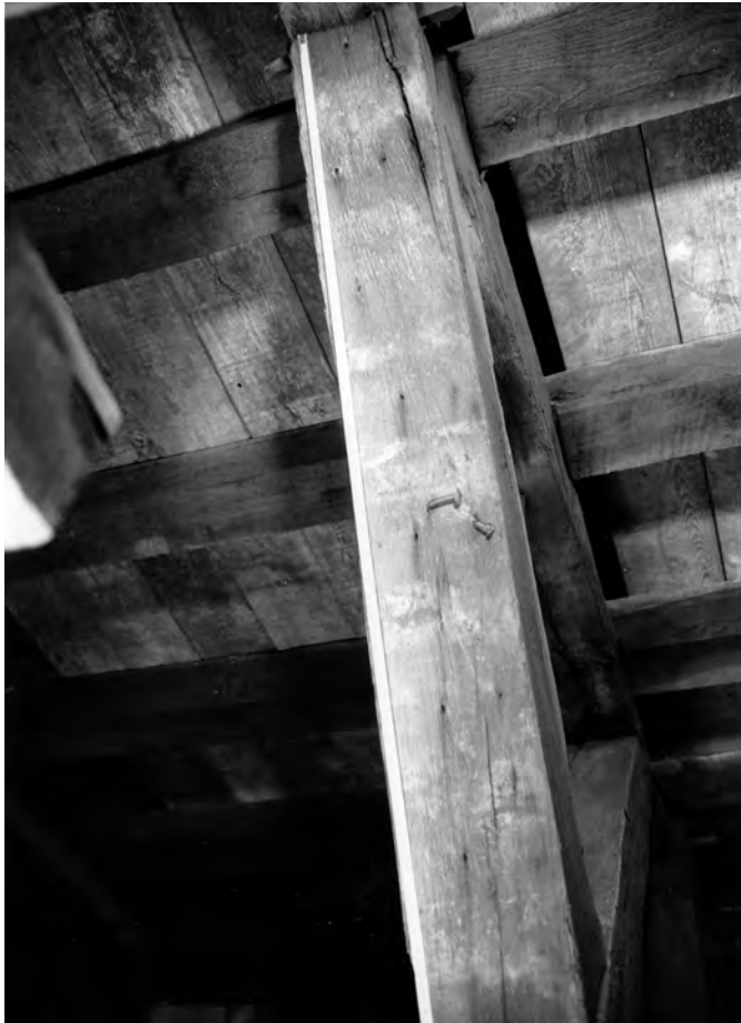
Fig. 15 : Chevron en réemploi : négatifs du voligeage (1195-1200d).
