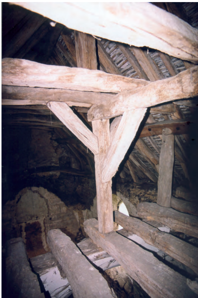
Fig. 7 : Dispositif longitudinal de soutien : lierne portée par un potelet, maintenu par des liens obliques, sur le solivage inséré au XVIII e siècle.
