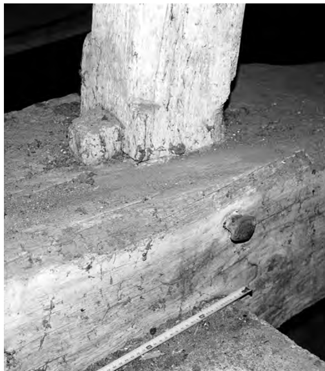
Fig. 6 : Pied de poinçon bloqué par une cheville métallique et un rossignol.
