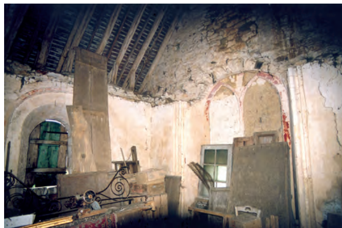
Fig. 4 : Baies en plein cintre du chevet avec les arrachements de sa voûte.
