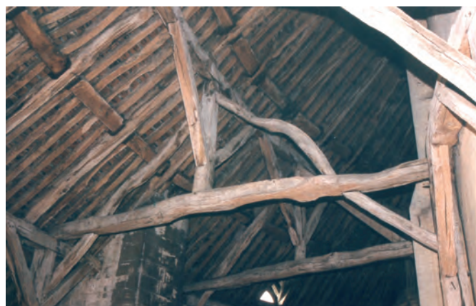
Fig. 29 : Ferme 16 sur portique avec ses bois tors.
