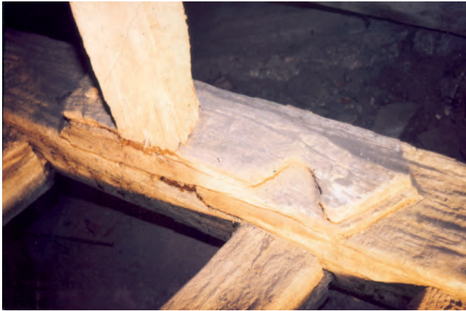
Fig. 7 : Extrémité du faux-entrait de la ferme de croupe réemployée en semelle en 1708.
