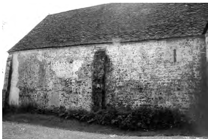
Fig. 2 : Élévations nord, avec à droite le mur de la nef du XI e siècle, et à gauche le mur du chœur de la seconde moitié du XII e siècle.
