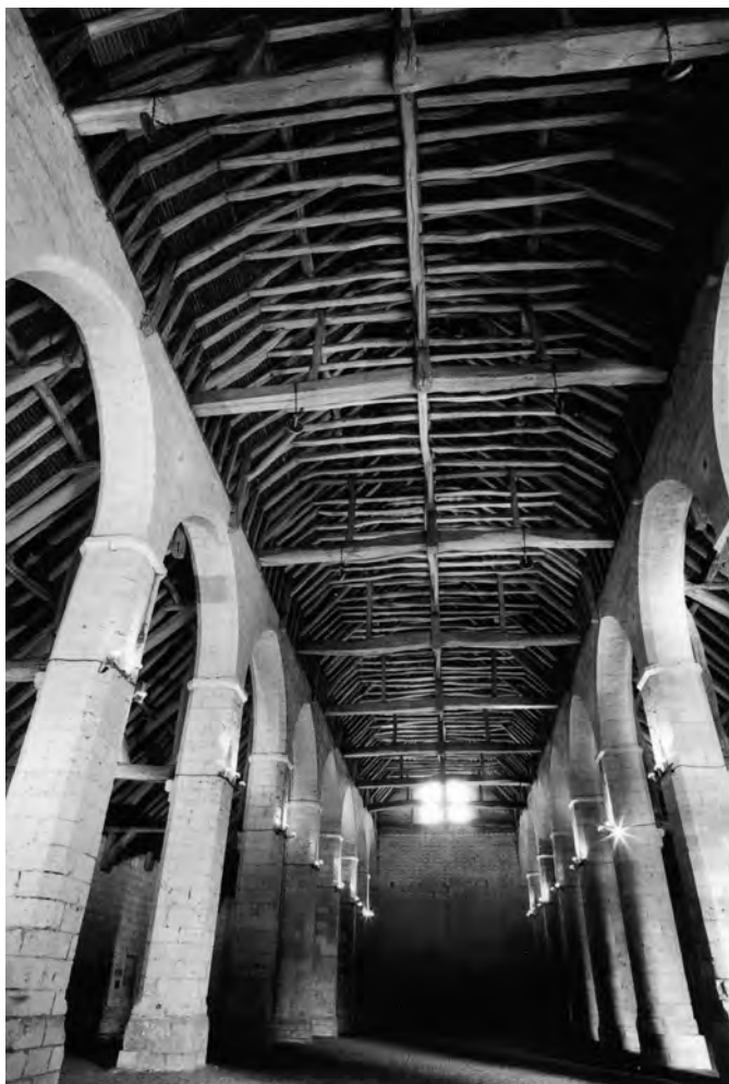
Fig. 171 : Grange Saint-Lazare de Beauvais, 1219/1220d.
