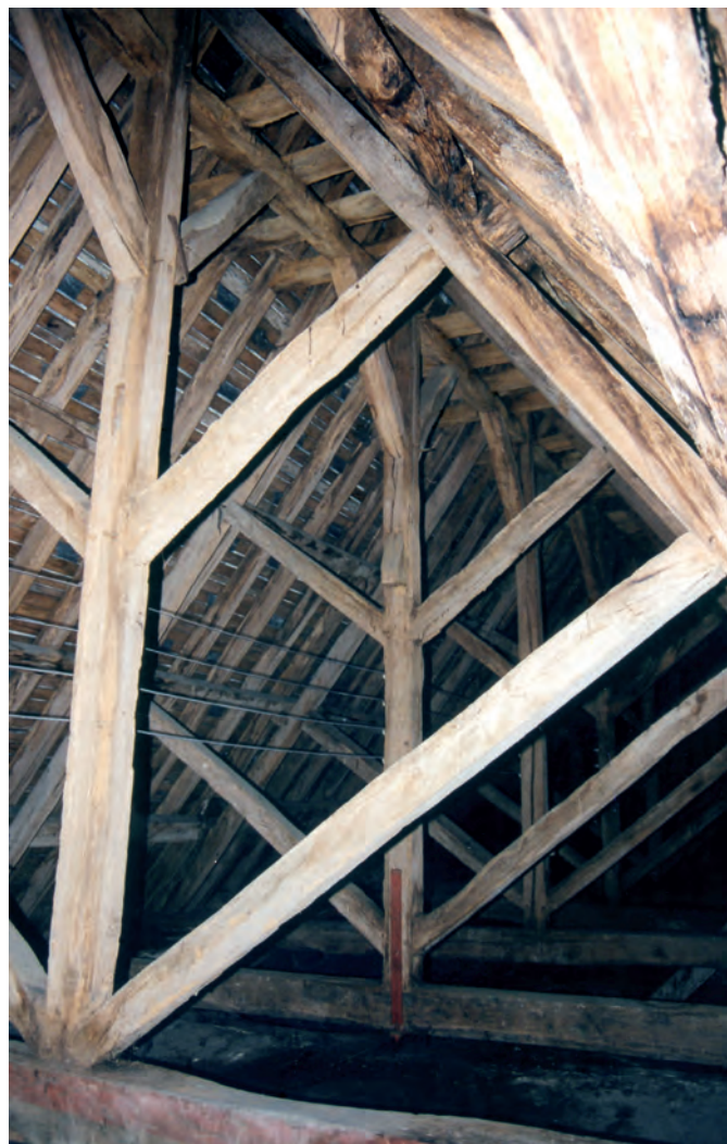
Fig. 6 : Charpente de la nef (1217-1223d).
