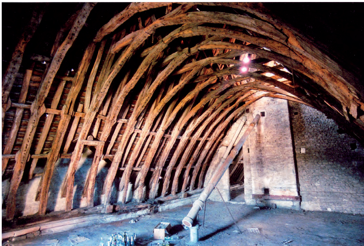
Fig. 5 : Charpente voûtée de la salle haute (1226d).
