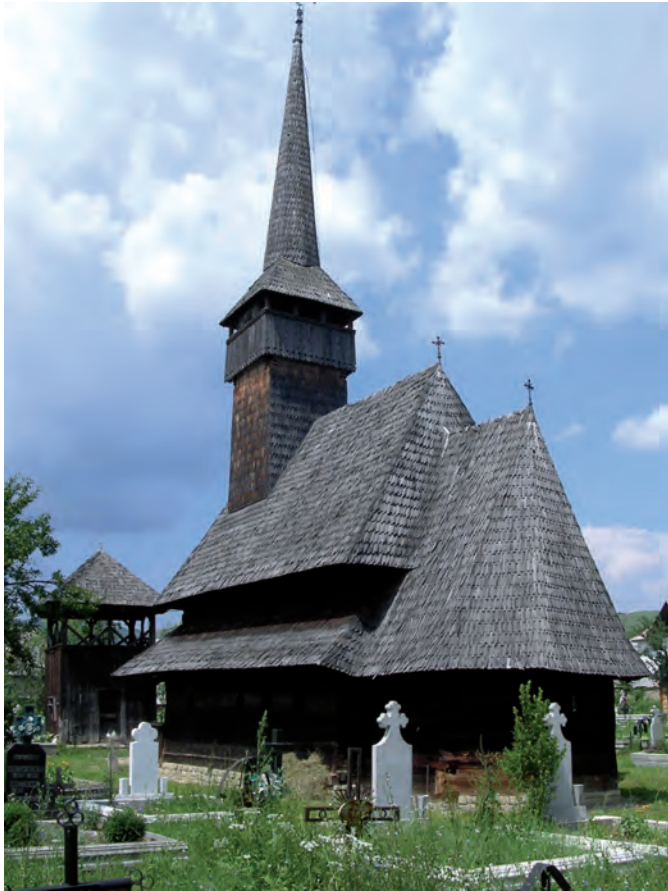
Fig. 110 : Église en bois couverte d'essentes avec son beffroi en arrière-plan, Rozavlea, Maramures (Roumanie).
