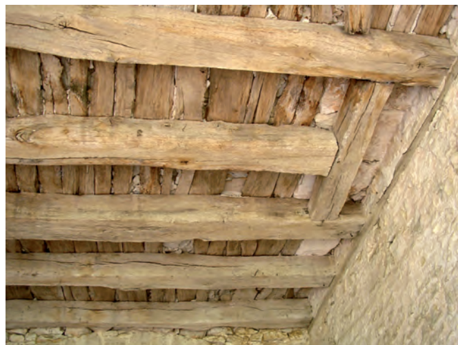
Fig. 14 : Solives et trémie du plafond.
