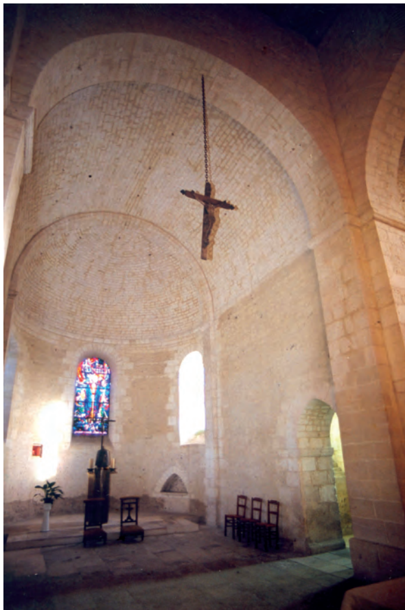
Fig. 3 : Voûte en berceau du chœur.
