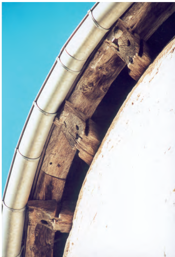
Fig. 148 : Extrémités des entrails sculptées en forme de modillon, 1127-1133d. Église de Neuf-Marché (Seine-Maritime).
