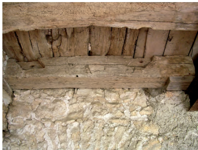
Fig. 15 : Bois en réemploi dans le solivage (1170-1209d).
