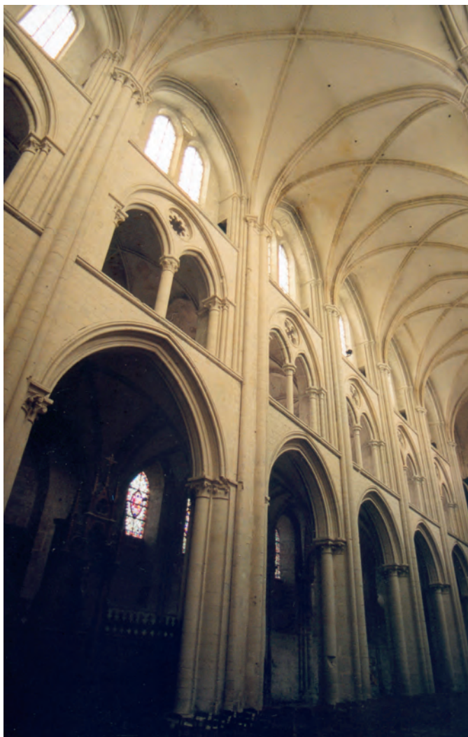
Fig. 5 : Élévations de la nef : raccord entre les deux campagnes.
