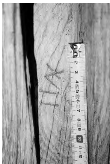
Fig. 81 : Marque inscrite par coups de ciseau au fond d'une mortaise. Abbaye de Bonport, Eure, dortoir (1221d).
