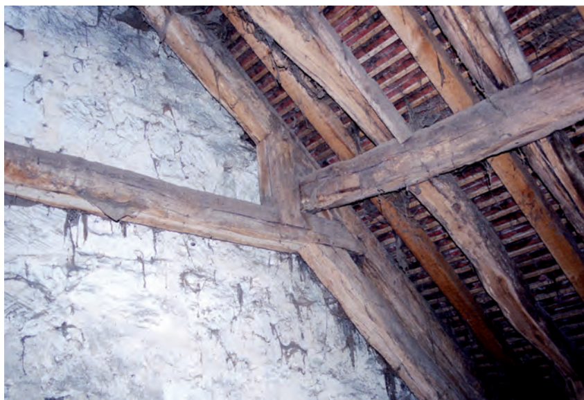
Fig. 6 : Calage de la panne sur le faux entrain par une petite contrefiche.
