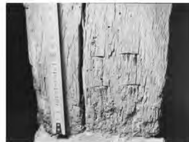
c. Marque à coups de ciseau du portique
