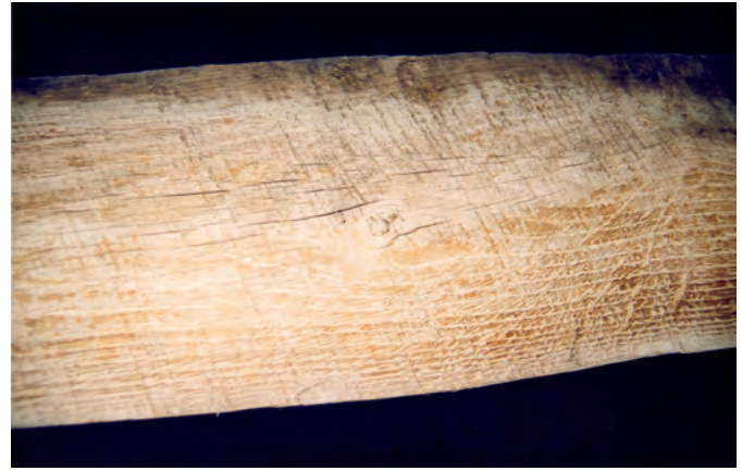
Fig. 72 : Vue rapprochée des traits de sciage.
