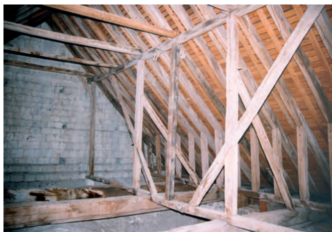
Fig. 9 : Portique de la charpente du croisillon sud.
