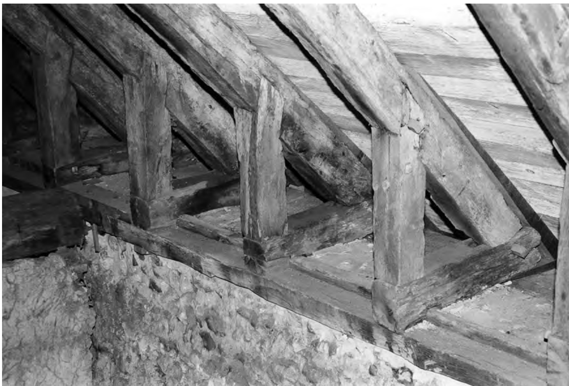
Fig. 141 : Sablière à languette continue, seconde moitié XII e siècle. Maladrerie de Gravigny (Eure).
