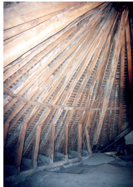
Fig. 37 : Croupe de la charpente de la chapelle nord du déambulatoire.
