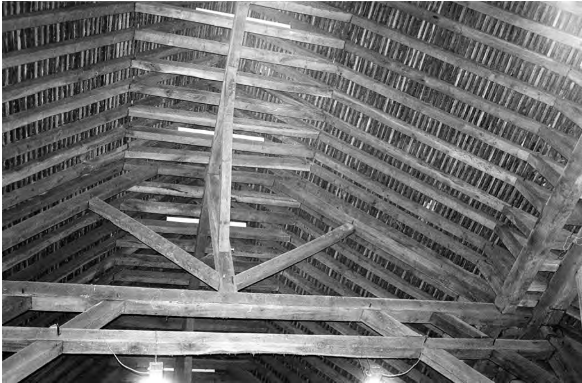
Fig. 7 : Fermes principale et secondaires de 1945.
