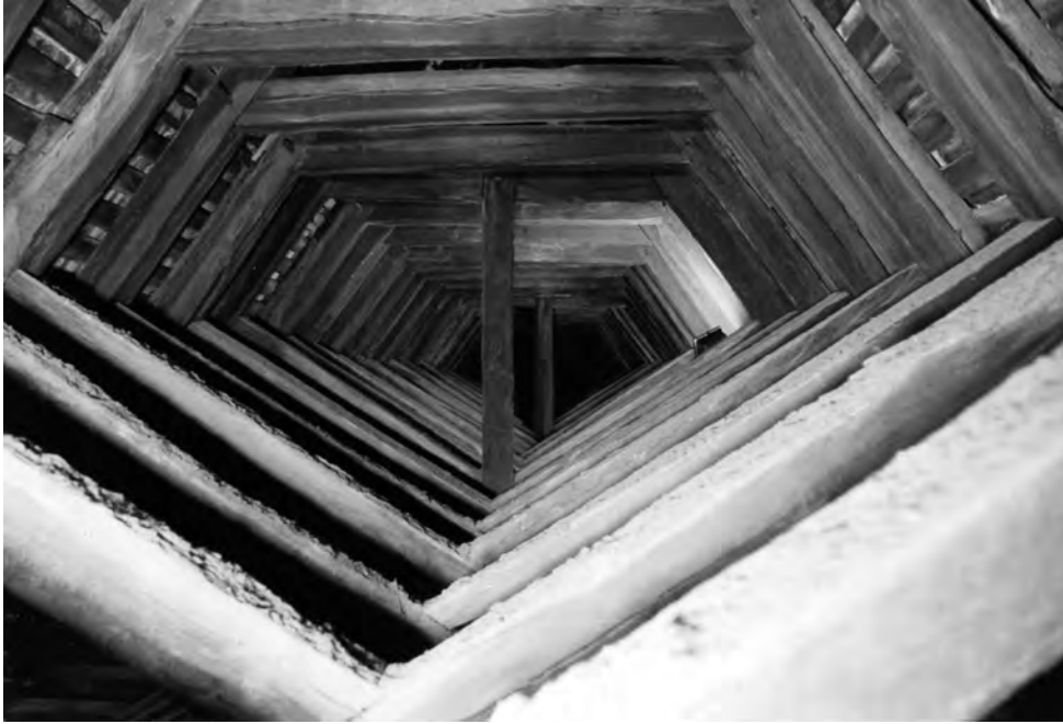
Fig. 17 : Charpente de la nef (1227-1232d).
