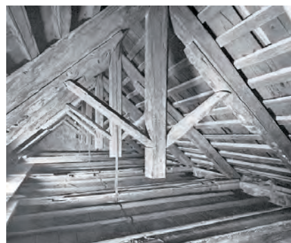
Fig. 166 : Charpente du monastère Sainte-Catherine du Mont Sinaï, vers 548-560, Égypte (FORSYTH et WEITZMANN 1975).
