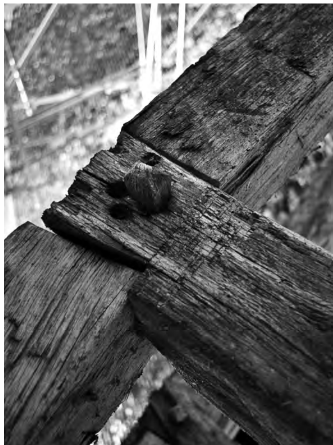
Fig. 64 : Traces de piquage d'un assemblage à mi-bois. Église de la Bussière-sur-Ouche, Côte-d'Or (1148/1149d).
