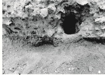
Poutre du radier disposée près du sol
