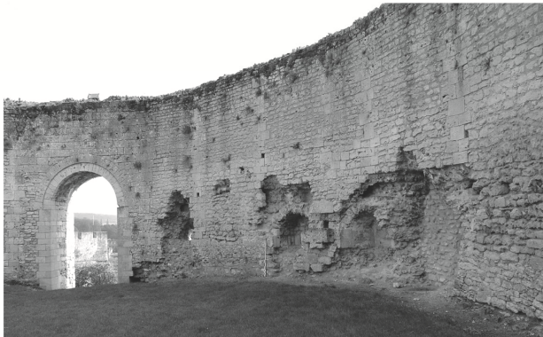
Intérieur de l'enceinte, vue vers le sud avec l'entrée et les arrachements du parement à droite, révélant le chaînage à mi-hauteur du mur
