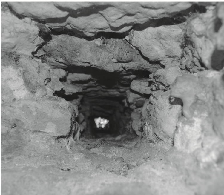
Fig.2 Logement parementé d'une pièce de charpente équarrie, dans le sens transversal du mur d'enceinte, shell-keep de Vatteville-la-Rue (76)
