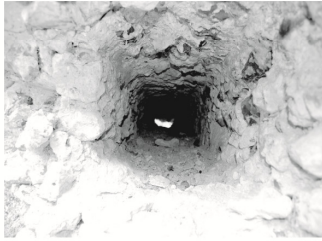
Logement d'une longrine
