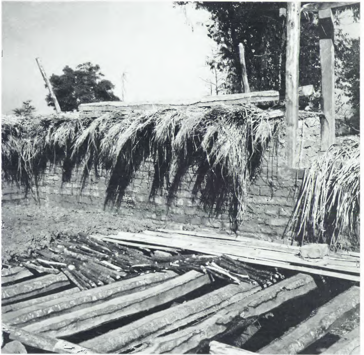
43. Hourdage du plancher : sur un lattis de petits bois et de tiges de bambou, on pose de la boue.
