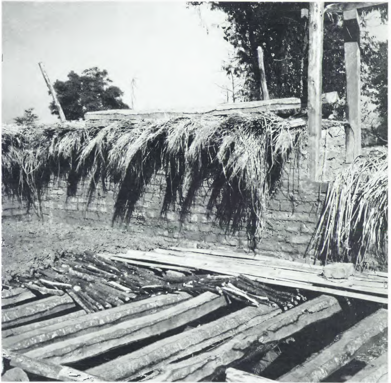
43. Hourdage du plancher : sur un lattis de petits bois et de tiges de bambou, on pose de la boue.
