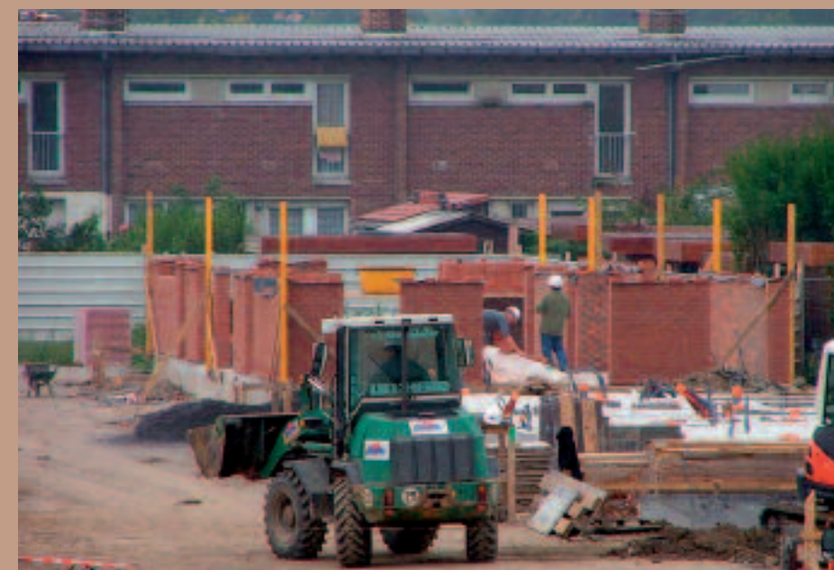
Photographies du chantier d'un îlot en 2008. Ville de Hem
