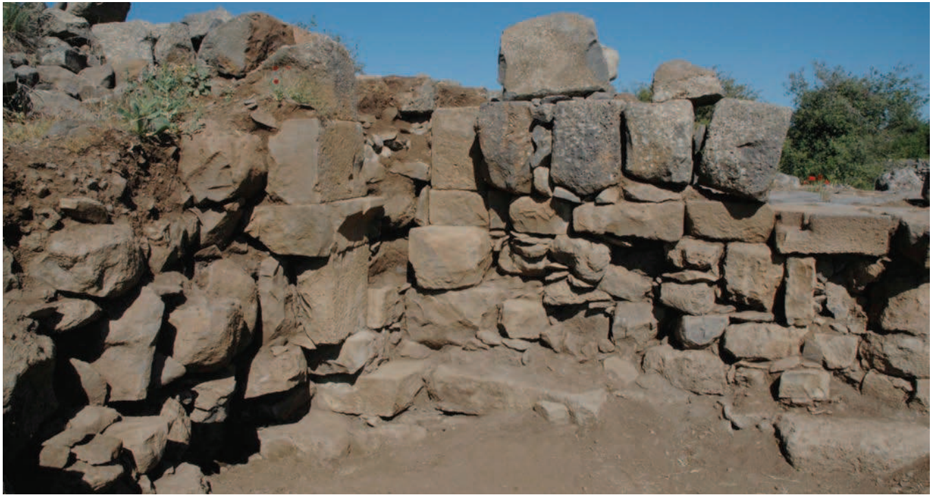
Fig. 3 Angle du mur à gradins avec la façade de la porte Nabatéenne (cliché P.-M. Blanc).
