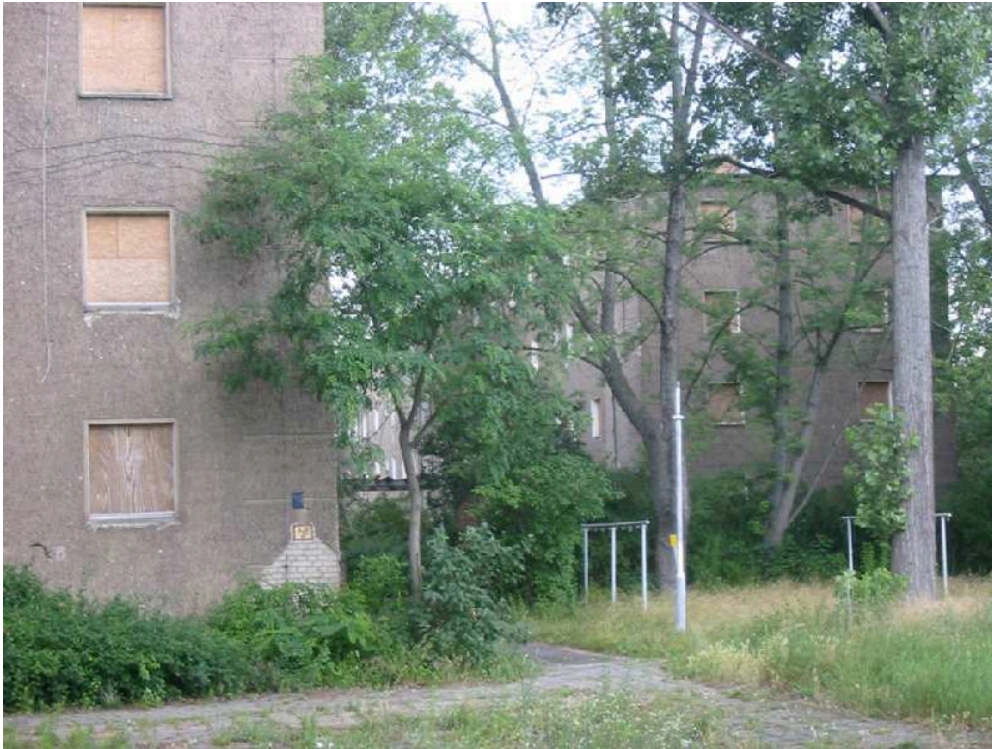
Photo : Eisenhüttenstadt, barres de logements vacants à Eisenhüttenstadt, 2007.
