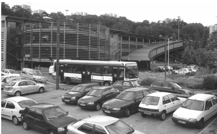
Figure n°7 : Parc relais en silo au pôle d'échanges de Gorge de Loup (Lyon)
