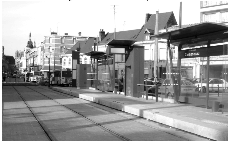
Figure 6 : Le chantier du tramway de Valenciennes (station Clemenceau, janvier 2006)
