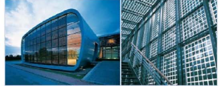
Murs-rideaux en modules au silicium multicristallin
