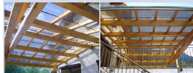
Verrière photovoltaïque à modules semi-transparents au silicium en couche-mince
