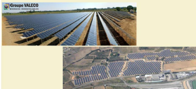
Vues globales de centrales au sol fixes à Lunel (34) (gauche) et à Narbonne (11) (droite)
