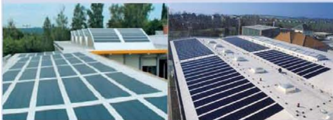
Toitures-terrasses recouvertes de membranes d'étanchéité photovoltaïques
