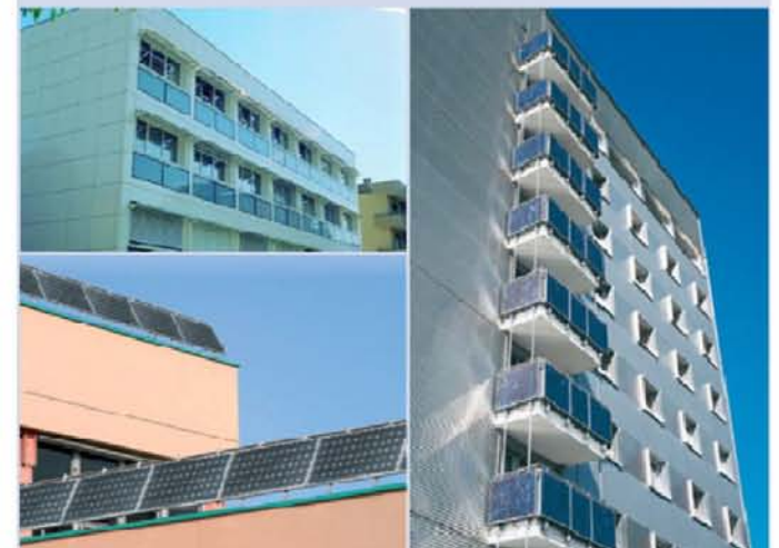
Garde-corps photovoltaïques de fenêtre au silicium en couche-mince (haut gauche), de toiture-terrasse au silicium monocristallin (bas gauche) et sur balcon au silicium multicristallin (droite)
