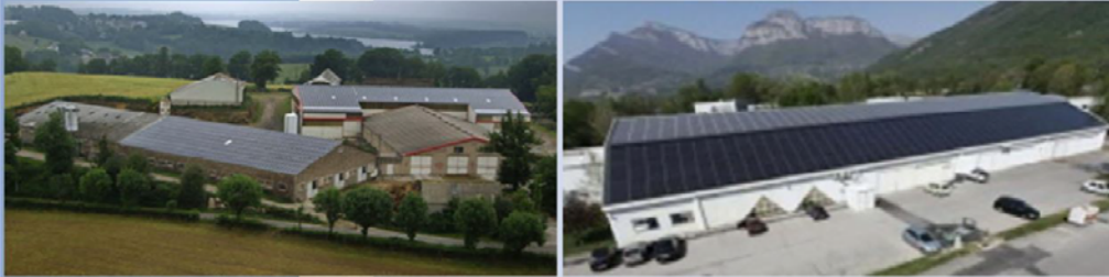
Modules photovoltaïques en toiture d'une exploitation agricole à Salles-Curan (12) (gauche) et en toiture d'un complexe sportif à Challes-les-Eaux (73) (droite)
