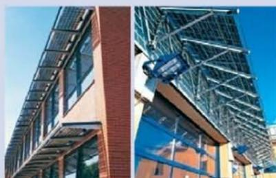
Brise-soleil à modules semi-transparentes au silicium monocristallin
