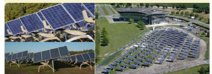
Centrale au sol sur deux axes de Bordeaux-Montesquieu à Martillac (33)
