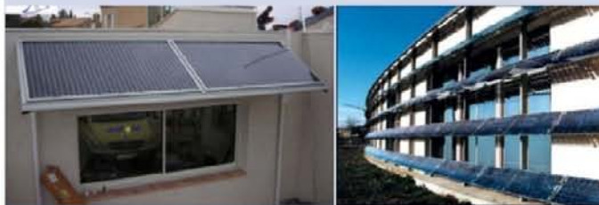
Brise-soleil à modules classiques au silicium monocristallin (gauche) et multicristallin (droite)
