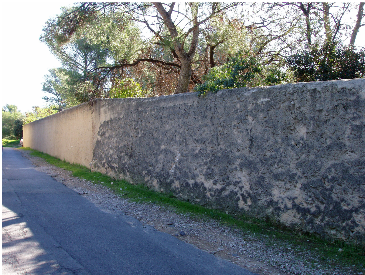
Document 9: Jonction de l'ancien mur et du mur construit au milieu des années 1980. Photo du 11 octobre 2009. © 2009 Gilles OLIVE.
