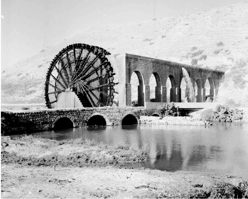
PHOTO. 2. — Ouvrage de deux norias à Acharné, en amont du Ghab, en 1932. (Cliché de l'IFPO-Damas).
