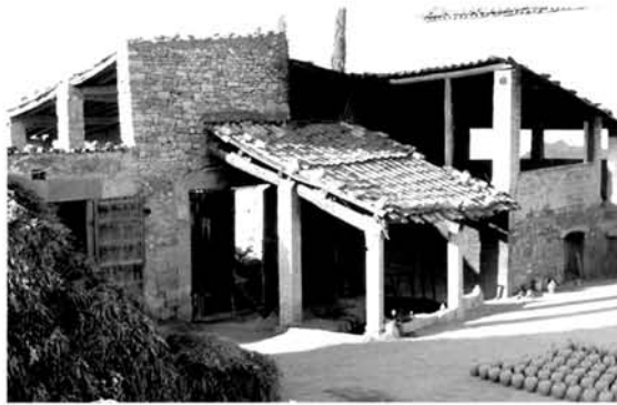
fig. 1 – Le four de Josep Font Forcat à Verdú (Lleida, Catalogne). a: vue extérieure (porte de chargement de la chambre supérieure de cuisson à droite et fosse d'accès au foyer sous auvent au milieu), b: en arrière du foyer, sagén (table) avec quatre pilettes de protection de la charge dont on voit la trace sur la paroi du fond (clichés J.T.).
