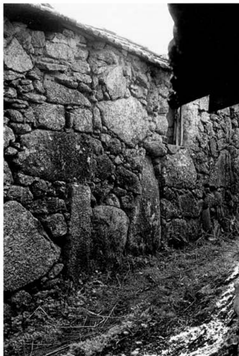
Fig. 12: La façade sud-ouest avec la fenêtre ultérieure de la cuisine/atelier et la trace de l'angle initial du premier bâtiment. Cliché JT.
