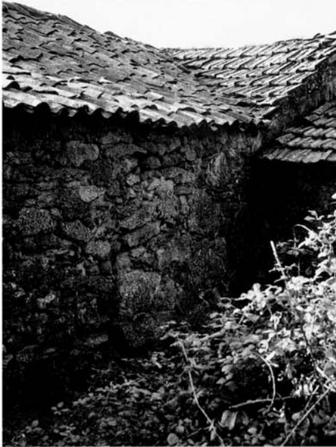
Fig. 13: Le mur nord de cette dernière extension montre le changement de sens de la toiture de la cuisine/atelier et sa surélévation. Cliché JT.
