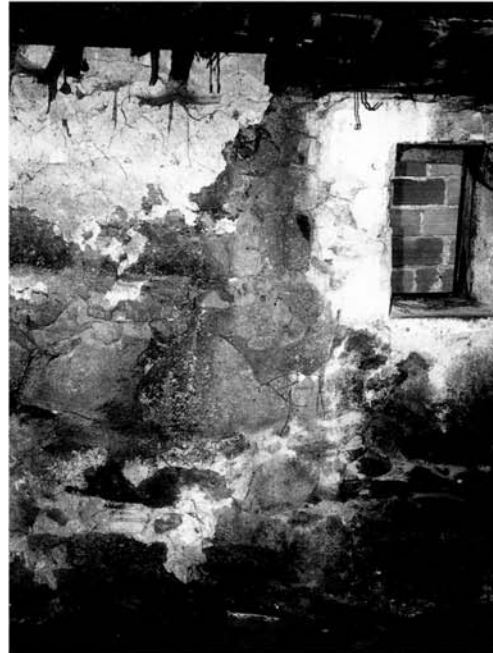
Fig. 14: L'atelier de la «cuisine» est remplacé par une chambre (trace de la cloison sur le mur, mur de fondation de la cloison) et une cuisine avec plancher. Cliché JT.
