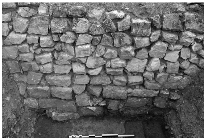
Fig. 226. Vue depuis le sud du parement externe de l'enceinte primitive (MR71217) (Cliché : E. Gailledrat).
