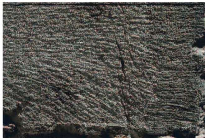
Figure 22. Bloc de l'embrasure est : impacts de marteau taillant et ciselure périmétrale (cliché A. Hartmann-Virnich, 2002)
