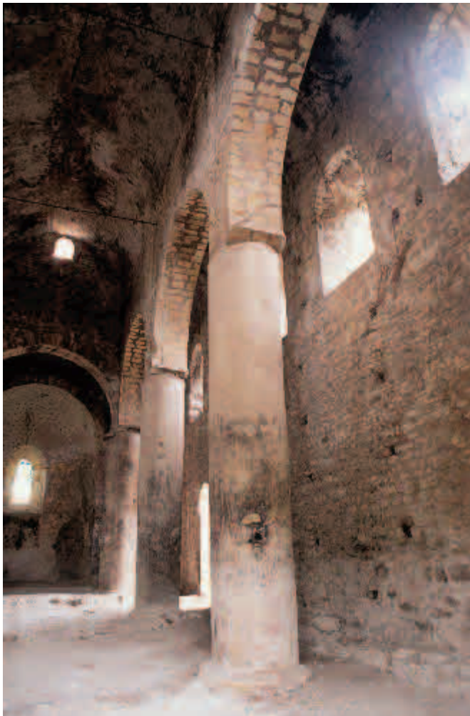
Fig. 1. Saint-Donat-de-Montfort : intérieur de la nef (cl. A. Hartmann-Virnich)
